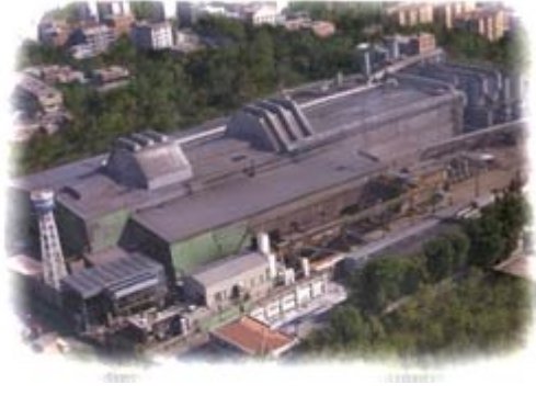
Şekil 6.8: Biga İçdaş Tesisine Ait Genel Görünüş
