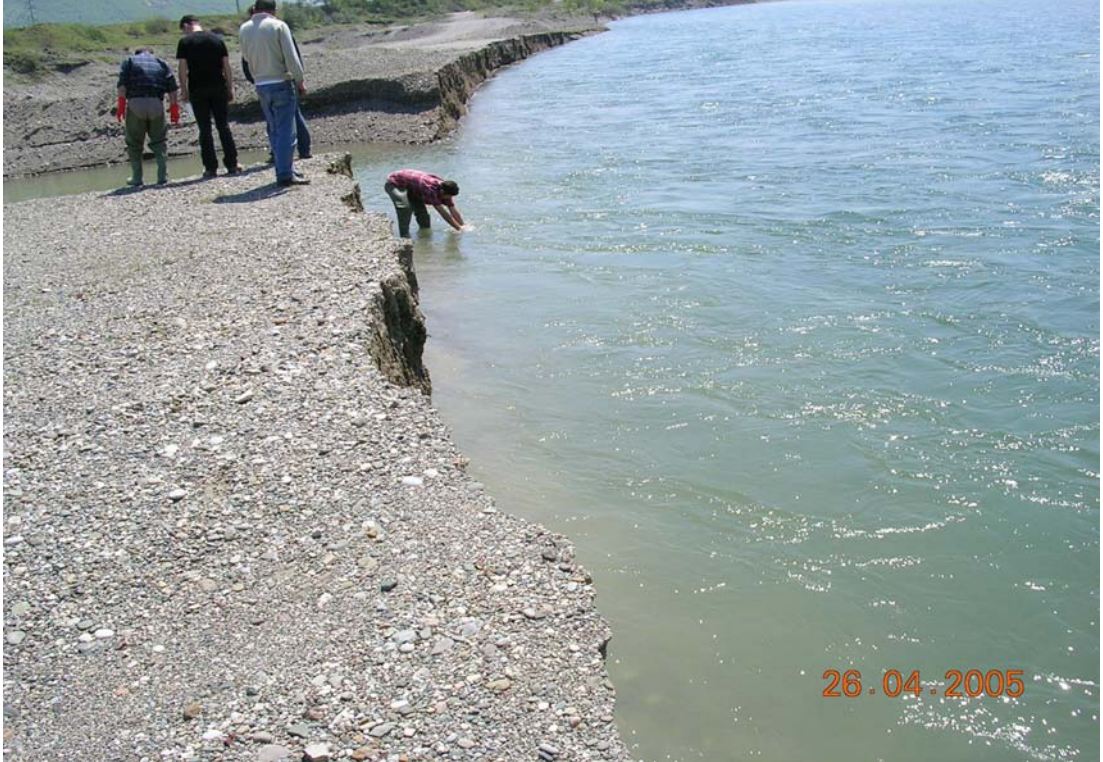
Şekil (Fotoğraf) 3.3b. Kızılırmak Yatağından İnşaat Materyali Çekilmesi Sonucu Kıyı Erozyonuna Maruz Kalan İstasyon Noktalarından Biri (N4)
