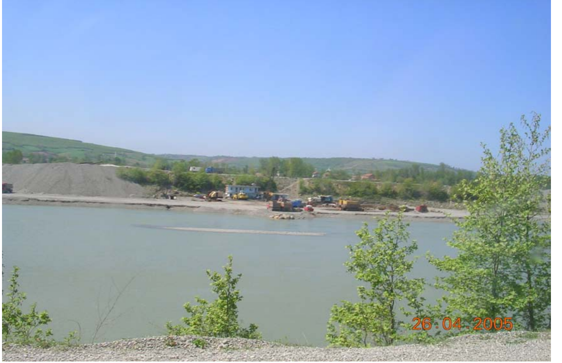
Şekil (Fotoğraf) 3.3a. Kızılırmak Yatağındaki Malzemeyi Kullanan Beton-İnşaat Şantiyelerinden Biri
