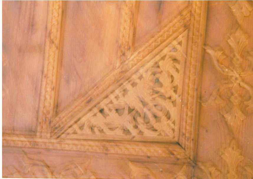
Fotoğraf 502: Sancaktar Evi, Ara Kat Yazodası Tavanı, Güneybatı Köşe Üçgen Bezeme Detayı
