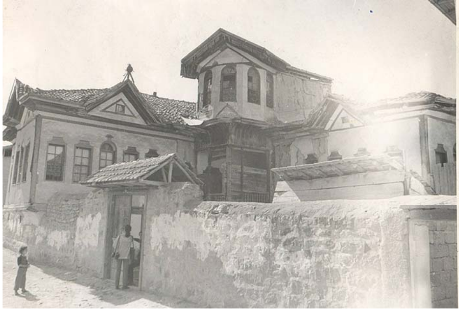
Fotoğraf 274: Erçokluzâde Evi Kuzeydoğudan Görünüşü 98
