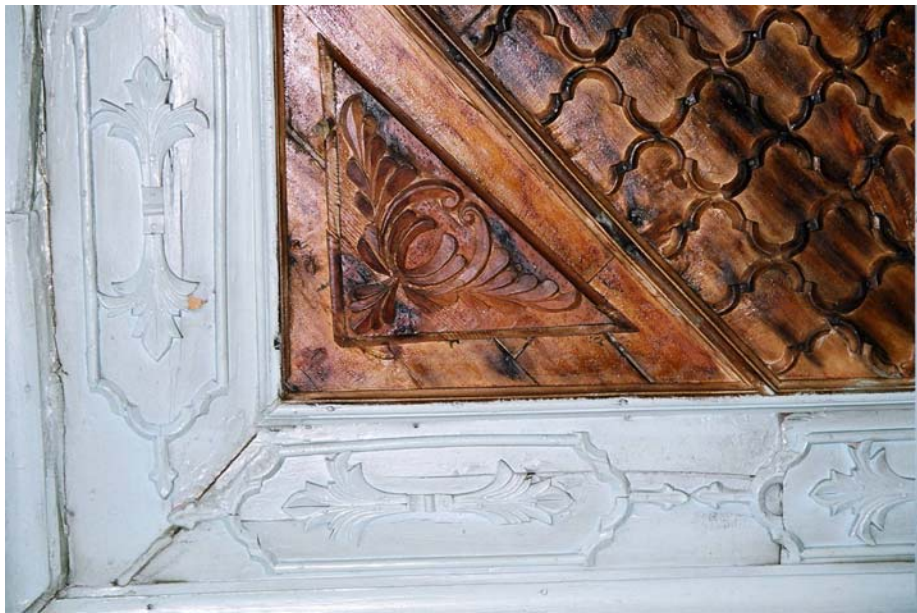
Fotoğraf 304: Tevrüzlü Konağı, Selamlık Bölümü, Yazodası Tavanı, Kuzeydoğu-Güneybatı Köşeler Üçgen Bezeme Detayı
