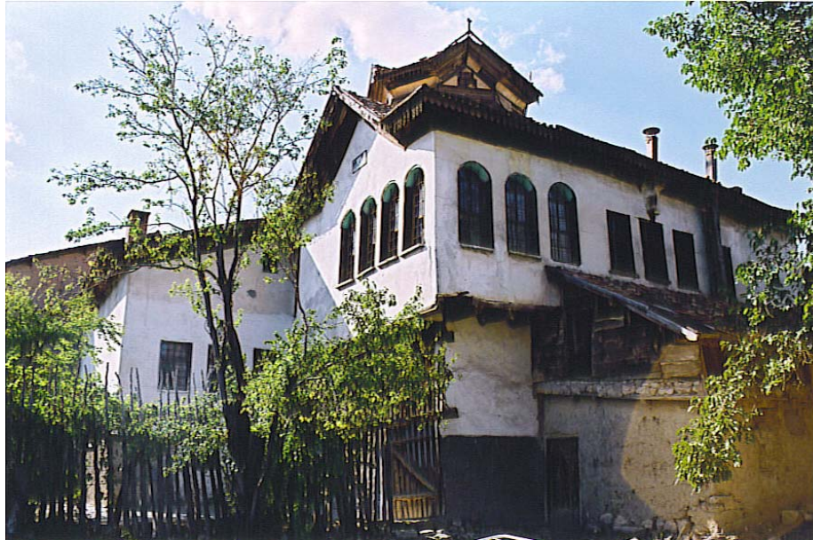
Fotoğraf 292: Tevrüzlü Konağı'nın Güneydoğudan Görünüşü
