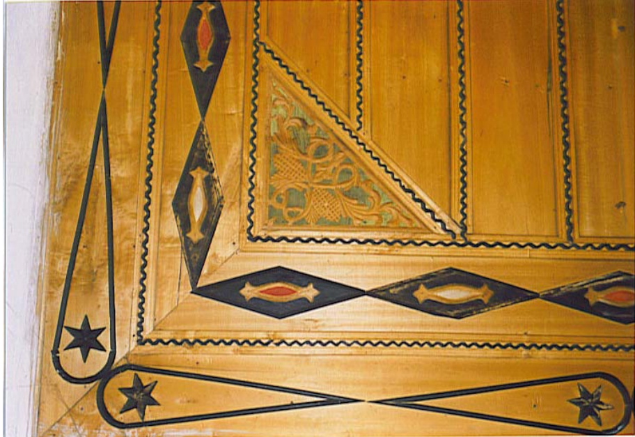
Fotoğraf 428 : Şeyhoğlu Evi, Kışodası Tavanı, Güneydoğu Köşe Üçgen Bezeme Detayı
