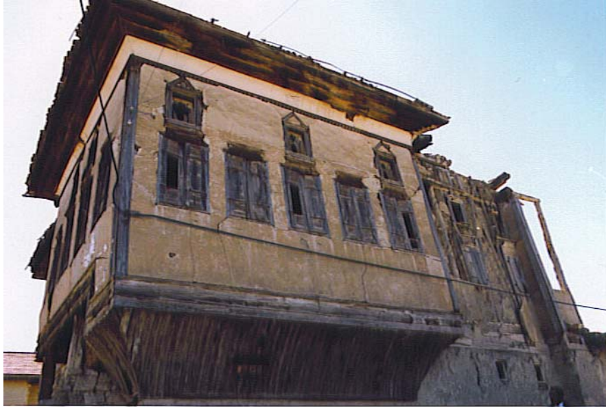
Fotoğraf 139: A'yan Ağa Konağı, Selamlık Bölümü, Yazodası, Kuzeydoğudan Görünüş
