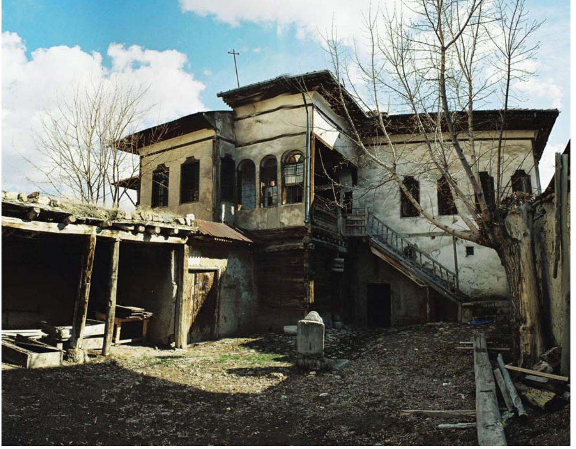
Fotoğraf 160: Mühürdarzâde Evi, Avludan Kuzey Cephenin Görünüşü
