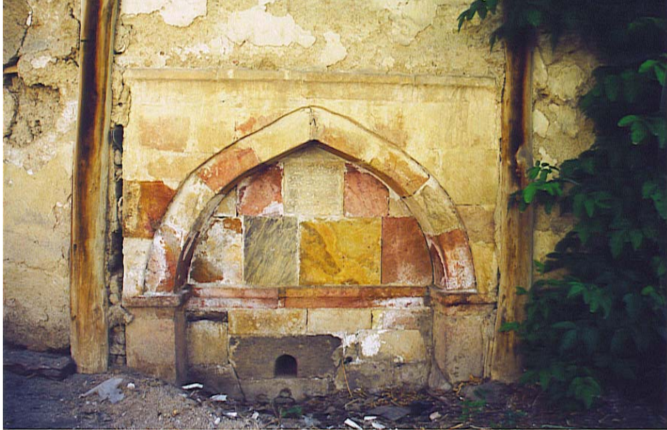
Fotoğraf 159: Mühürdarzâde Evi, Avlu Duvarında Bulunan Çeşme
