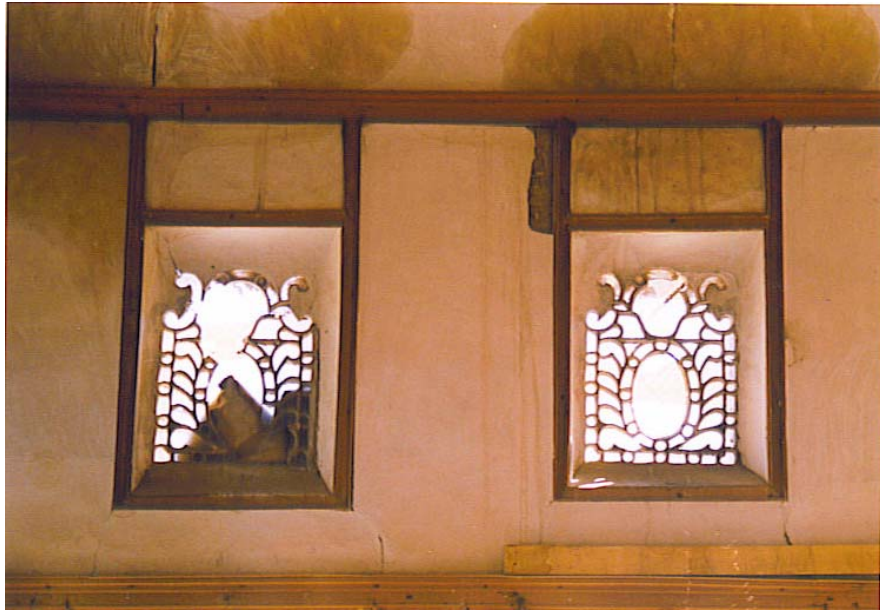
Fotoğraf 141: A'yan Ağa Konağı, Selamlık Bölümü, Yazodasında Bulunan Alçı Şebekeli Tepe Pencereleri
