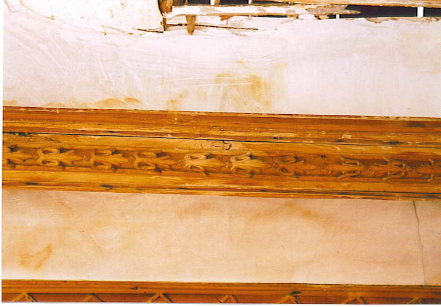
Fotoğraf 156: A'yan Ağa Konağı, Selamlık Bölümü, Kışodası Tavanı, Kiriş Alnında Yer Alan Bezeme
