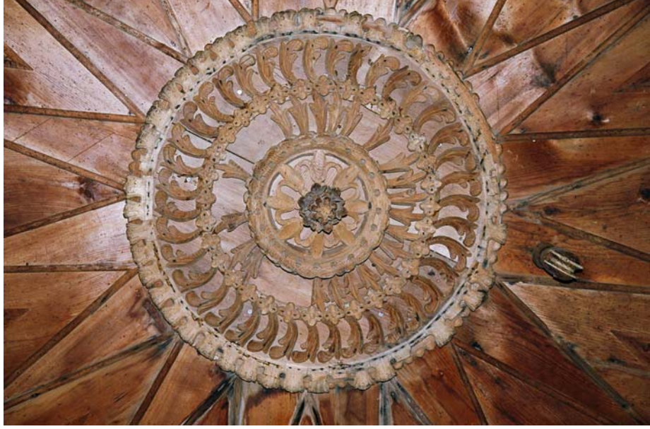
Fotoğraf 145: A'yan Ağa Konağı, Selamlık Bölümü, Yazodası Tavanı, Göbek Detayı
