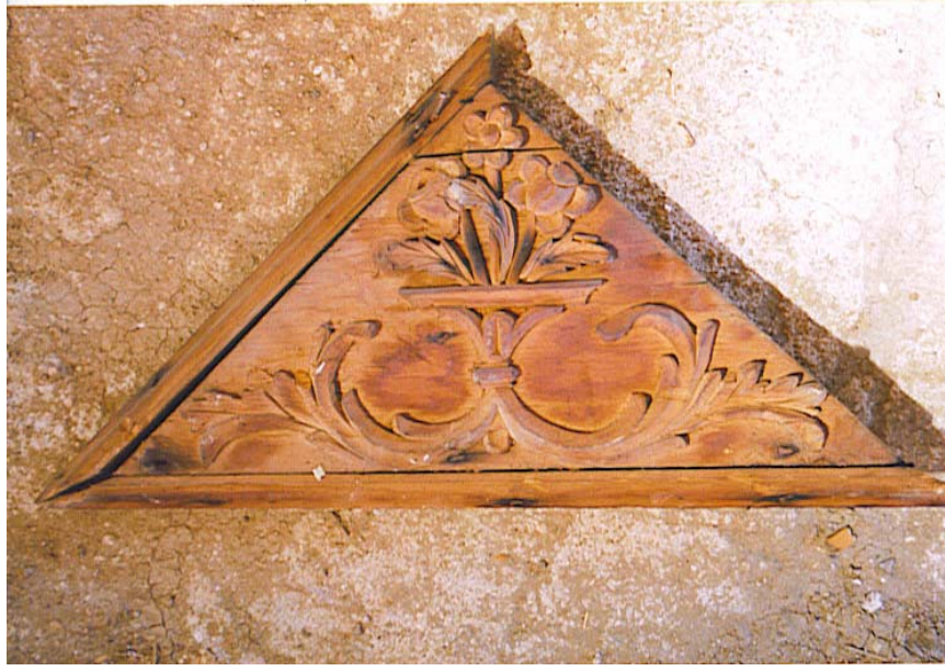
Fotoğraf 148: A'yan Ağa Konağı, Selamlık Bölümü, Yazodası Tavanı, Kuzeydoğu-Güneybatı Köşe Üçgen Bezeme Detayı
