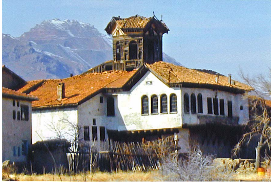
Fotoğraf 291: Tevrüzlü Konağı'nın Güneydoğudan Görünüşü
