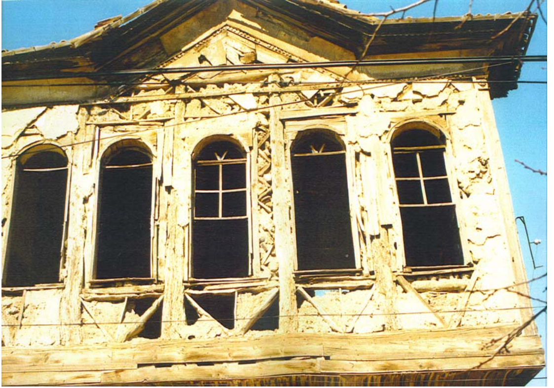
Fotoğraf 259: Abdullah Paşa Konağının Güney Cephesinde Yer Alan Başoda Pencereleri
