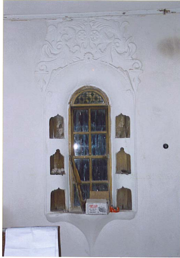
Fotoğraf 503: Sancaktar Evi, Birinci Kat Yazodasında Alçı Çiçeklik
