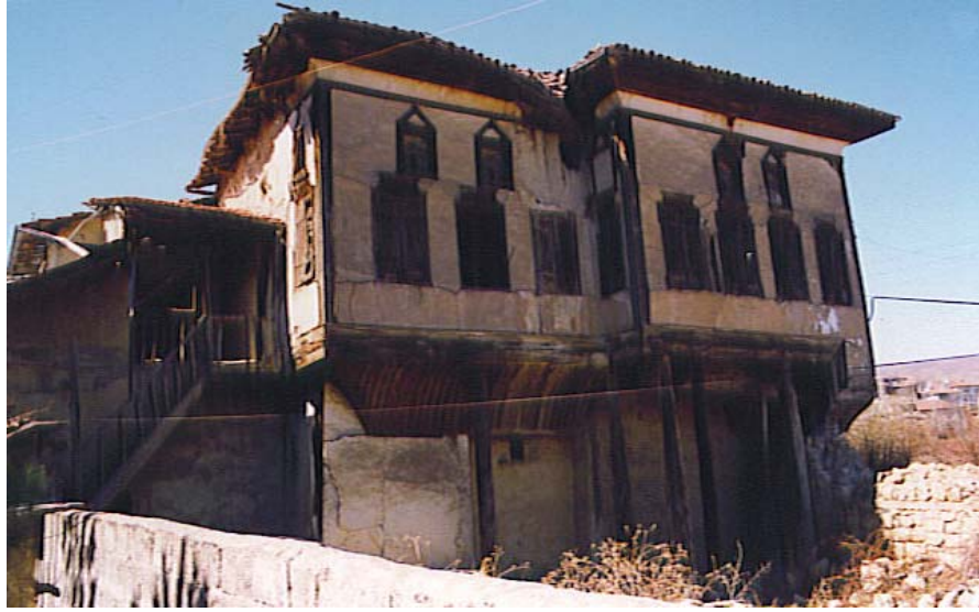
Fotoğraf 133: A'yan Ağa Konağı, Selamlık Bölümü, Güneydoğudan Görünüş
