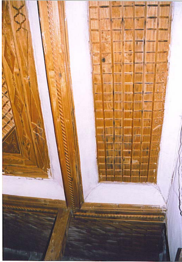
Fotoğraf 495: Sancaktar Evi, Zemin Kat Kışodasında Aşağıdaki Tavanı
