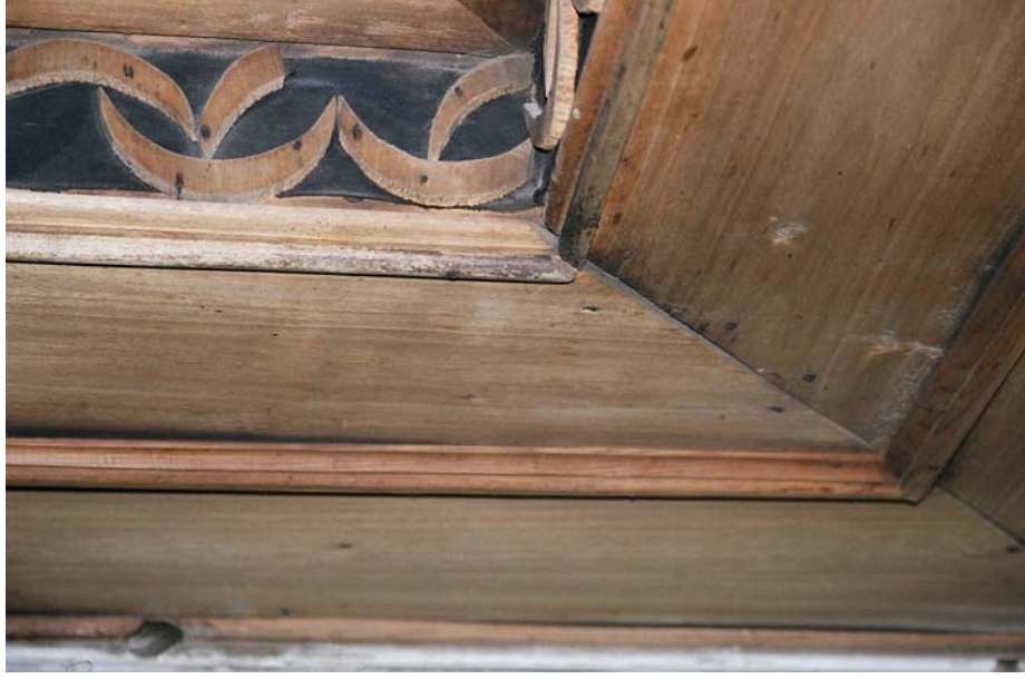
Fotoğraf 239: Tırampacıgil Evi, Selamlık Kışodası Tavanı, Çökertme Alnında Yer Alan Bezeme Detayı
