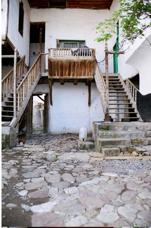
Fotoğraf 293: Tivrüzlü Konağı Avlu İçinden Görünüş
