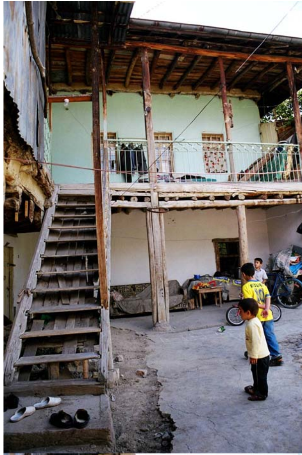
Fotoğraf 455: İslamgil Evinin Kuzey Cephesi
