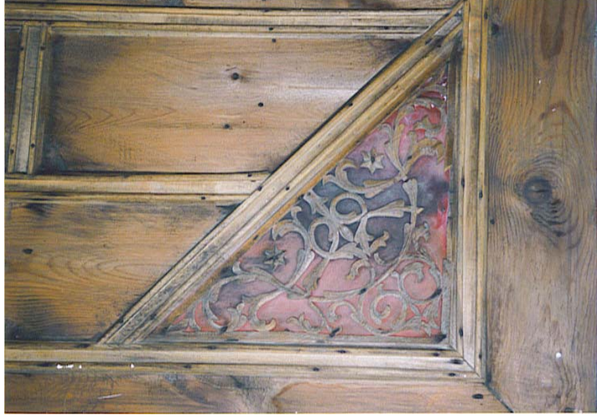
Fotoğraf 509: Sancaktar Evi, Birinci Kat Yazodası Tavanı Güneydoğu Köşe Üçgen Bezeme Detayı
