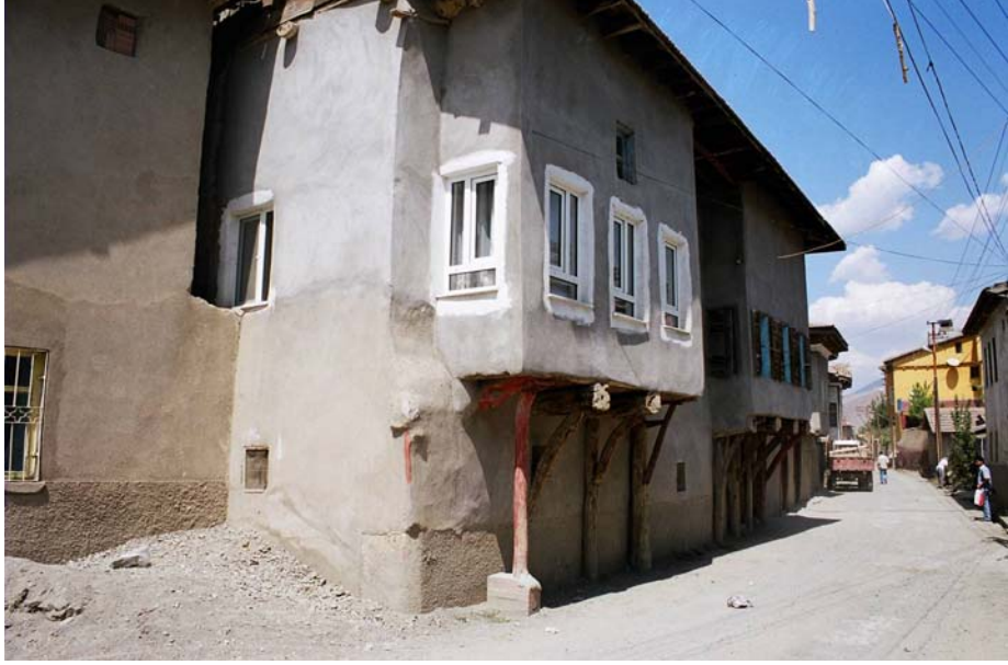
Fotoğraf 212: Topçugil Evi'nin 19. yy Ortalarında Yapılan Bölümünün Güneydoğudan Görünüşü.
