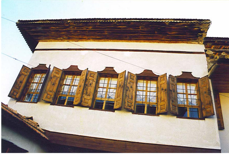
Fotoğraf 28: Yılkıran Evi yazodası pencereleri ve kepenkleri
