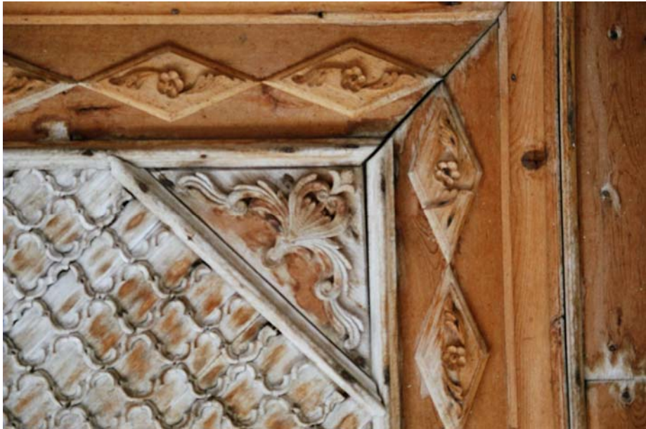
Fotoğraf 220: Topçugil Evi, Yazodası Tavanı, Kuzeydoğu ve Güneybatı Köşe Üçgen Bezeme Detayı
