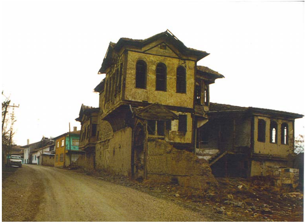
Fotoğraf 255: Abdullah Paşa Konağı, Güneydoğudan Görünüşü
