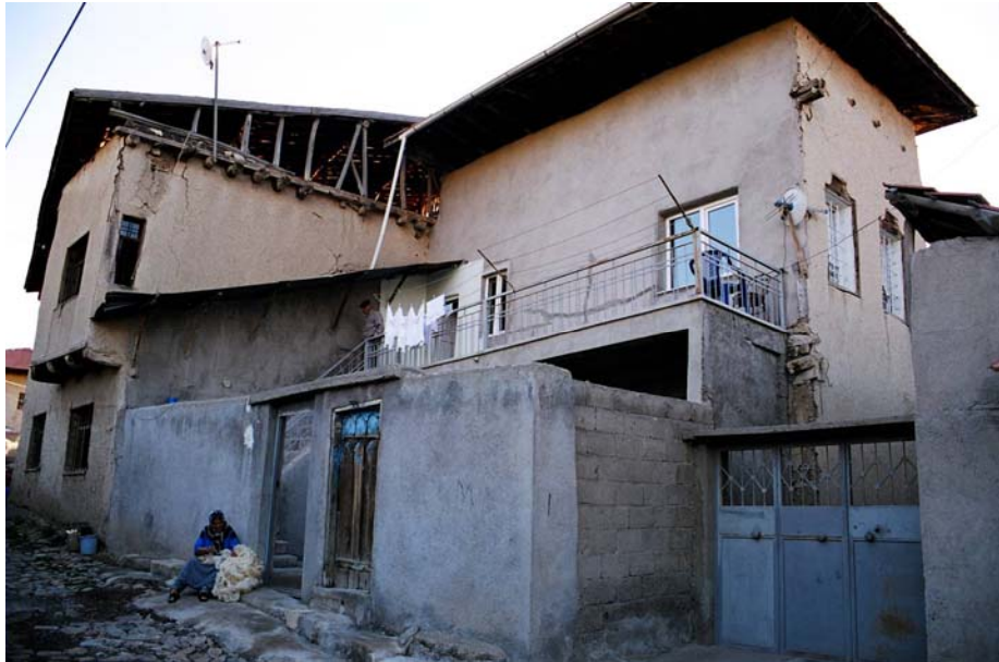
Fotoğraf 335: Recep Tuhutluoğlu Evi Doğudan Görünüşü
