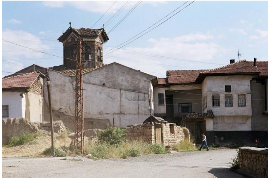
Fotoğraf 290: Tevrüzlü Konağı'nın kuzey cepheden görünüşü.
