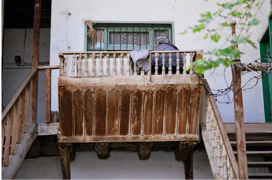
Fotoğraf 294: Tevrüzlü Konağı, Selamlık Önünde Yer Alan Küçük Divanhanenin Köşkü
