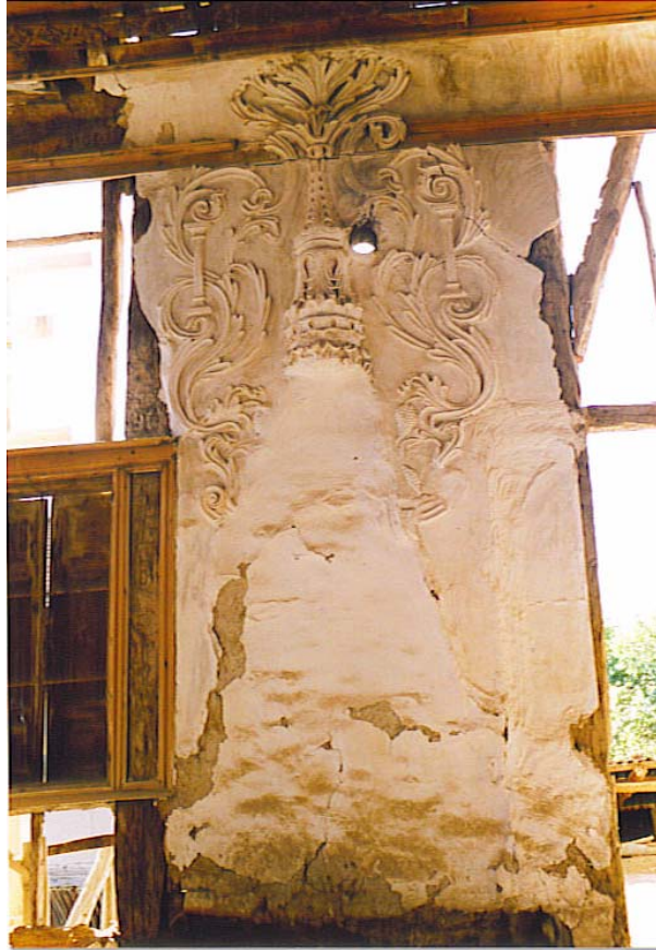
Fotoğraf 150: A'yan Ağa Konağı, Selamlık Bölümü, Kışodasında Bulunan Alçı Ocak Yaşmağı Süslemesi
