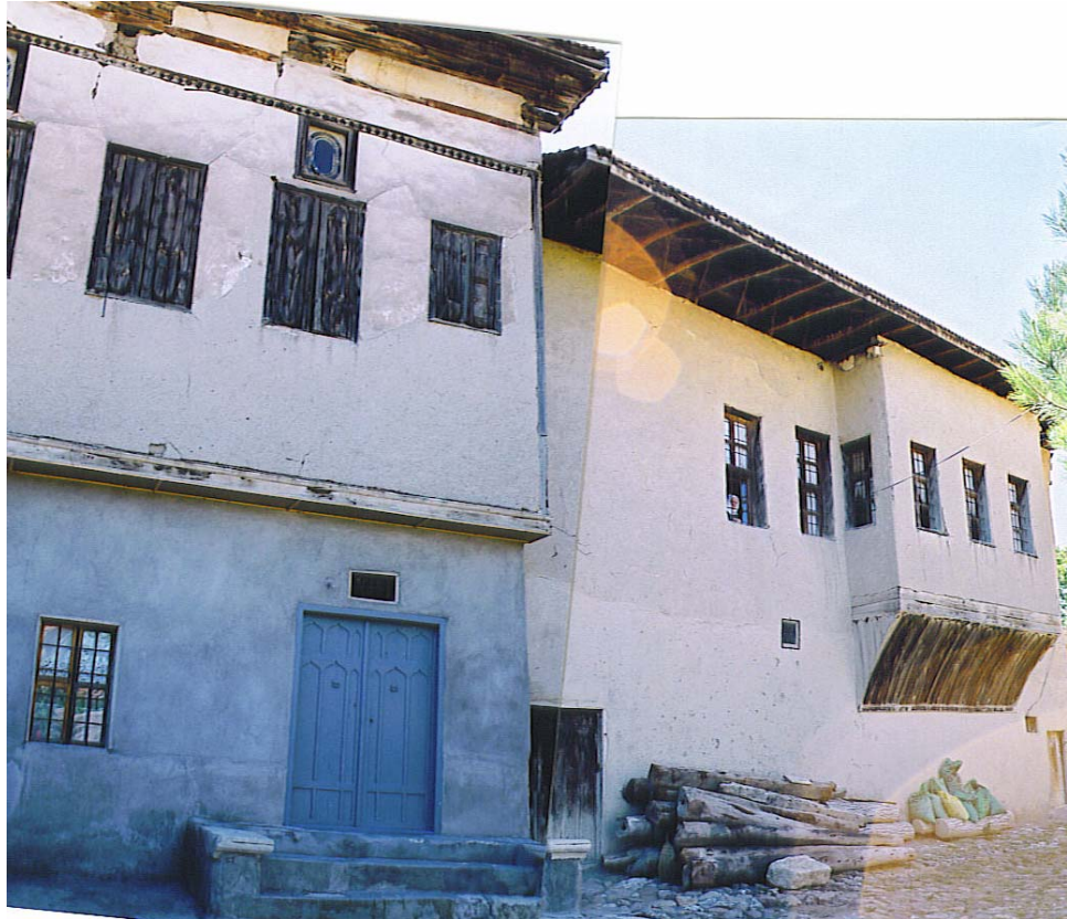
Fotoğraf 135: A'yan Ağa Konağı, Mabeyn Kısımında Bulunan İkinci Konutun Avludan Görünüşü
