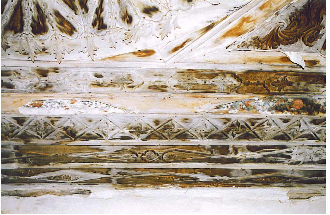
Fotoğraf 513 : Tuhut Köyünde bulunan evin oda tavanı detayı
