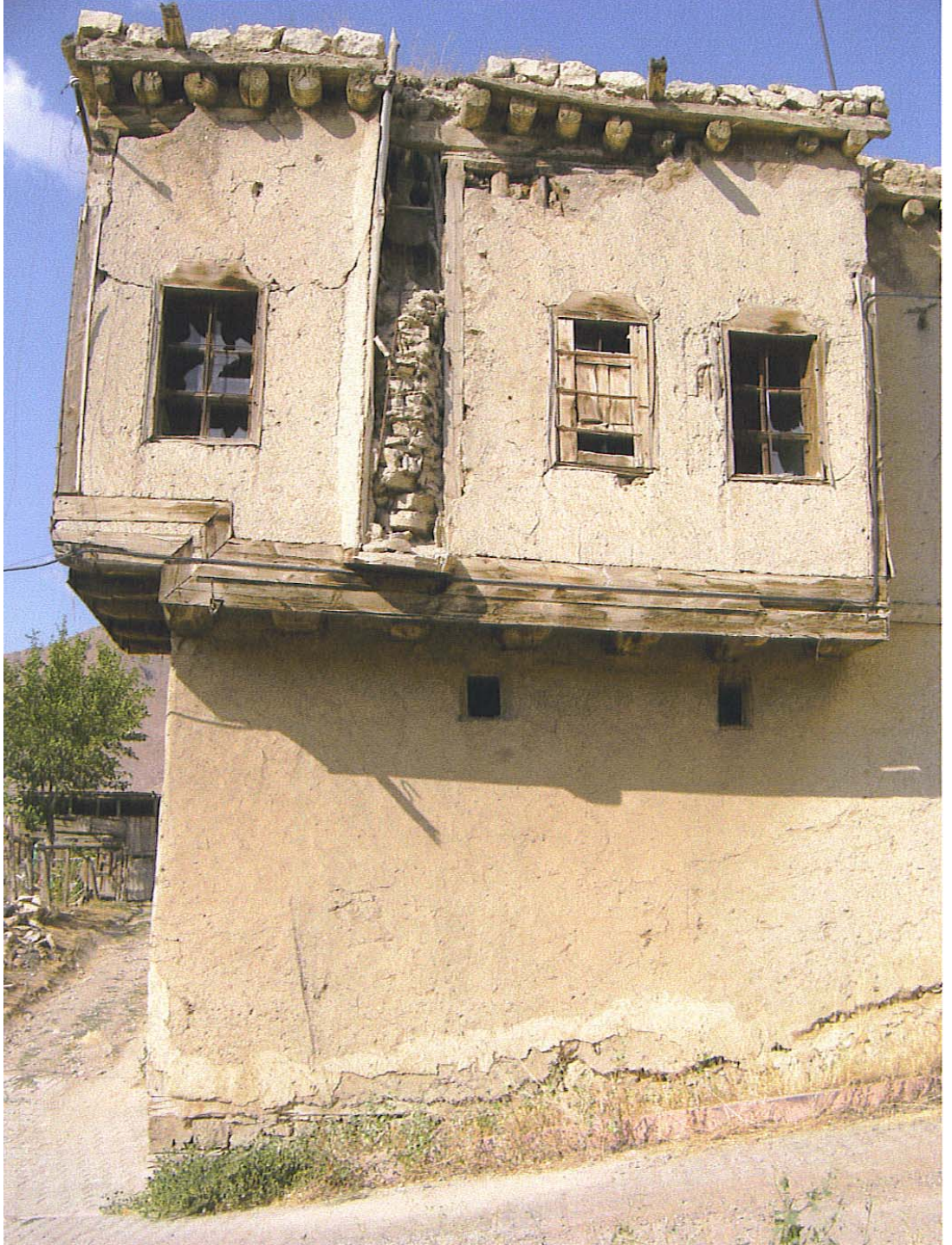
Fotoğraf 95: Edegiller Evi, başoda güney cephesi
