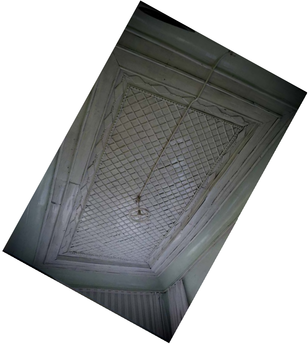
Fotoğraf 347: Recep Tuhutluoğlu Evi, Küçük Oda Tavanı
