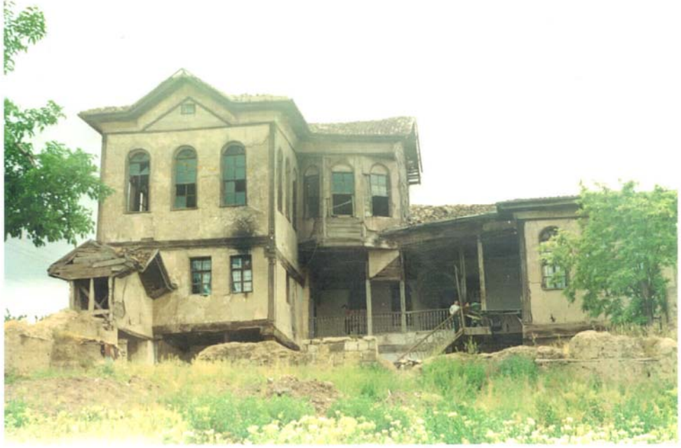
Fotoğraf 258: Abdullah Paşa Konağı, Doğudan Görünüşü
