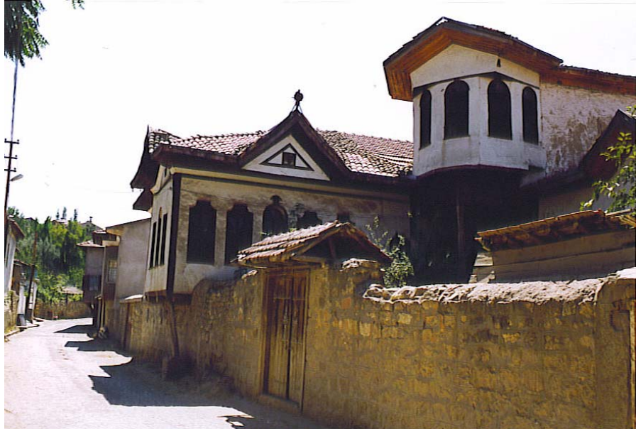
Fotoğraf 273: Erçokluzâde Evi Kuzeydoğudan Görünüşü
