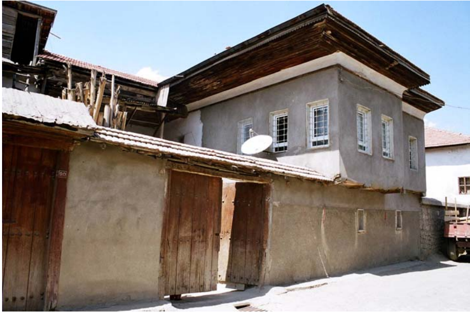
Fotoğraf 213: Topçugil Evi'nin 20.yy Ortalarında Yapılan Bölümünün Güneydoğudan Görünüşü.
