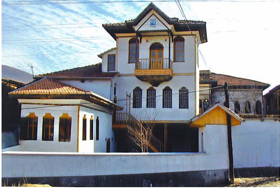
Fotoğraf 486: Sancaktar Evi, Restorasyon Çalışmaları Büyük Oranda Tamamlanmış
