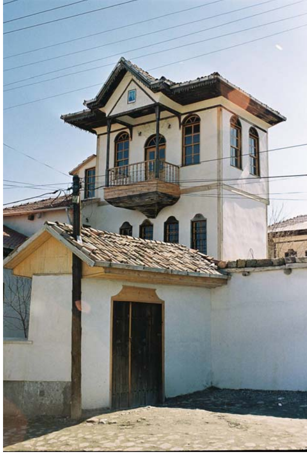
Fotoğraf 487: Sancaktar Evi, Restorasyon Çalışmaları Büyük Oranda Tamamlanmış
