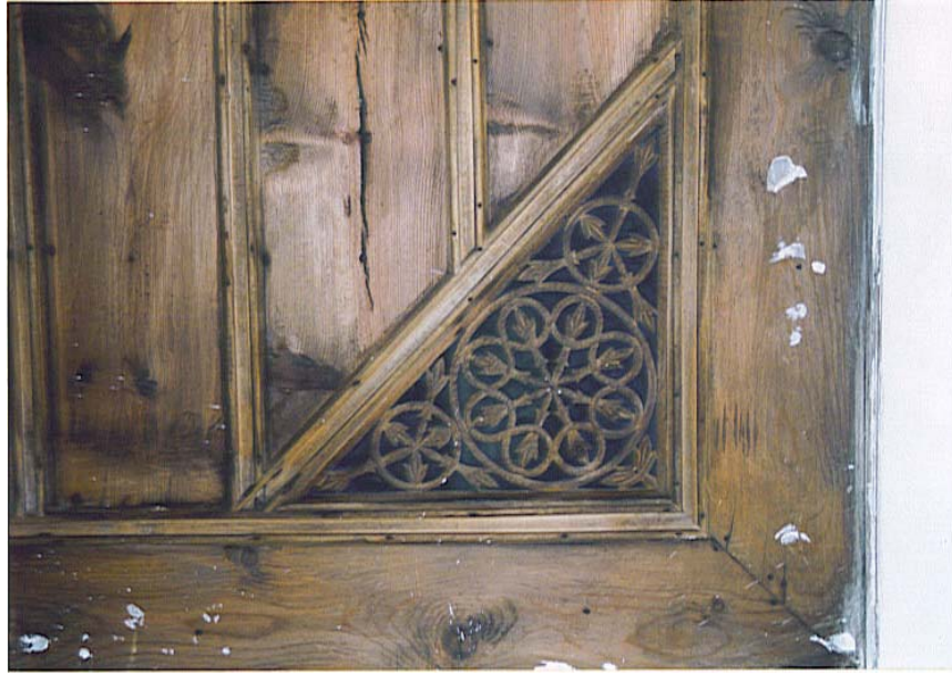
Fotoğraf 506: Sancaktar Evi, Birinci Kat Yazodası Tavanı, Kuzeybatı Köşe Üçgen Bezeme Detayı
