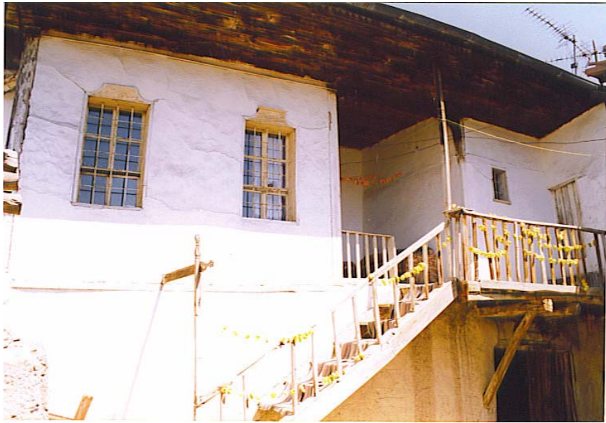
Fotoğraf 234: Tırapacıgil Evinin Güney Cephesi, Avlu İçinden Görünüşü
