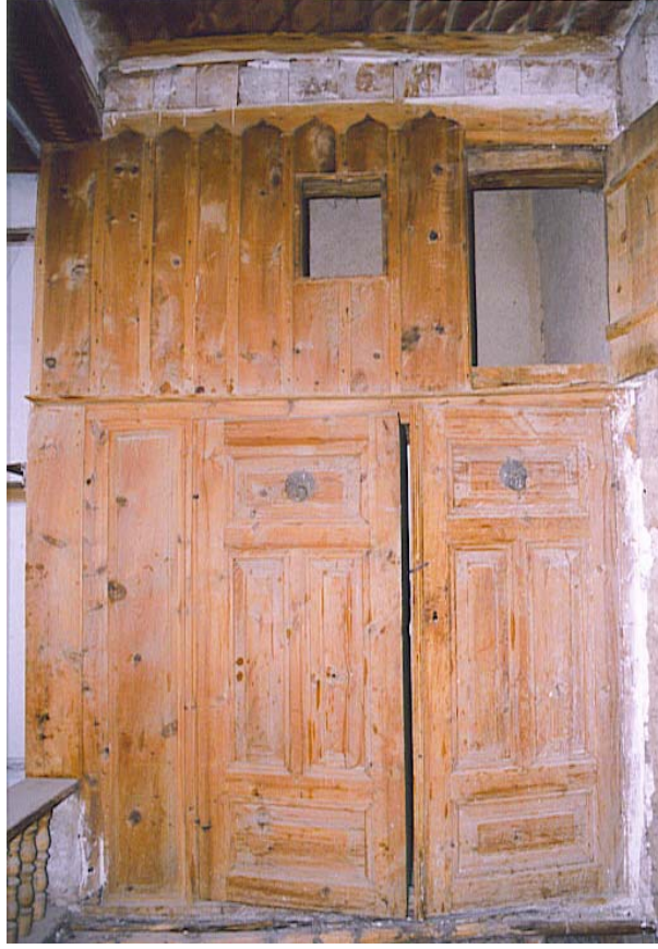
Fotoğraf 489: Sancaktar Evi, Zemin Kat Kışodasında Nimseki Bölümünde Yer Alan Dolap
