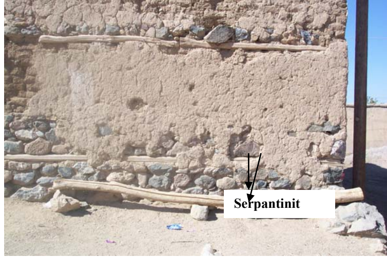
Şekil 4.77. Yapı malzemesi olarak kullanılan serpantinit kayacı
