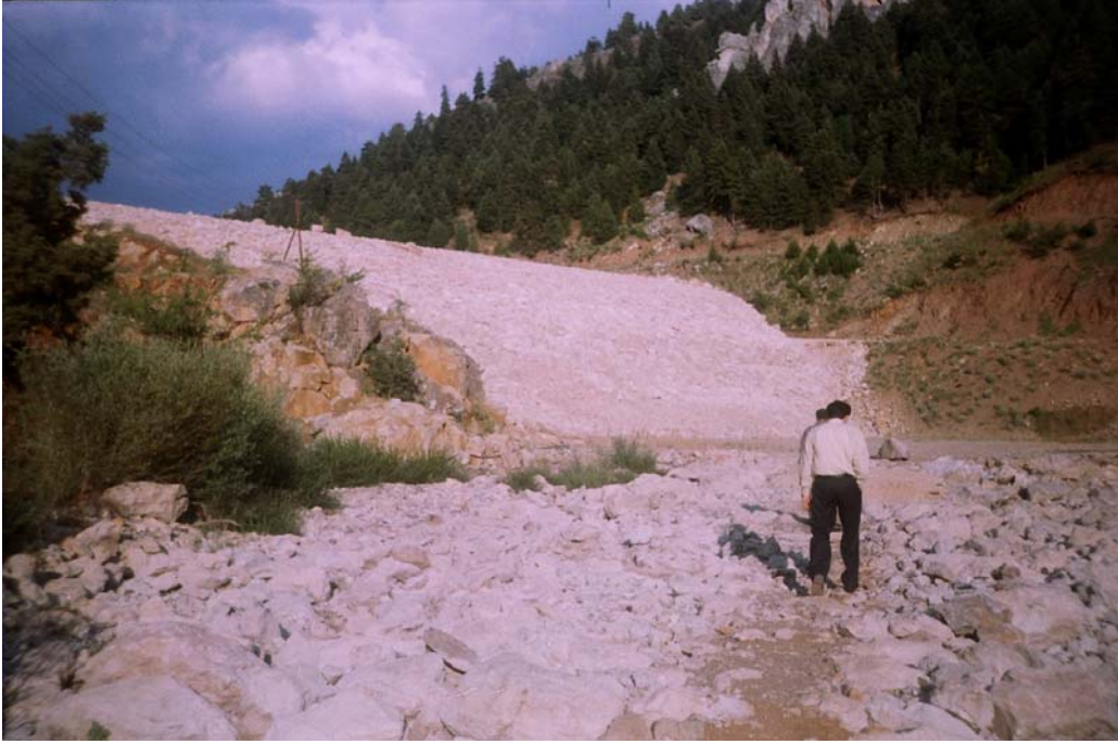
Foto 19: Derebucak'ın güneydoğusunda inşa halinde olan Derebucak Barajı'nın kaya dolgu gövdesi.
