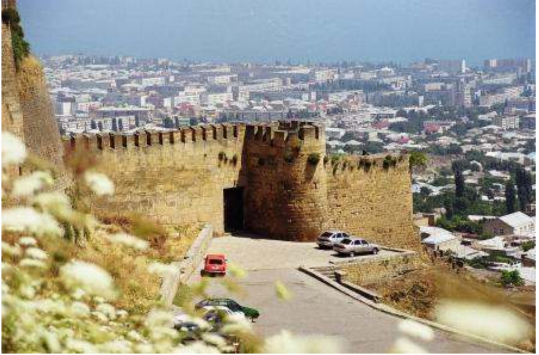
Kale'den Derbent'in Görünüşü
