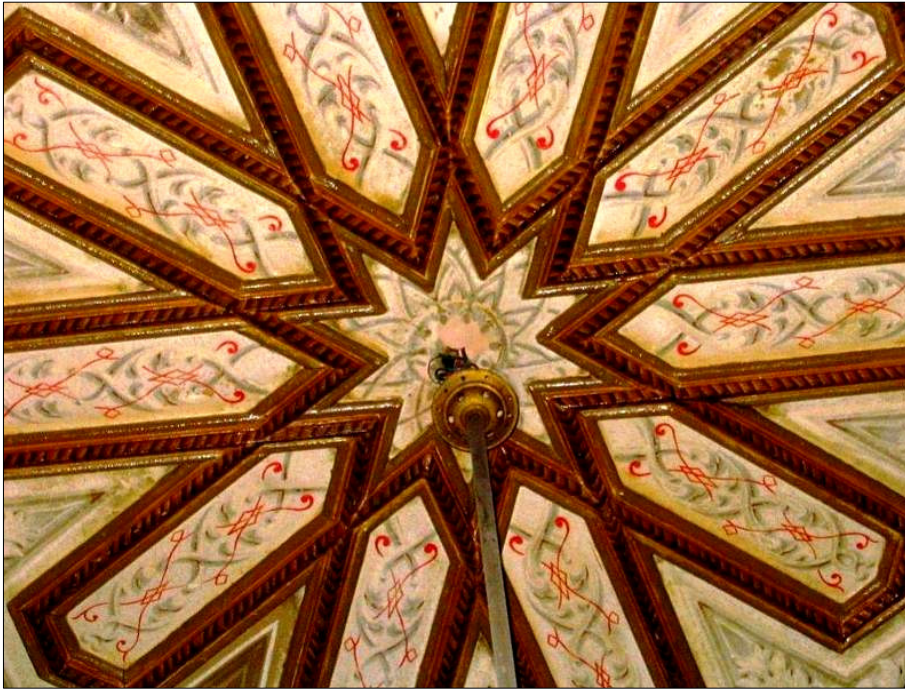
Resim-103: Seraskerlik Binası, Doktora Salonu, Batı Kanadı, Tavan Göbeği.
