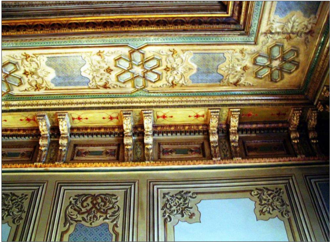
Resim – 110: Seraskerlik Binası, Birinci Kat, Güney Odası, Tavandan Duvara Geçiş.
