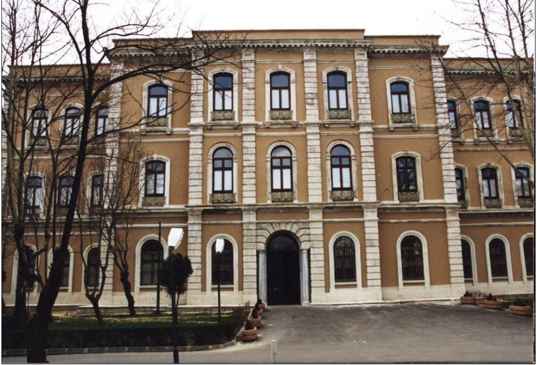
Resim -27: Seraskeri Binası Doğu Cephesi
