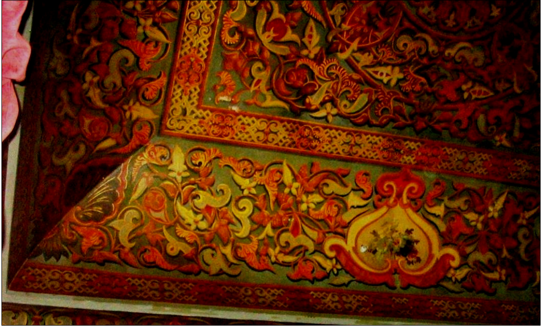
Resim – 118: Şehzadeler Dairesi, Kuzey Batı Odası, Tavandan Duvara Geçiş.
