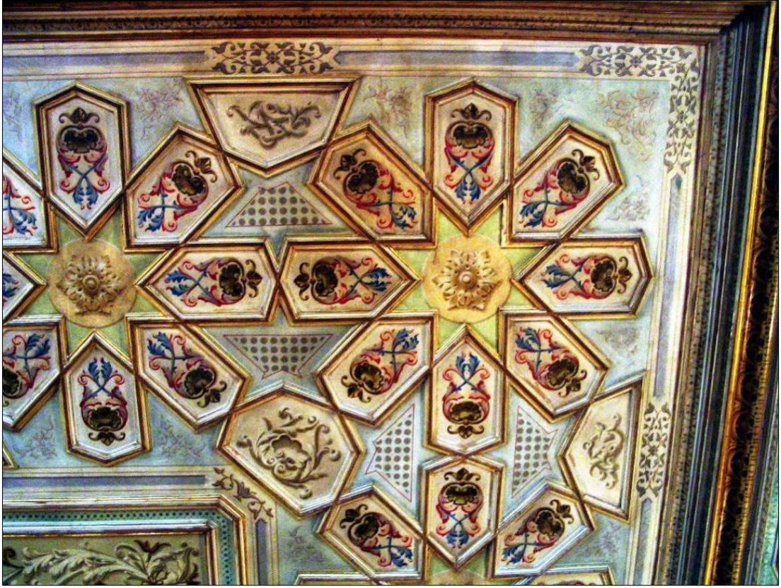
Resim – 109: Seraskerlik Binası, Birinci Kat, Güney Odası, Tavan Detayı.
