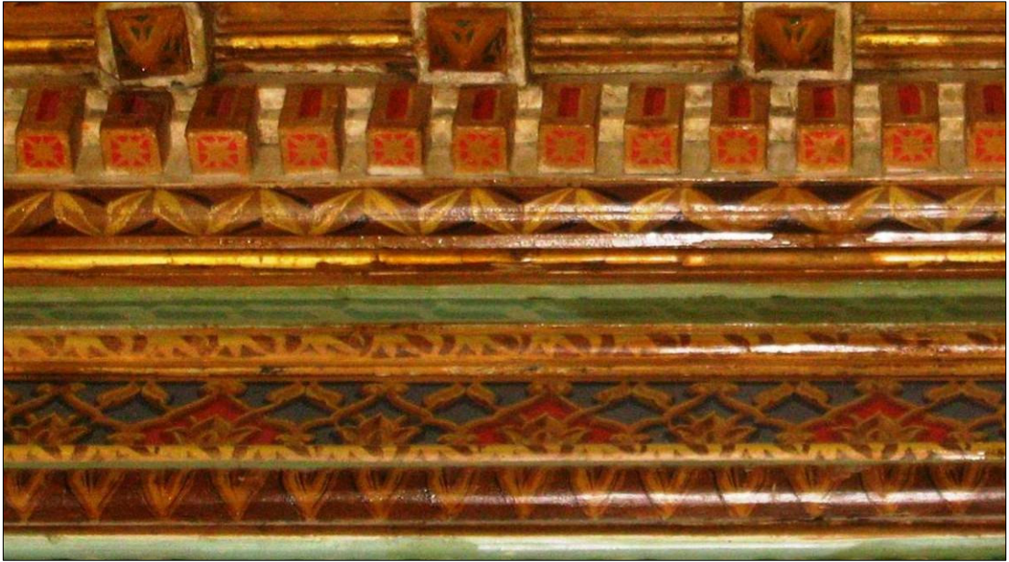
Resim-122: Seraskerlik Binası, Mavi Salon, Doğu Kanadı, ikinci Oda, Duvara Geçiş, Detay
