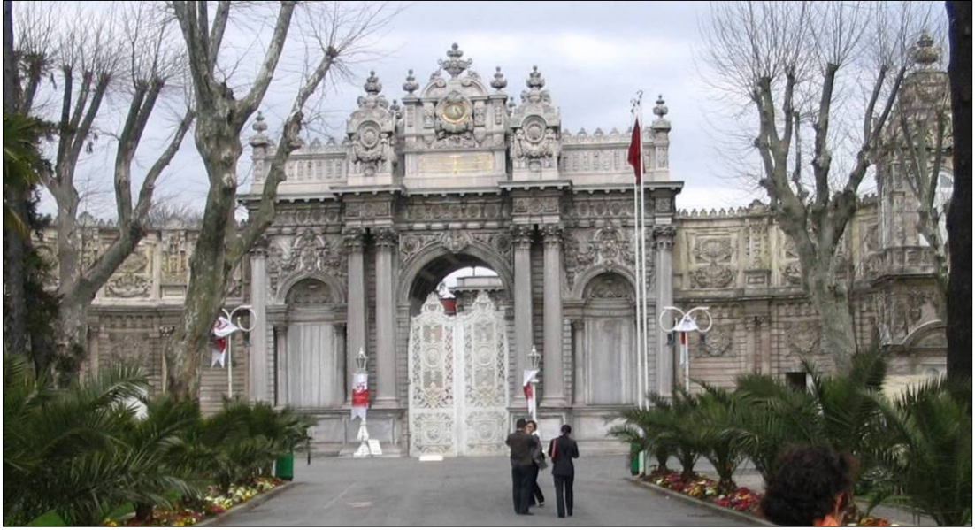
Resim – 1: Dolmabahçe Sarayı Güney Kapısı
