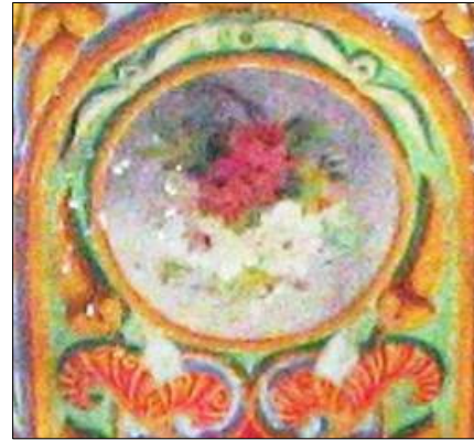
Resim-182: Biniş Dairesi, Güney Eyvanı, Tavan Yüzeyi
