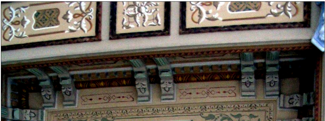
Resim – 70: Seraskerlik Binası, Galeri, Tavandan Duvara Geçiş
