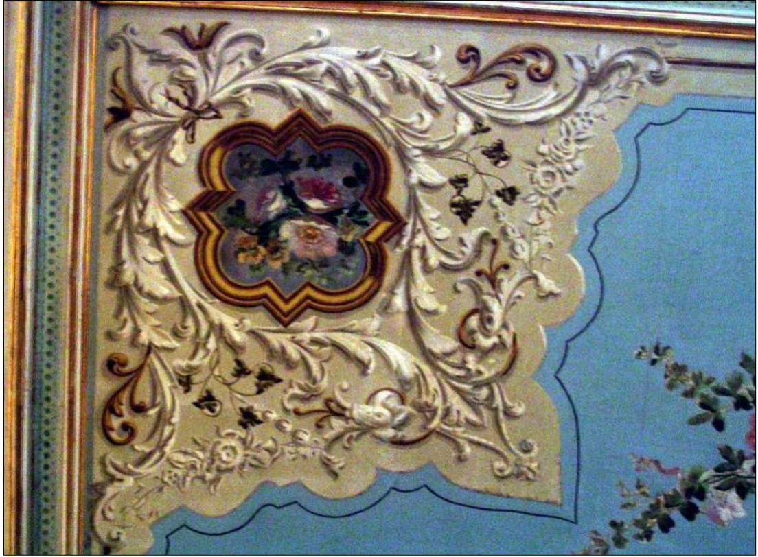
Resim – 108: Seraskerlik Binası, Birinci Kat, Güney Odası, Tavan Detayı.
