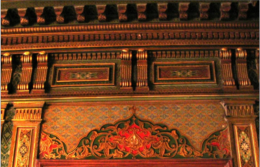
Resim–82: Seraskerlik Binası, Mavi Salon, Tavandan Duvara Geçiş ve Kapı Alınlığı.
