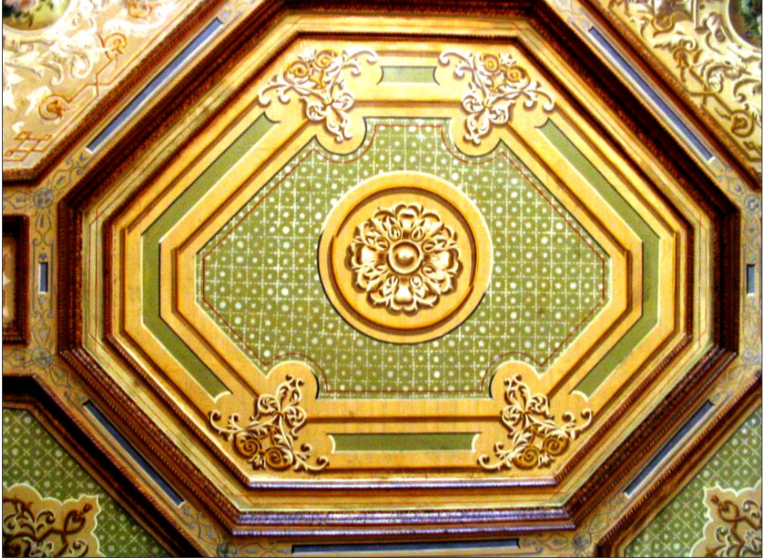
Resim-104: Seraskerlik Binası, Doktora Salonu Batı Kanadı, Kuzey Panosu.
