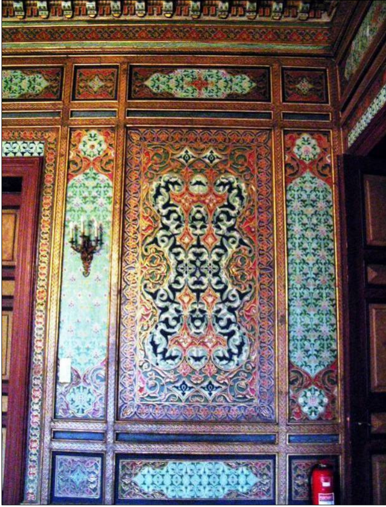
Resim – 54: Seraskerlik Binası, Mavi Salon, Batı Kanadı, Birinci Oda, Duvar Yüzeyi.
