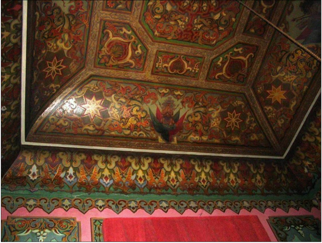
Resim – 35: Şehzadeler Dairesi, Kuzeydoğu Odası, Tavandan Duvara Geçiş
