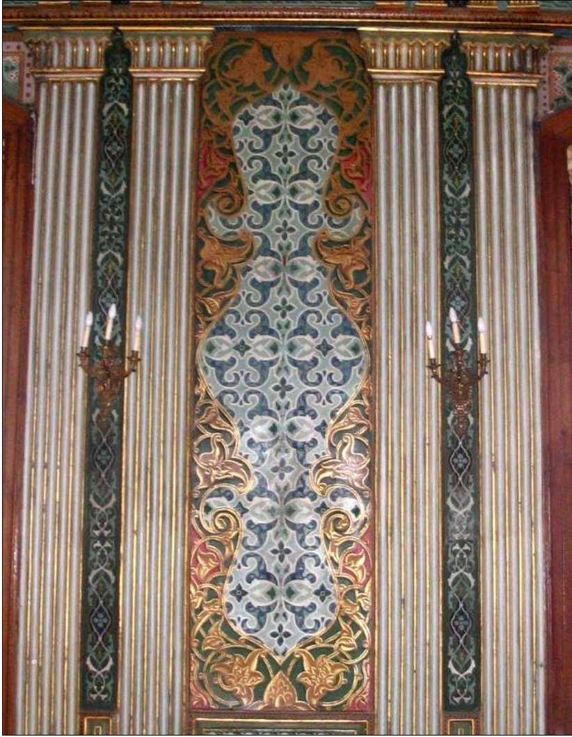
Resim-84: Seraskerlik Binası, Mavi Salon, Duvar Yüzeyi, Dar Pano.
