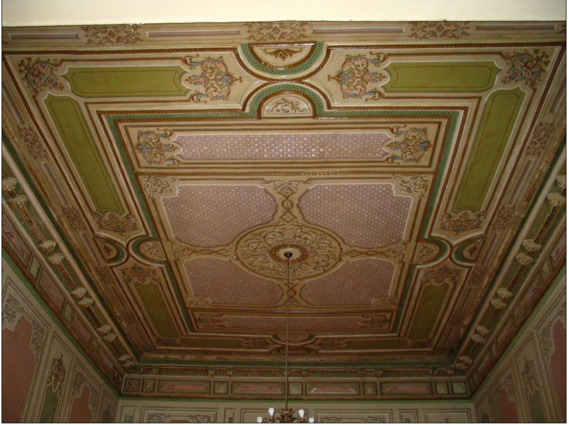
Resim – 49: Seraskeri Binası, Mavi Salon, Doğu Kanadı, Birinci Oda
