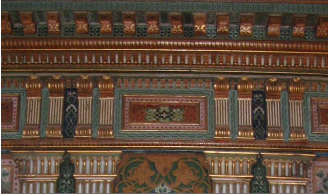
Resim – 81: Seraskerlik Binası, Mavi Salon, Tavandan Duvara Geçiş
