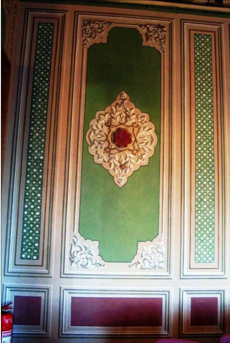
Resim – 107: Doktora Salonu Batı Kanadı, Duvar Yüzeyi.
