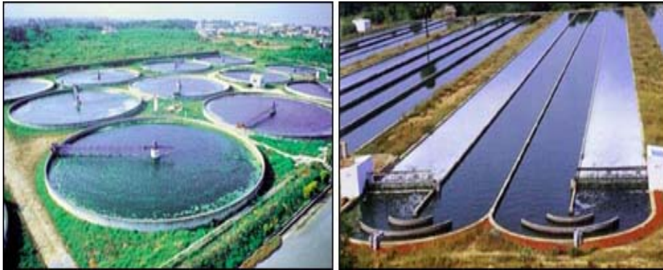
Resim 3.3. Kollu ve Çarklı havuzlarda ve kanal tipi üretim ( http://www.spirulina.com/ )
