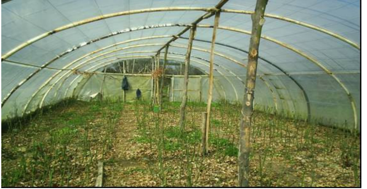
Şekil 4.2. İskelet malzemesi bakımı ihmal edilmiş bir sera (Hacı Mehmet Köyü)
