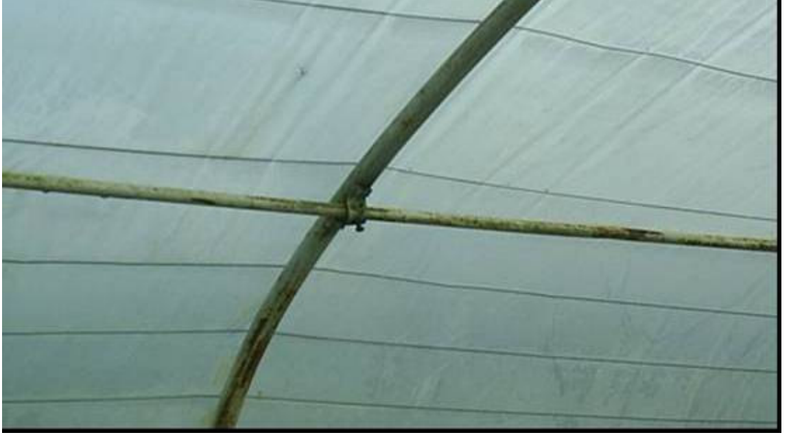
Şekil 4.4. Seralarda vidalı bağlantı şekli (Hacı Mehmet Köyü)
