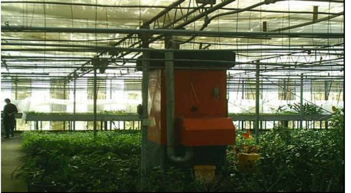
Şekil 4.9. Seraların ısıtılmasında kullanılan brülör (Yalova Merkez)
