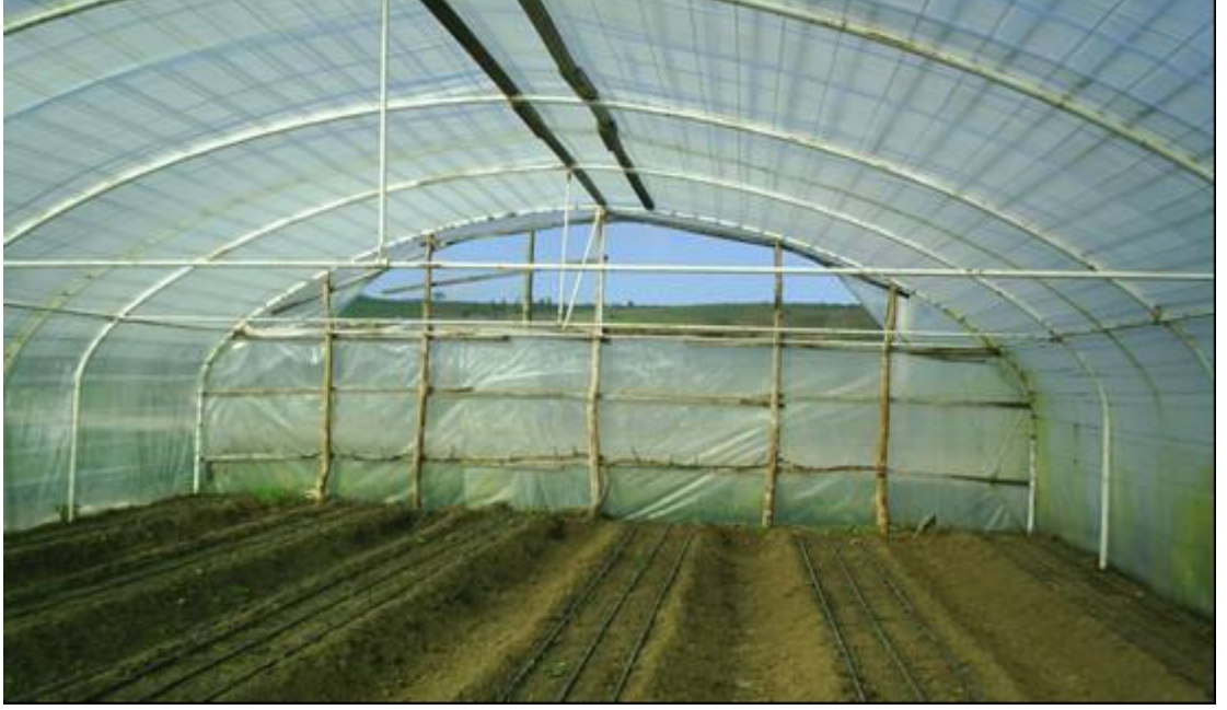
Şekil 4.5. Sera alınlarında bulunan havalandırma açıklıkları (Hacı Mehmet Köyü)
