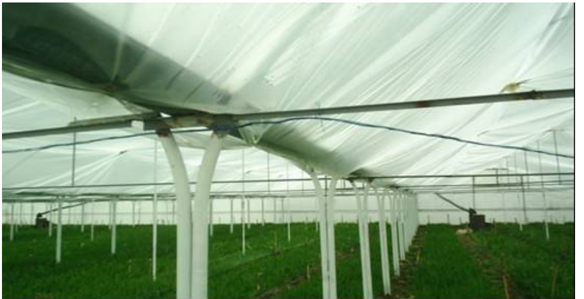
Şekil 4.3. Seralarda kaynaklı bağlantı görünüşü (Koru Köyü)
