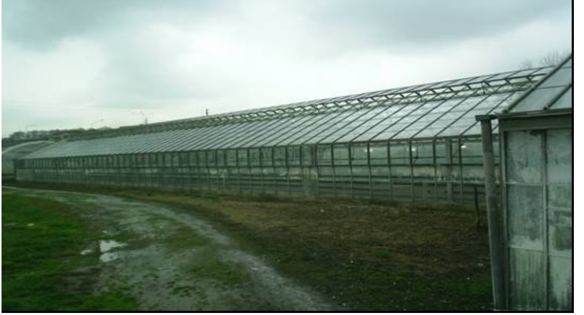
Şekil 4.7. Bir seranın çatı ve yan havalandırma açıklıkları (Yalova Merkez)
