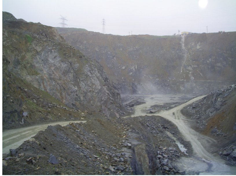
Şekil 3-8: Cebeci Bölgesi'ndeki taş ocağından genel bir görünüm
