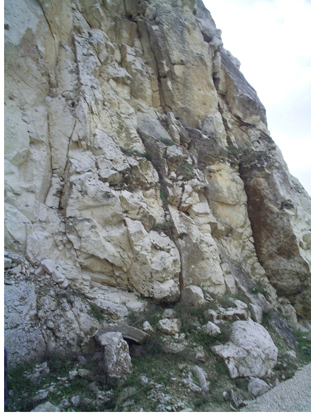
Şekil 3-12: Çatalca Bölgesi'ndeki kireçtaşlarında gözlenen eklem sistemleri
