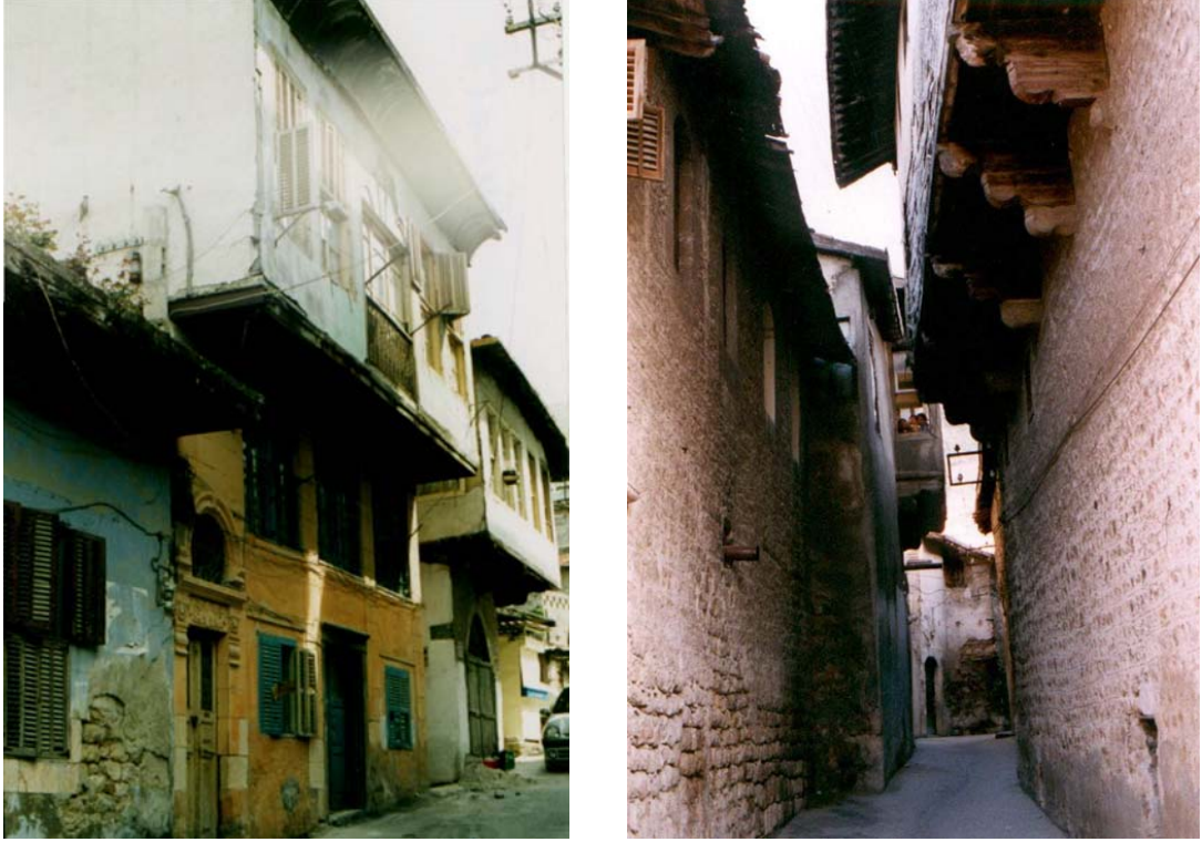
Resim 6.3. Eski Antakya evlerinin günümüzdeki durumu [67]
