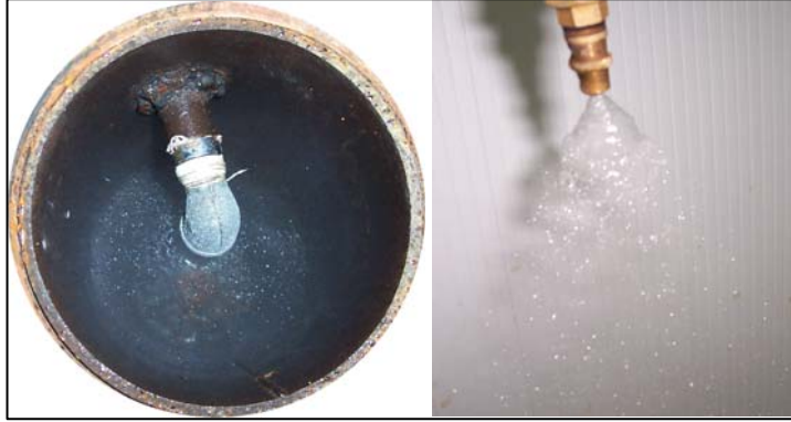
Şekil 3.6 Su girişinde kullanılan düze
