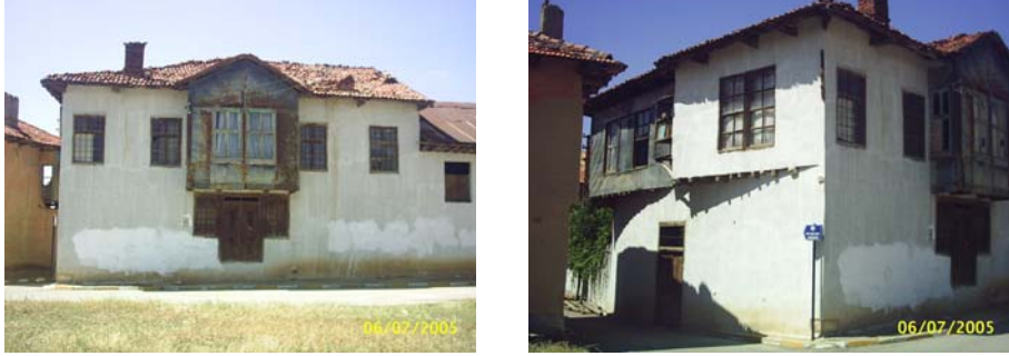
Resim 35.40. 135 envanter nolu yapı fotoğrafları
