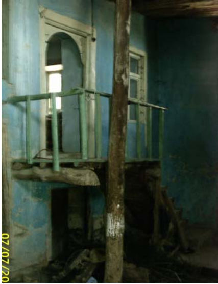
Resim 3.14. Hariciye mekanı girişi. 139 envanter nolu yapı
