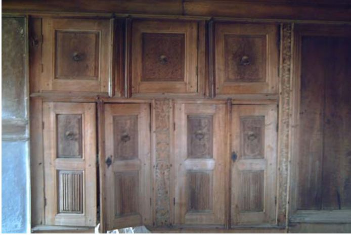
Resim 3.20. Dolap. 29 envanter nolu yapı
