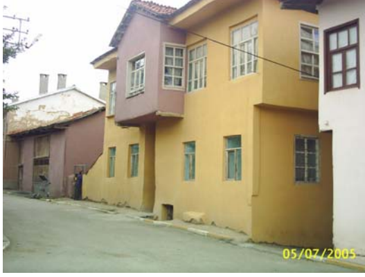
Resim 35.42. 139 envanter nolu yapı dış cephe fotoğrafı
