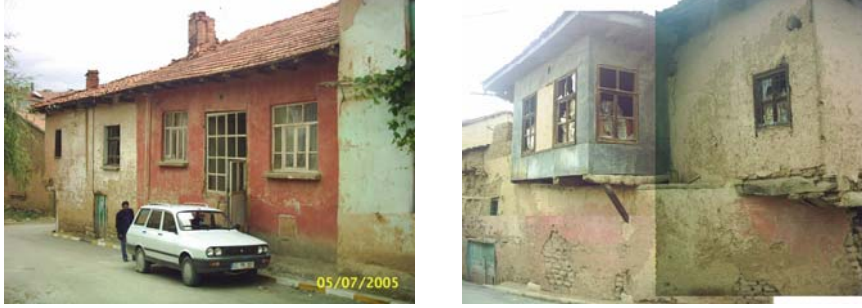
Resim 35.45. 144 envanter nolu yapı dış cephe fotoğrafları
