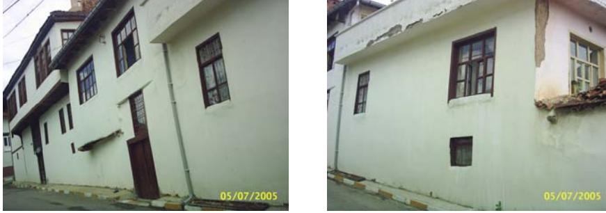
Resim 35.35. 111 envanter nolu yapı dış cephe fotoğrafları
