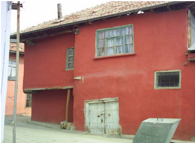
Resim 3.3. Çobançeşme Sokak'ta köşe parselde yer alan 175 envanter nolu yapı
