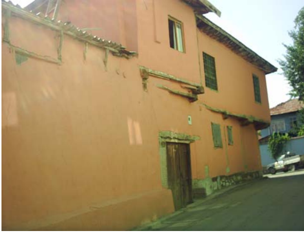
Resim 3.36. Çift testere çıkma. 40 envanter nolu yapı
