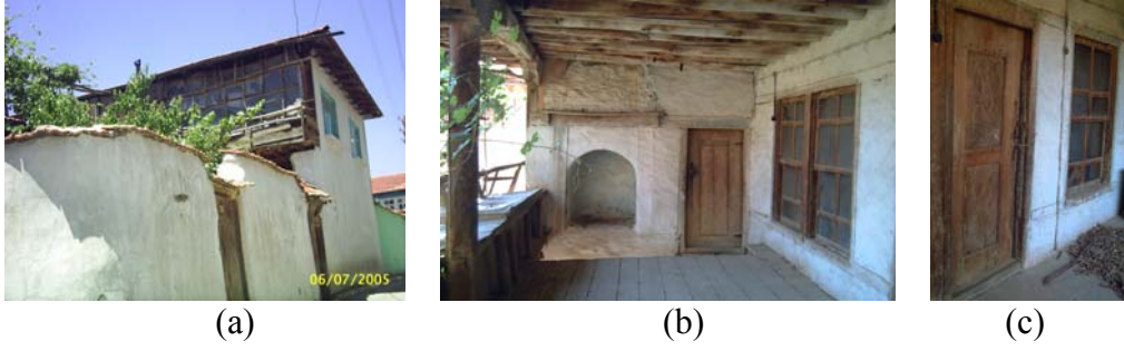
Resim 35.38. 124 envanter nolu yapı fotoğrafları
