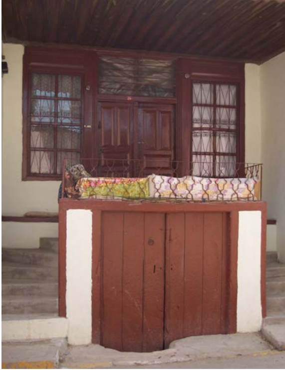
Resim 3.39. 83 envanter numaralı yapı girişi
