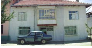
Resim 35.10. 41 envanter nolu yapı
