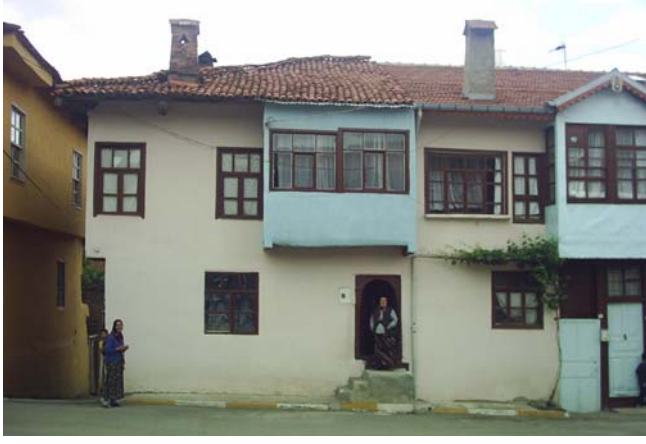
Resim 35.32. 107 envanter nolu yapı fotoğrafları
