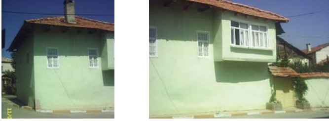
Resim 35.26. 75 envanter nolu yapı dış cephe fotoğrafları
