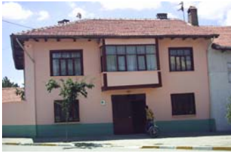
Resim 35.11. 42 envanter nolu yapı
