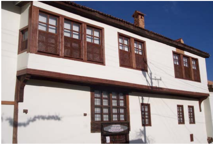
Resim 3.40. 105 envanter numaralı bina cephesi
