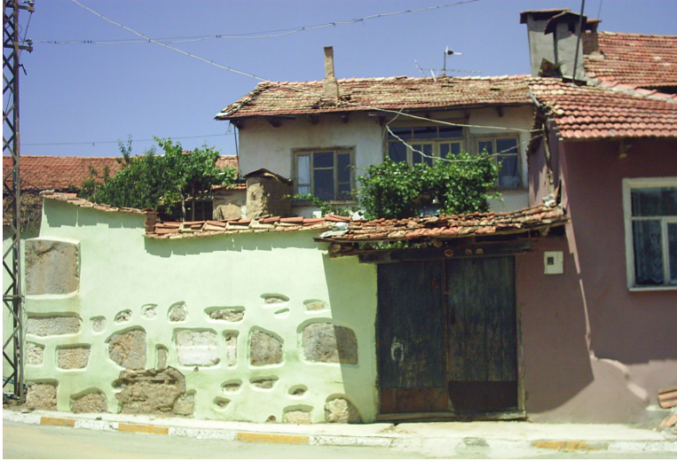
Resim 3.9. Moloz taş bahçe duvarı. 100 envanter nolu yapı
