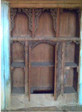
Resim 3.18. Dolap. 130 envanter nolu yapı
