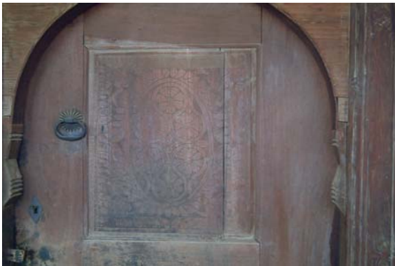
Resim 3.30. 29 envanter nolu yapının kapı detayı
