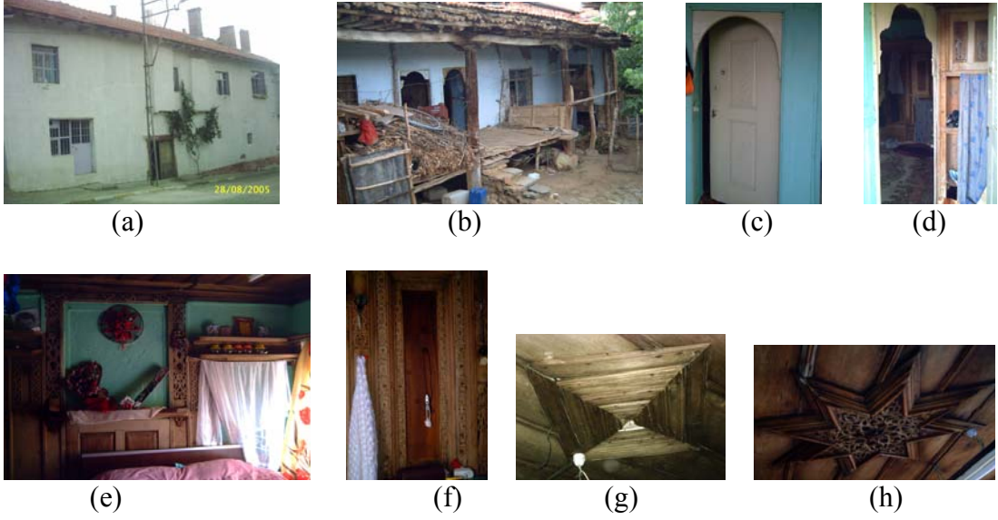
Resim 35.13. 52 envanter nolu yapı fotoğrafları
