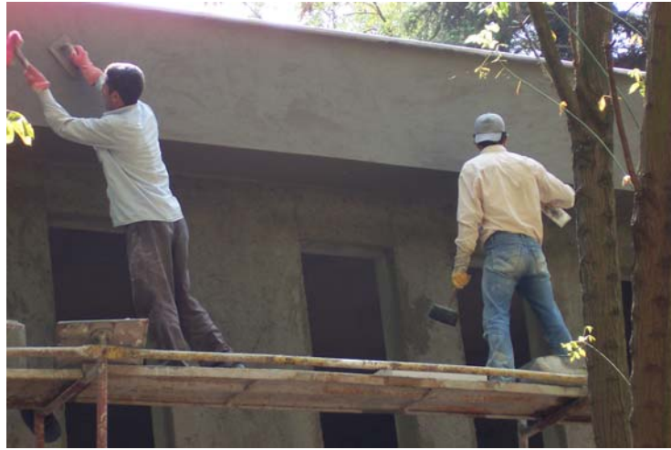
Resim 4.2., Türkiye’de Yapı İskelesinde Çalışan İşçiler.
