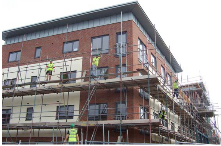
Resim 4.1., İngiltere’de Yapı İskelesinde Çalışan İşçiler.
