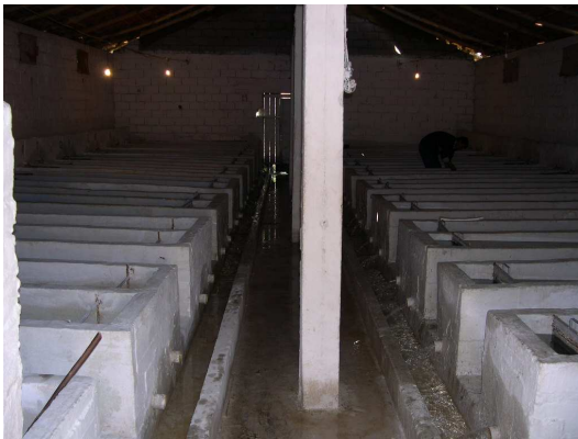
5- Kuluçkahane iç görünüm
