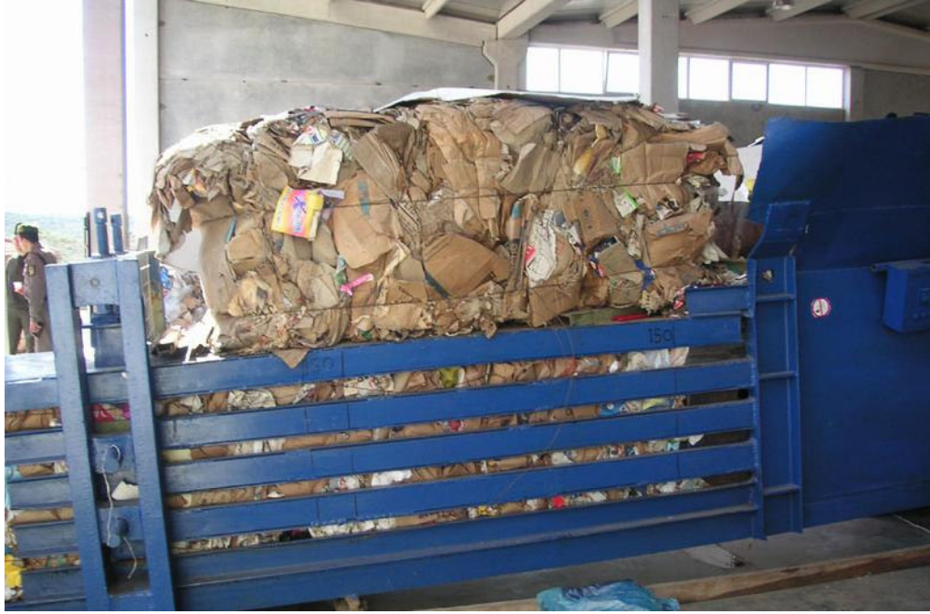
Resim 4.7. Atık kâğıt ayırma tesisinden görünüm (giriş kısmı)
