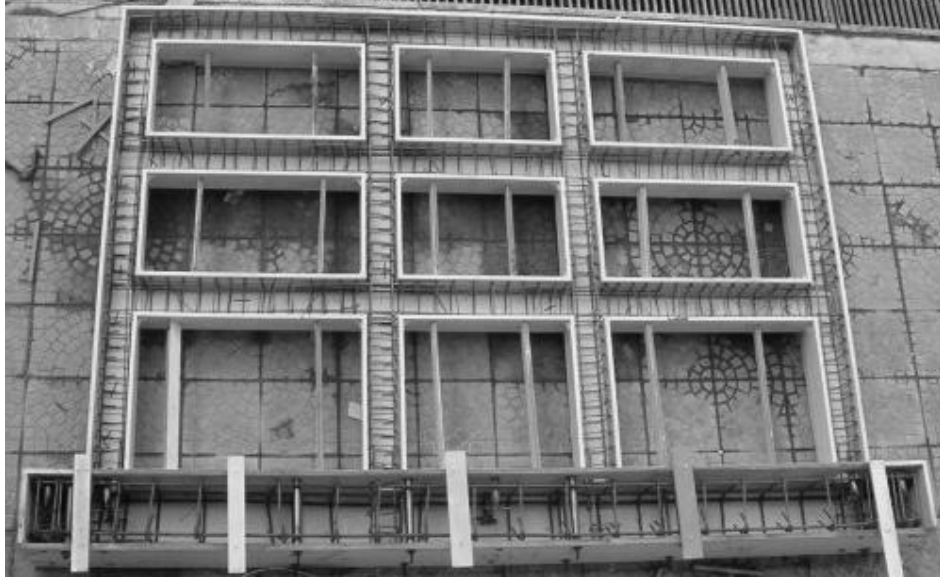
Şekil 7.17 Çerçeve sistemi kalıp ve donatı düzeni
