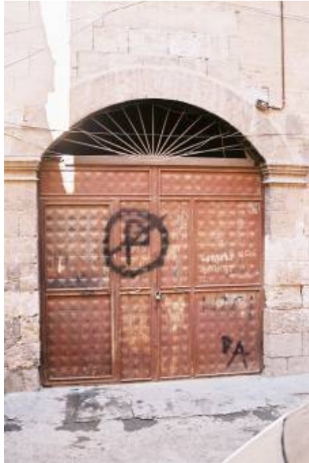
Foto : 220- Hacı Mehmet Sayın Sabunhanesi, doğu cephede kuzeyde yeralan kapıdan görünüş
