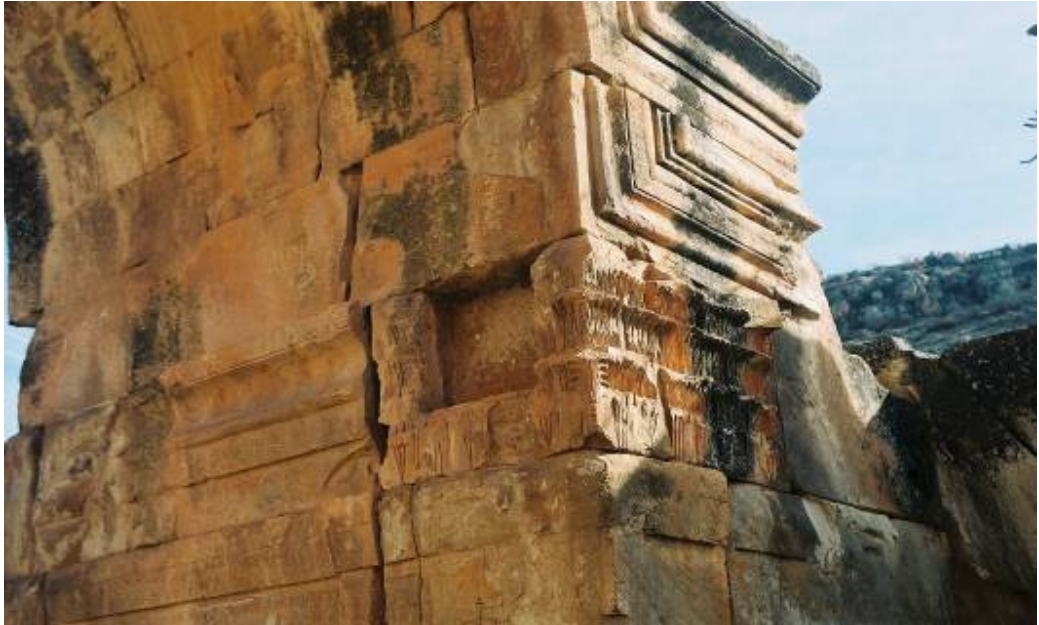
Foto : 156- Ehneş Kilisesi, kemerlerin başlangıç yerlerinde yeralan süslemelerden görünüşü
