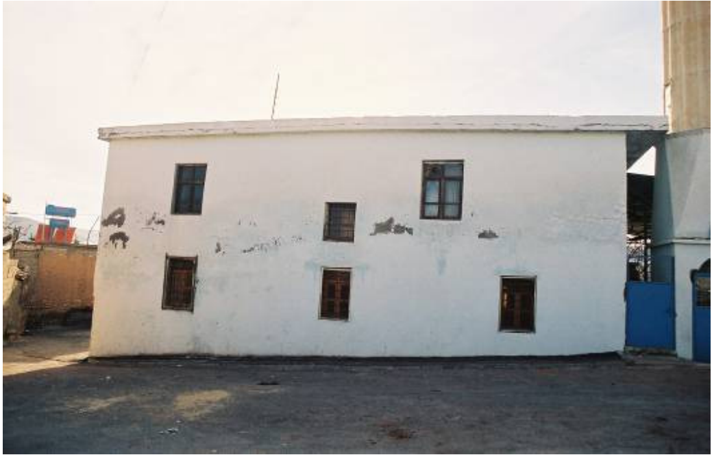
Foto : 76- Salkım Kasabası Merkez Camii, doğu cepheden görünüş
