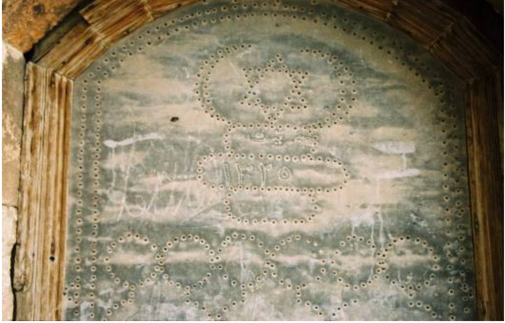
Foto : 197- Fincancıoğlu Sabunhanesi, ikinci kata geçişi sağlayan kapının üst bölümünden görünüş
