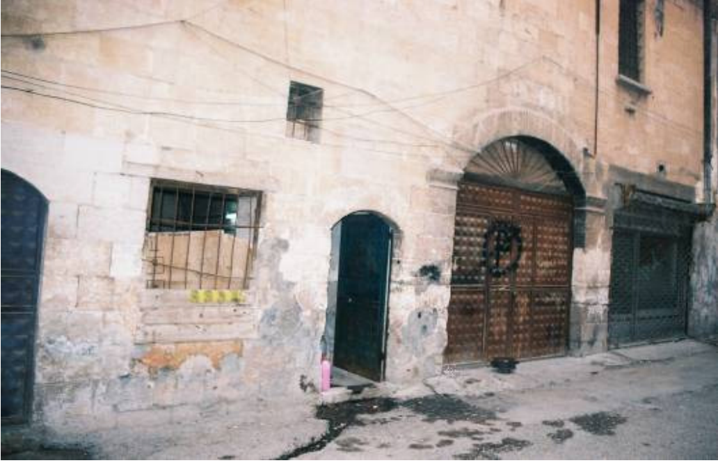
Foto : 219- Hacı Mehmet Sayın Sabunhanesi, doğu cephedeki dükanlardan görünüş
