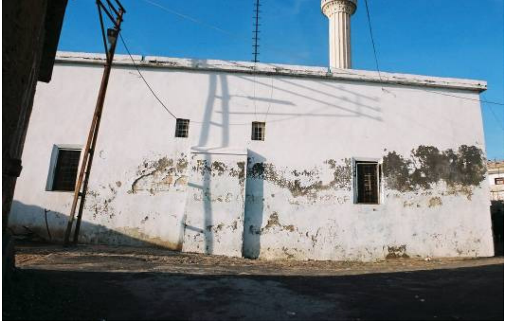
Foto : 75- Salkım Kasabası Merkez Camii, güney cepheden görünüş
