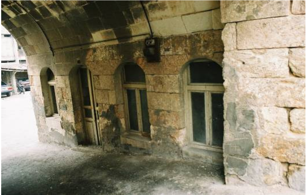
Foto : 190- Fincancıoğlu Sabunhanesi, giriş koridorunun doğusunda kalan bölümden görünüş
