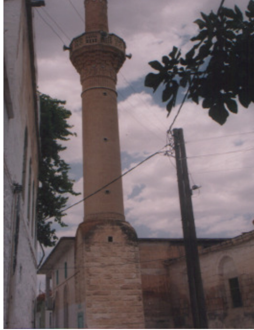
Foto : 55- Tatlıcak Kasabası Merkez Camii, batı cephe ve minareden görünüş
