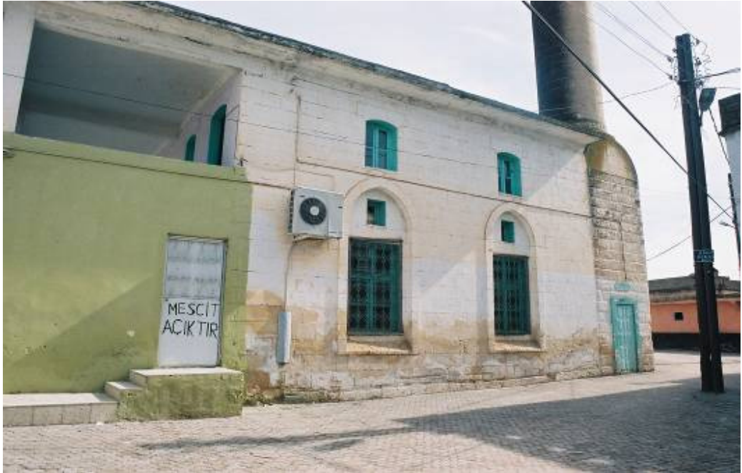
Foto : 54- Tatlıcak Kasabası Merkez Camii, Kuzeye 1968 yılında eklenen bölümün batı cephesinden görünüş
