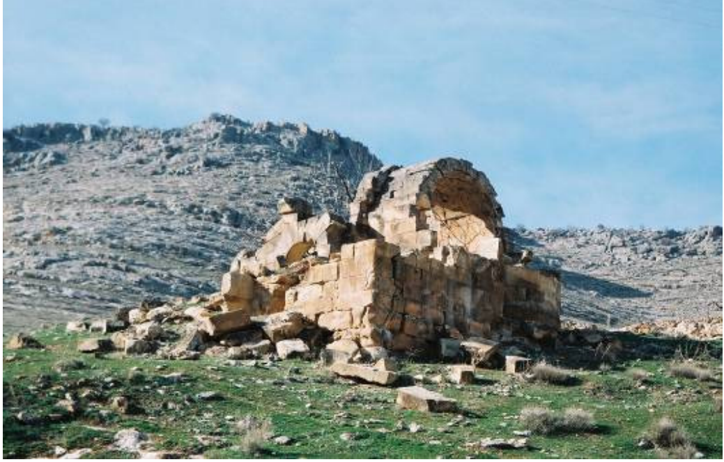
Foto : 141- Ehneş Kilisesi, güneydoğudan görünüş
