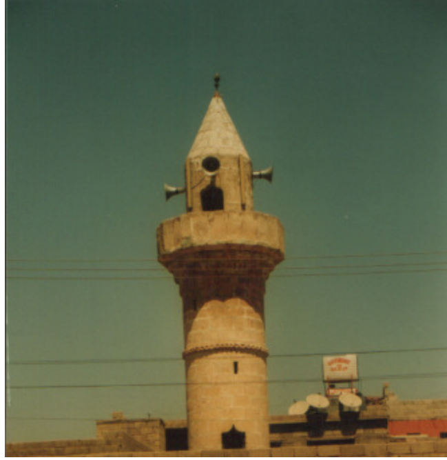
Foto. : 17- Uluyatır Kasabası Merkez Camii, güneyden görünüş
