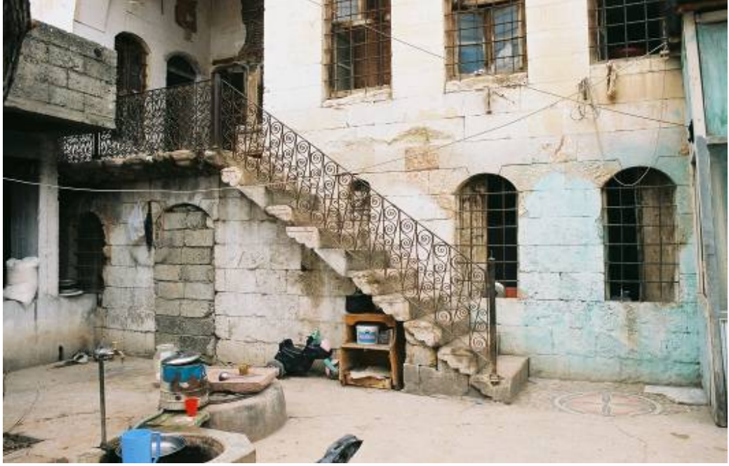
Foto : 261- Hacı Ahmet Sayın Evi, güney cephede ikinci kata ulaşmayı sağlayan merdivenlerden görünüş
