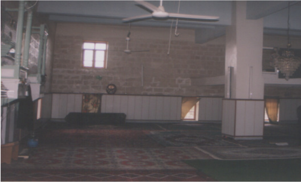
Foto : 80- Salkım Kasabası Merkez Camii, harimden görünüş
