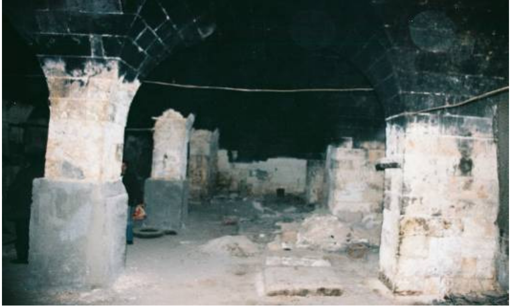
Foto : 224- Hacı Mehmet Sayın Sabunhanesi, birinci katta üst örtüyü taşıyan ayaklardan görünüş
