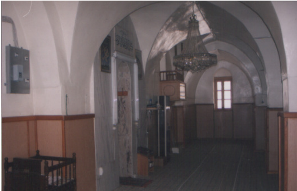
Foto : 58- Tatlıcak Kasabası Merkez Camii, harimde mihrap önünde yer alan sahından görünüş
