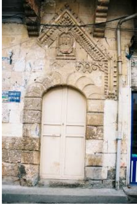
Foto : 209- Hacı Ahmet Sayın Sabunhanesi, ikinci kata çıkışı sağlayan kapıdan görünüş
