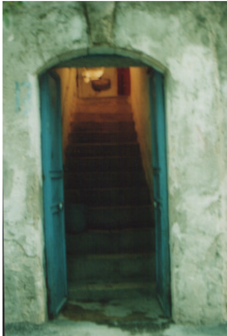
Foto : 306- Sayınlar Misafirhanesi, iç mekana geçişi sağlayan kapı ve merdivenlerden görünüş
