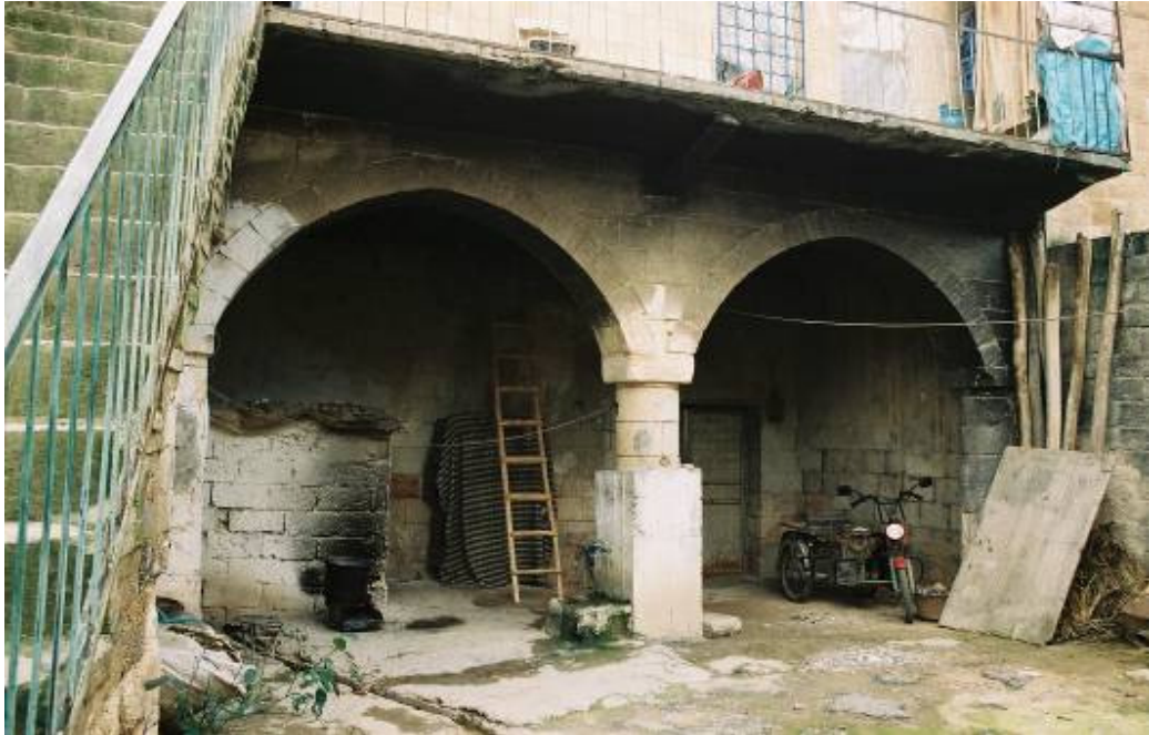
Foto : 240- İbrahim Eser Evi, kuzey cephede ikinci katı taşıyan ayak ve kemerlerden görünüş
