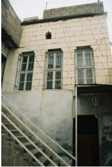
Foto : 255- İsmail Örnek Evi, güney cepheden ve ikinci kata çıkışı sağlayan merdivenlerden görünüş
