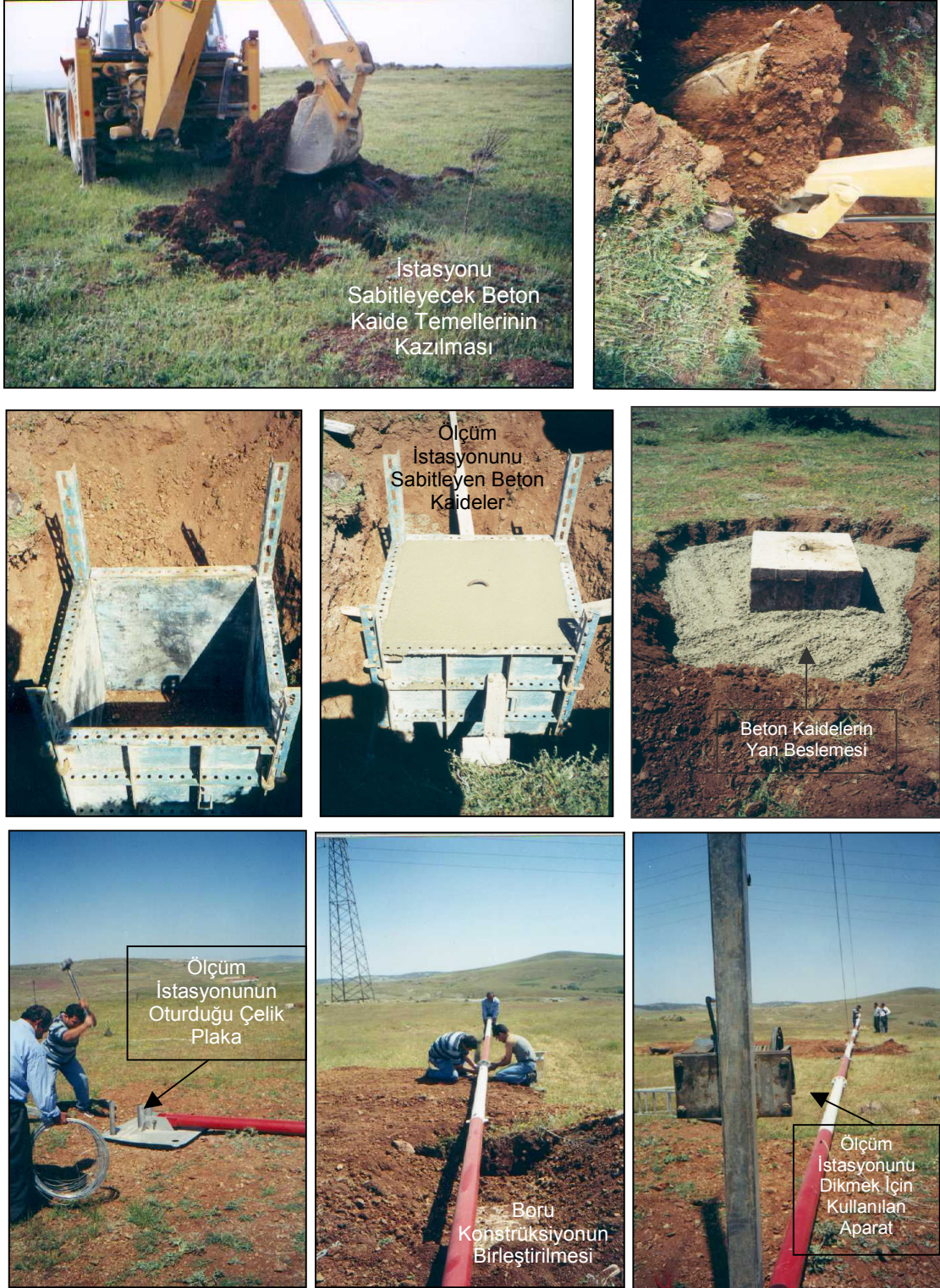
Şekil 4.5a. Bünelek Tepe Rüzgar Ölçüm İstasyonu Montaj Aşamaları
