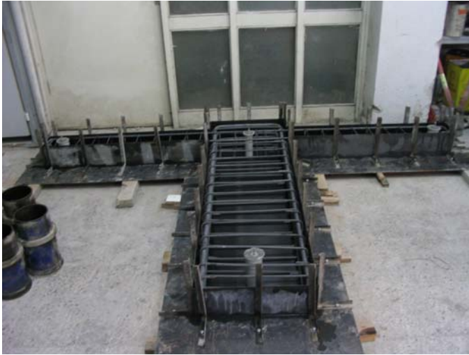
Resim 2.2. Çelik kalıp içerisinde donatı
