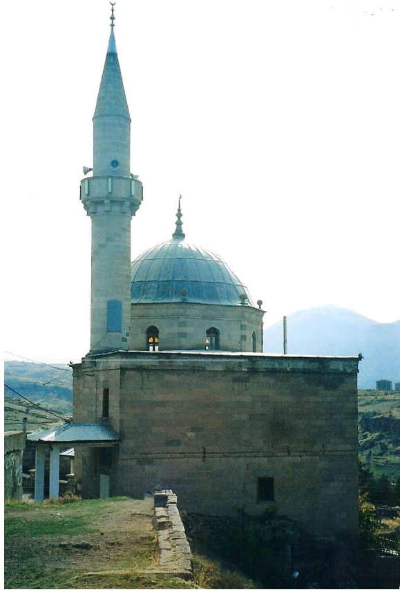
Fotoğraf No 37: Tavlusun (Aydınlar) Camii Kuzeydoğusundan görünüş
