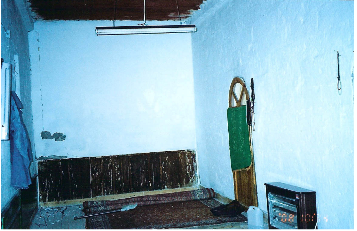
Fotoğraf No 55: Talas Han Camii Zemin Kattaki Kuzey Cephe Odasından Genel Görünüş
