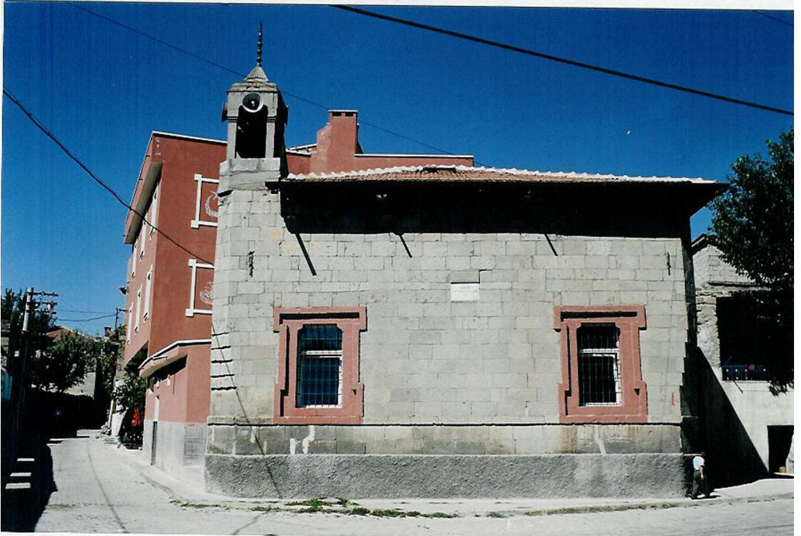
Fotoğraf No 82: Develi Tirem Camii Güney-Batı Cephesi
