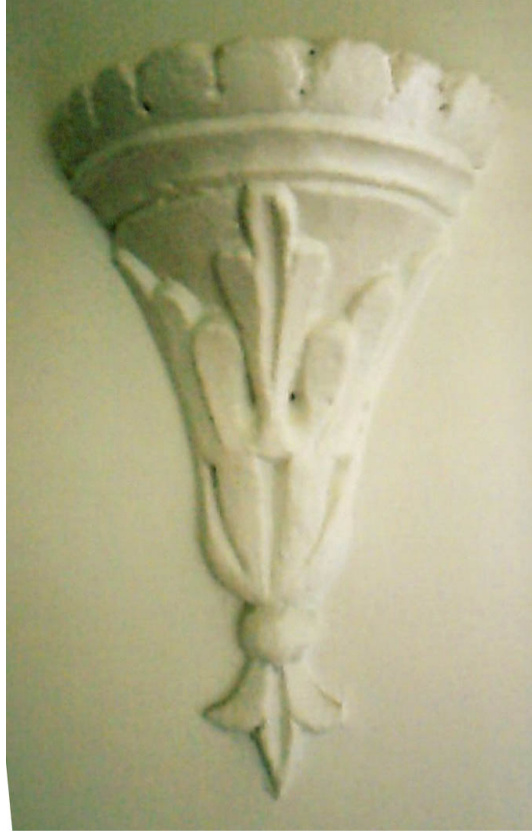
Fotoğraf No 109: Pınarbaşı Methiye Camii Beden Duvarındaki Bezemeden Detay
