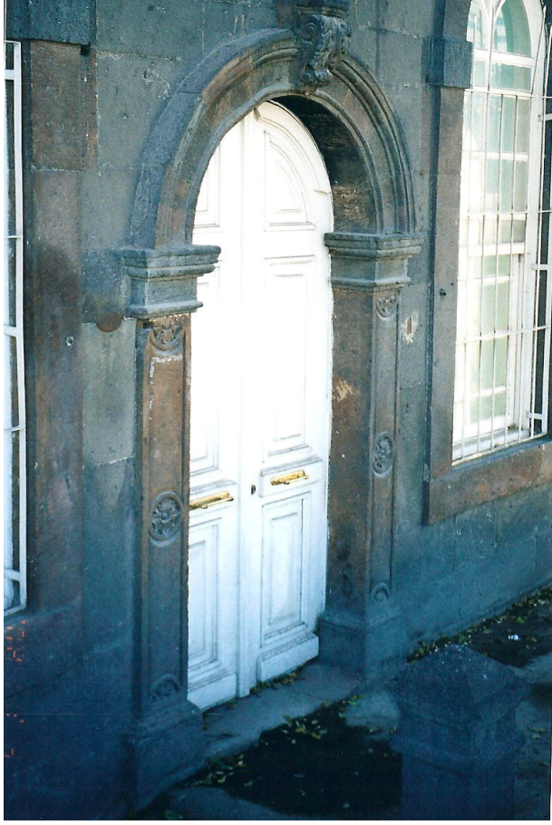
Fotoğraf No 189: Saat Kulesi Muvakkithanesi Girişinden Genel Görünüş
