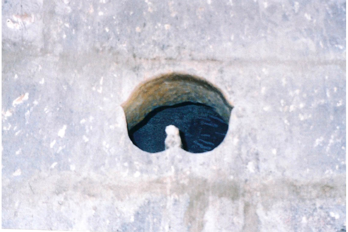
Fotoğraf No 78: Talas Han Camii Minare-Avlu Giriş Kapısı Arasındaki Pencere
