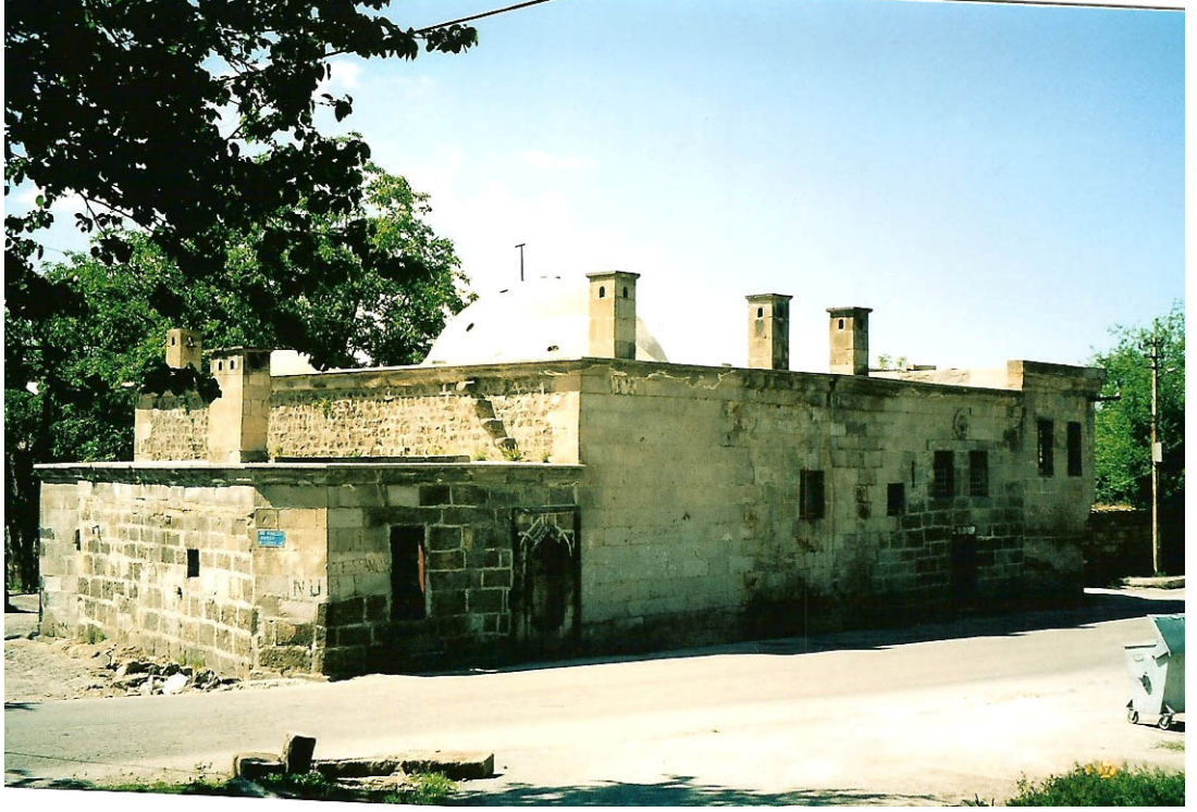
Fotoğraf No 175: Talas Ali Saib Paşa Hamamından Genel Görünüş
