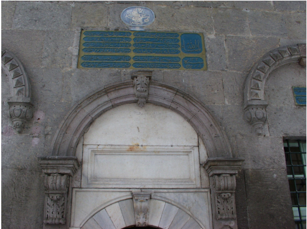
Fotoğraf No 127-N: Zeynel Abidin Türbe Girişi Üzerindeki Kemerlerden Genel Görünüş
