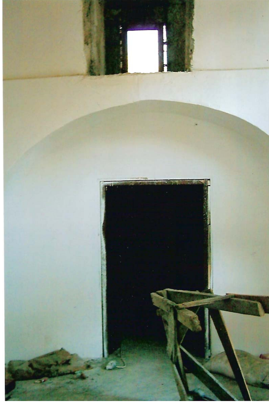
Fotoğraf No 177: Talas Ali Saib Paşa Hamamının Soyunmalık Kısımının Kuzey Bölümü
