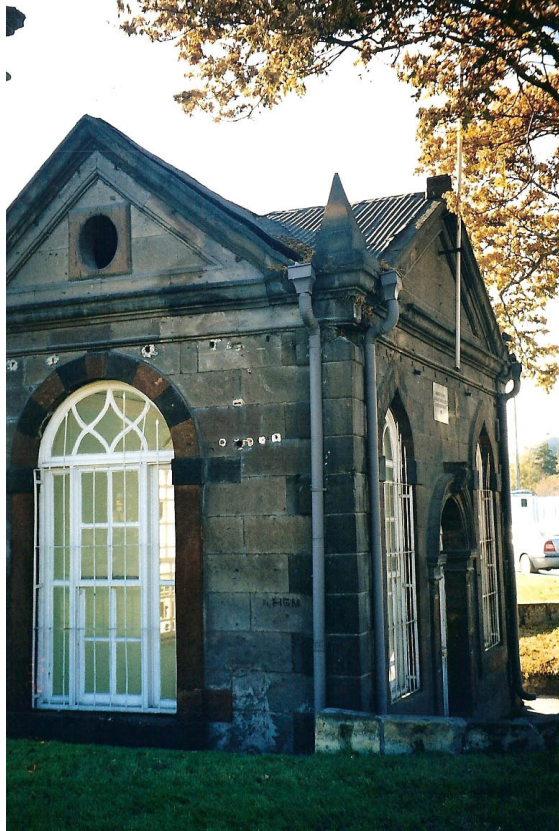
Fotoğraf No 186: Saat Kulesi Muvvakithanesinin Doğu Cephesinden Genel Görünüş
