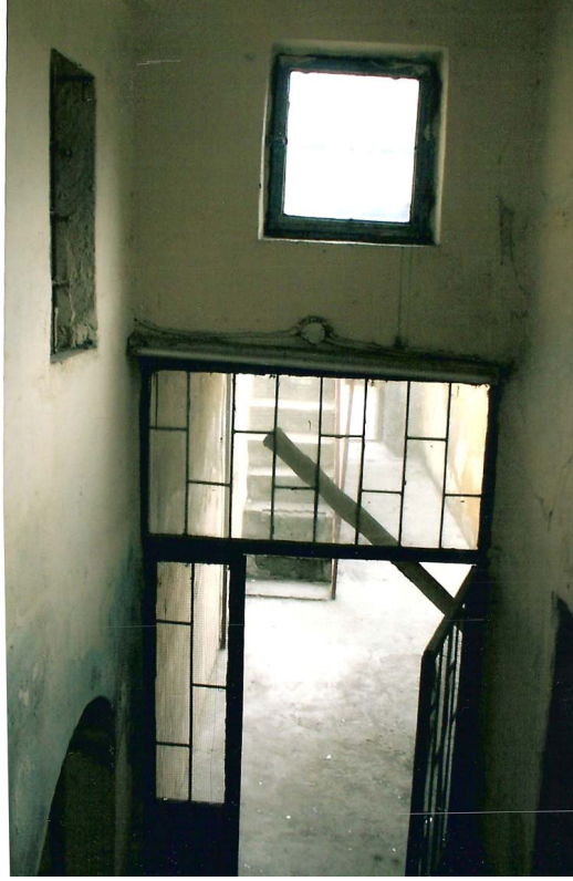
Fotoğraf No 11: Keklikoğlu Camii Minareye Çıkış Merdiveni
