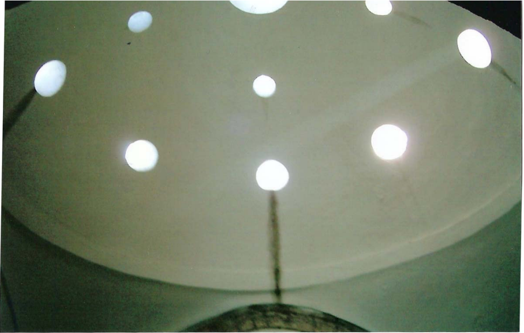
Fotoğraf No 180: Talas Ali Saib Paşa Hamamı Sıcaklığının Üzerindeki Kubbe
