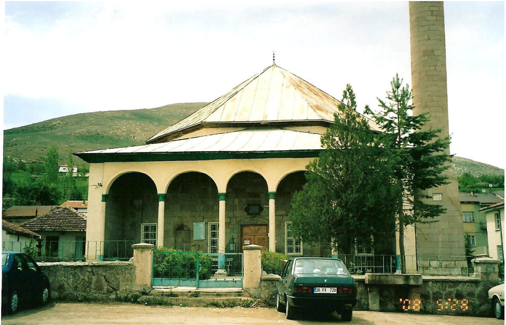
Fotoğraf No 22:Pınarbaşı Mehmet Ali Bey Camii Kuzey Cepheden Genel Görünüş
