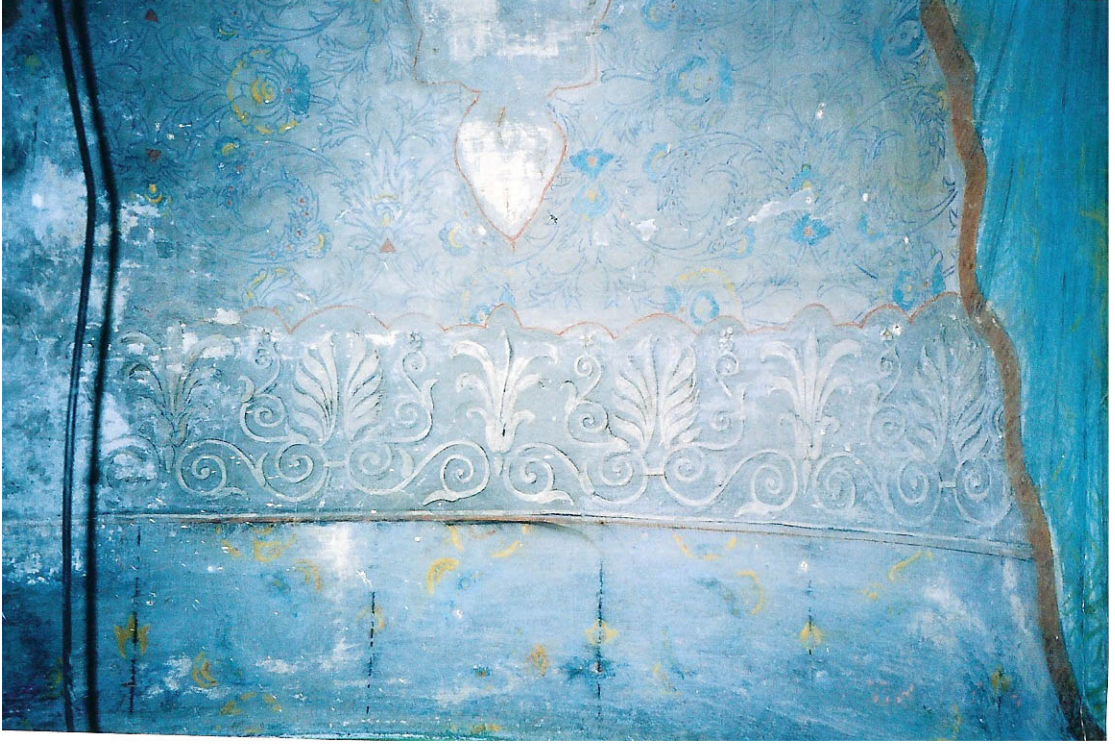
Fotoğraf No 63: Talas Han Camii Mihrap Nişi İçerisindeki Bezemeden Detay
