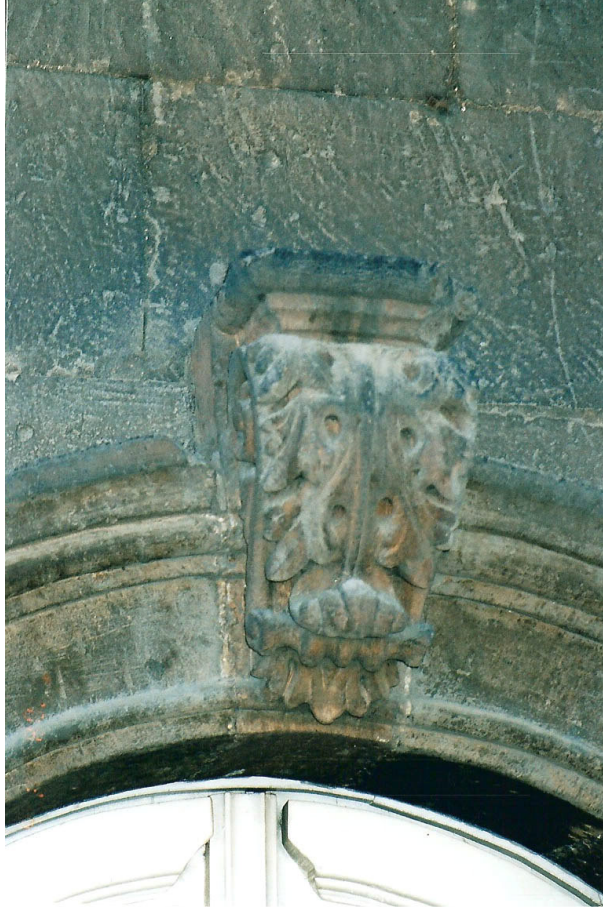
Fotoğraf No 191: Saat Kulesi Muvvakithane Girişi Kemer Kilit Taşındaki Bezemeden Detay
