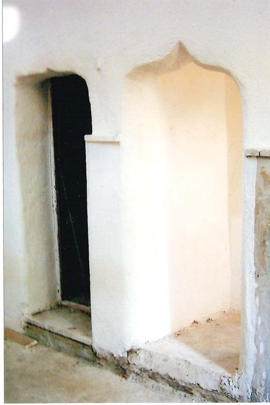
Fotoğraf No 183: Talas Ali Saib Paşa Hamamı Sıcaklığındaki Tuvalet ve Soyunmalığa Geçiş Koridoru
