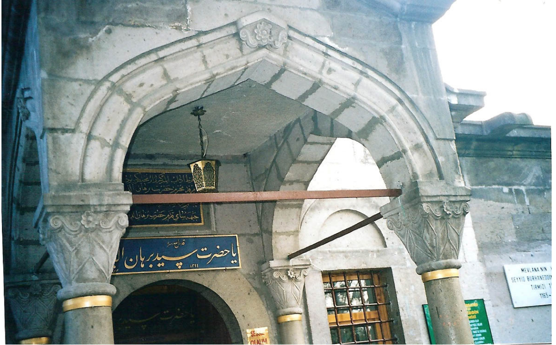
Fotoğraf No 134: Seyyid Burhaneddin Türbesi Kuzey Cephesindeki Revaktan Görünüş
