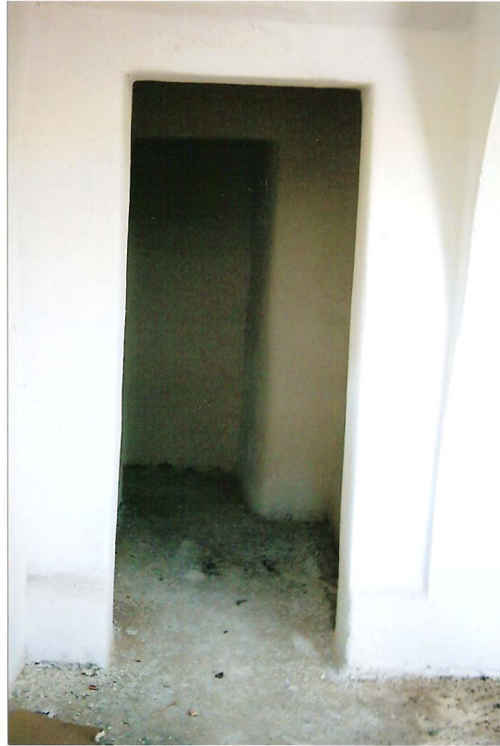
Fotoğraf No 178: Talas Ali Saib Paşa Hamamının Batısındaki Sıcaklığa Giriş Koridoru
