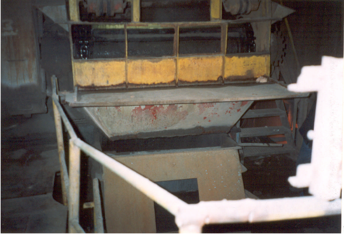
Şekil 3.4. Seyitömer termik santralinde taban külü alınan ızgaranın görünümü.
