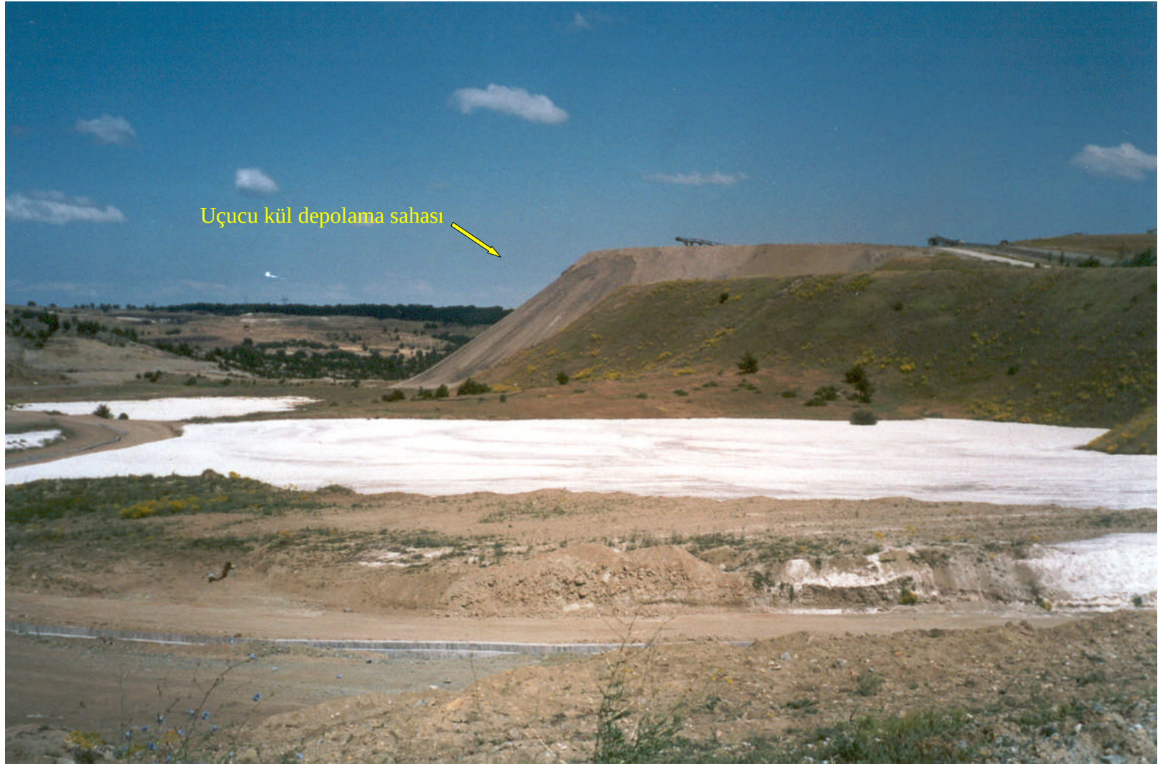
Şekil 1.5. Seyitömer termik santralı kül depolama alanının görünümü.
