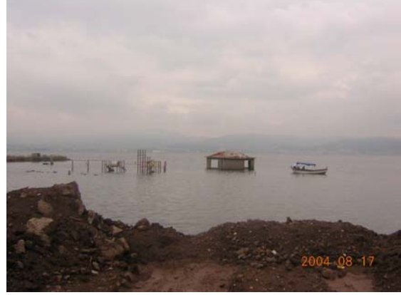
Şekil 4.8. Yeniköy kıyısında (a) UM Denizcilik Şirketine ait tersanenin olduğu kesimin ve (b) bunun batısında 1999 depreminde yanal yayılmadan etkilenmiş kıyının bugünkü görüntüsü (Fotoğralar tez çalışması sırasında 2004 yılında çekilmiştir).
