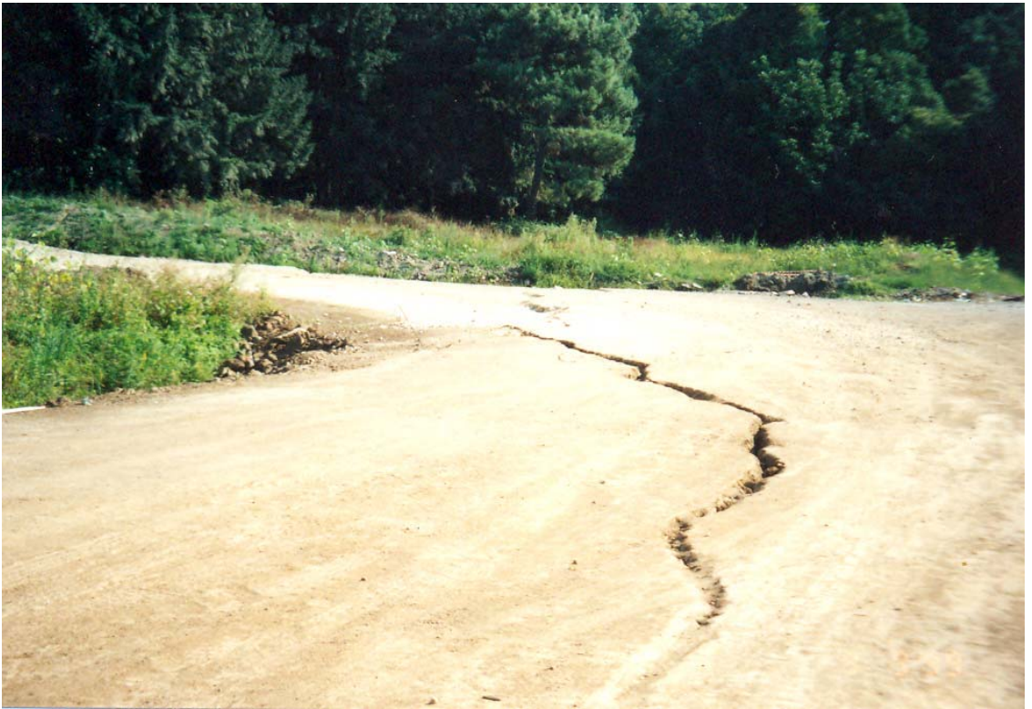
Şekil 4.4. Yüzey kırığının Kocaeli Körfezi'nin güney kesiminde neden olduğu yapısal hasarlardan tipik görüntüler: (a) Gölçük'te rotasyona uğramış yapılar (Aydan et al., 2000) ve (b) Gölçük yakınlarında yüzey kırığından etkilenmiş bir yol (Fotoğraf: R. Ulusay).
