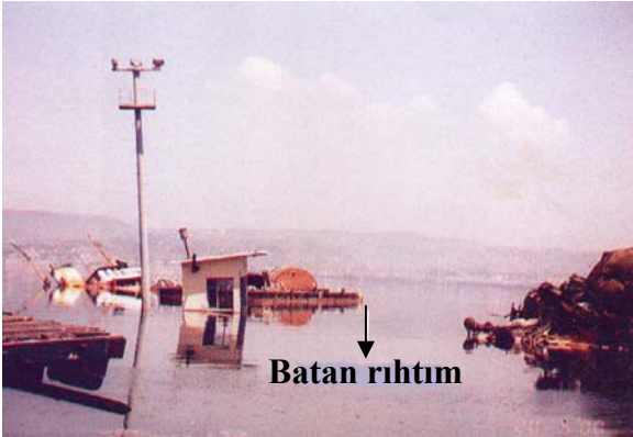
Şekil 4.9. Seymen bölgesinde MKE hurda tesisinde meydana gelen yanal yayılma; (a) deprem sonrası (Aydan and Ulusay, 2000) ve (b) bu kıyının günümüzde kısmen doldurulmuş görüntüsü.
