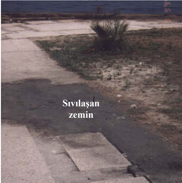
Şekil 4.7. (a) Gölçük ilçesi Kavaklı bölgesindeki yerleşim yerinde su altında kalan alanlar ve (b) Gölçük Kongre Merkezi önünde gözlenen sıvılaşma izleri (Aydan et al., 2000), (c) Kavaklı kıyısının deprem sonrası doldurulmuş haliyle güncel görüntüsü.
