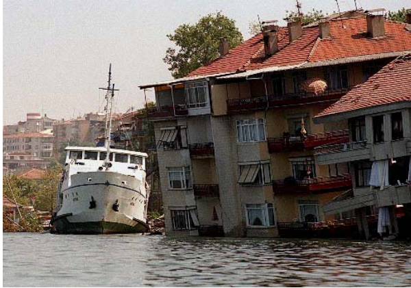
Şekil 4.6. Değirmendere Burnu'ndaki kıyı çizgisinin (a) deprem öncesi ve (b) deprem sonrası konumları (Çetin et al., 2004a), (c) hareket sonrası kıyının yakından görünümü (Aydan et al., 2000), (d) Değirmendere Burnu'nun bugünkü kısmen doldurulmuş hali.
