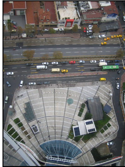
Resim 5.26. Metrocity önündeki giriş meydanı [Bilgin,2006]
