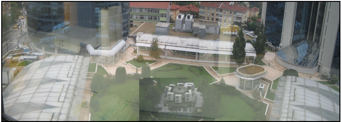
Resim 5.16. Akmerkez arşı bloęu atısı, yeşil alan kullanımı [Bilgin,2006]
