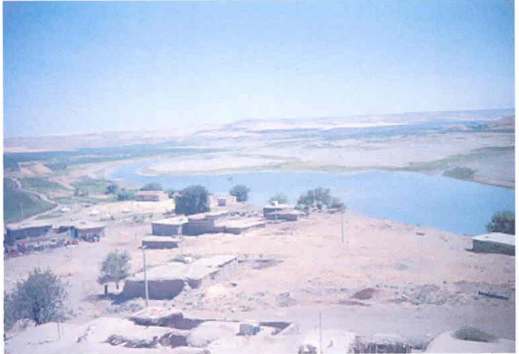
Res. 8. Batrik (Çayırtarla) Höyüğü Genel Görünüm
