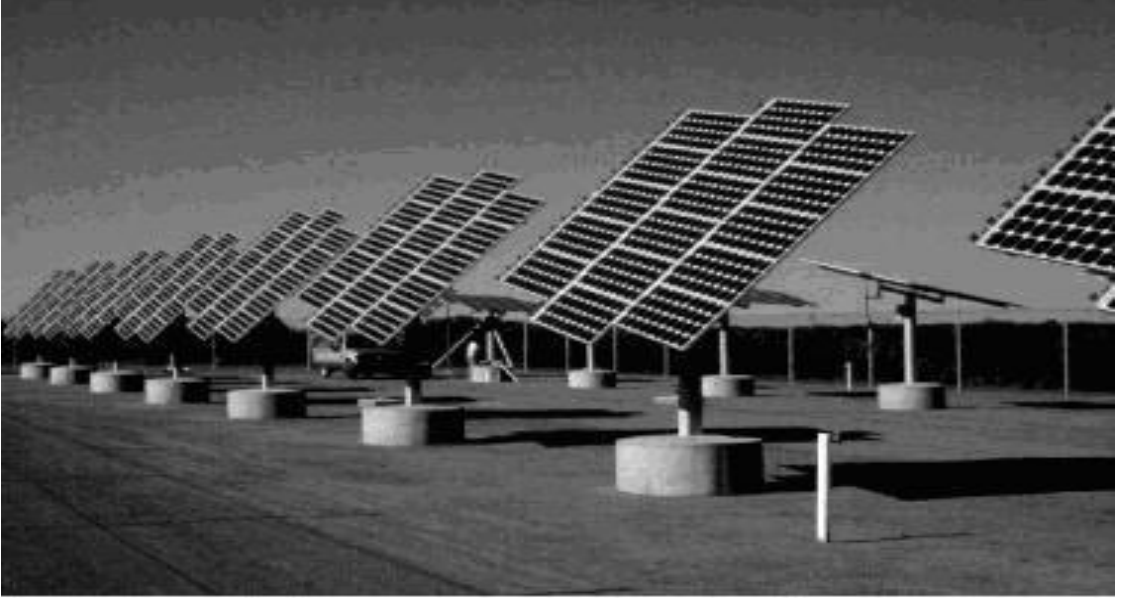
Şekil 2.4 Yüksek güçlü güneş sistemlerin kurulduğu santraller
