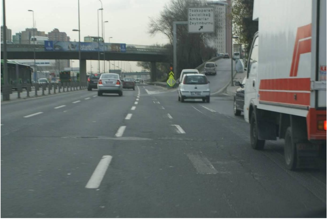
Şekil 4.4 Ayrım noktasında yatay işaretleme uygulama hatası.
