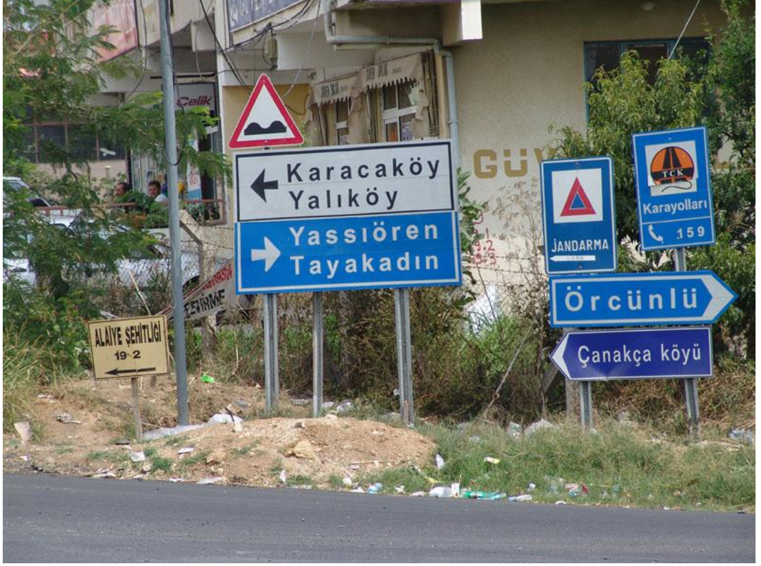
Şekil 3.4 Düşey işaretleme hatası.
