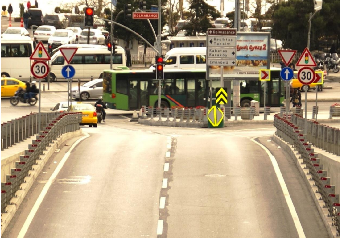
Şekil 6.33 Dolmabahçe tünel çıkış kolu-4.
