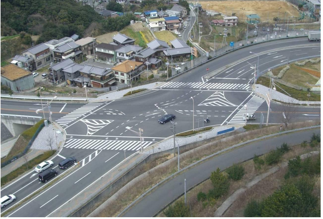
Şekil 4.5 Yurt dışında doğru yatay işaretleme uygulaması.
