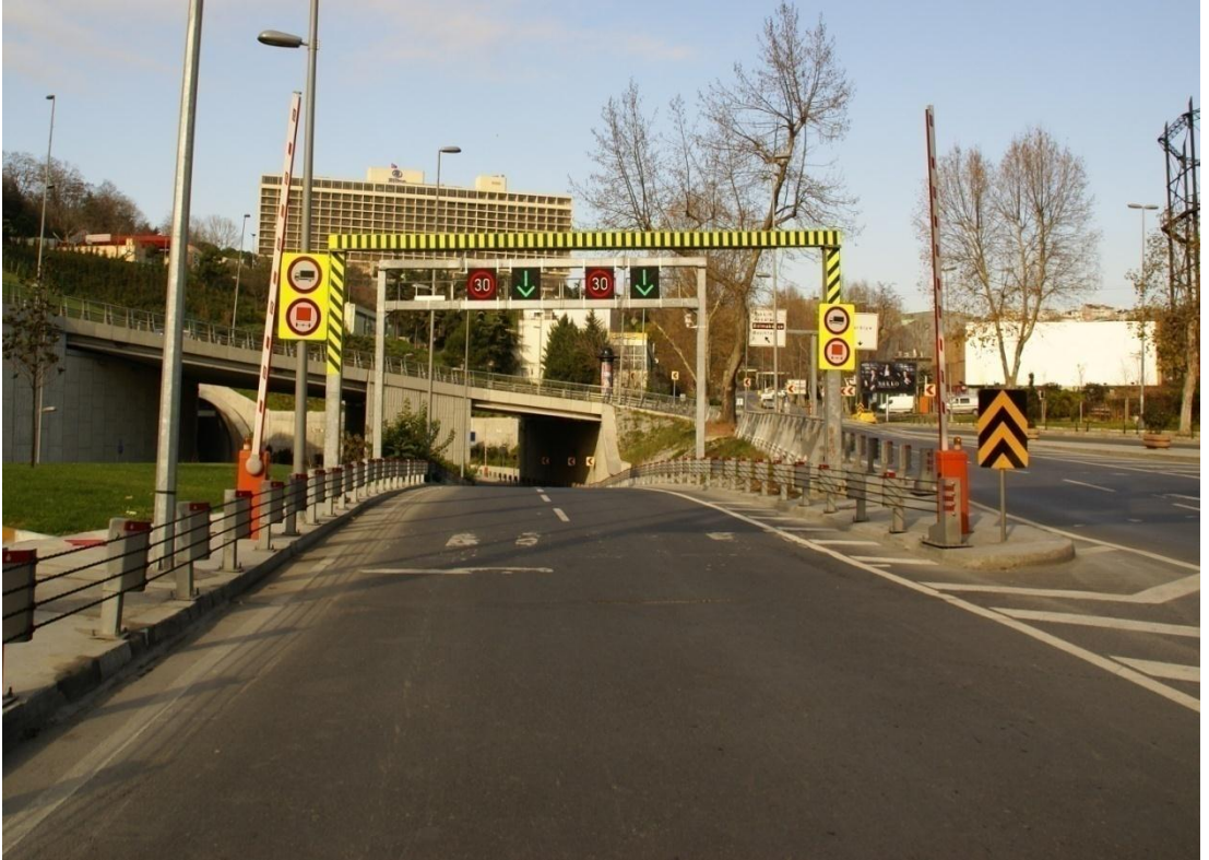
Şekil 6.13 Dolmabahçe tünel girişi ayrımı (sonra).
