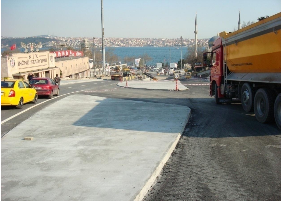
Şekil 6.22 Dolmabahçe Gazhane Caddesi Dolmabahçe inişi-2 (önce).
