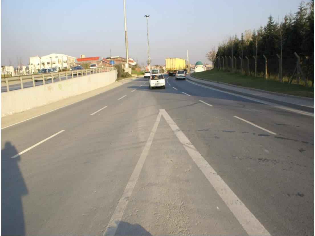
Şekil 4.3 Katılım noktasında yatay işaretleme uygulama hatası.
