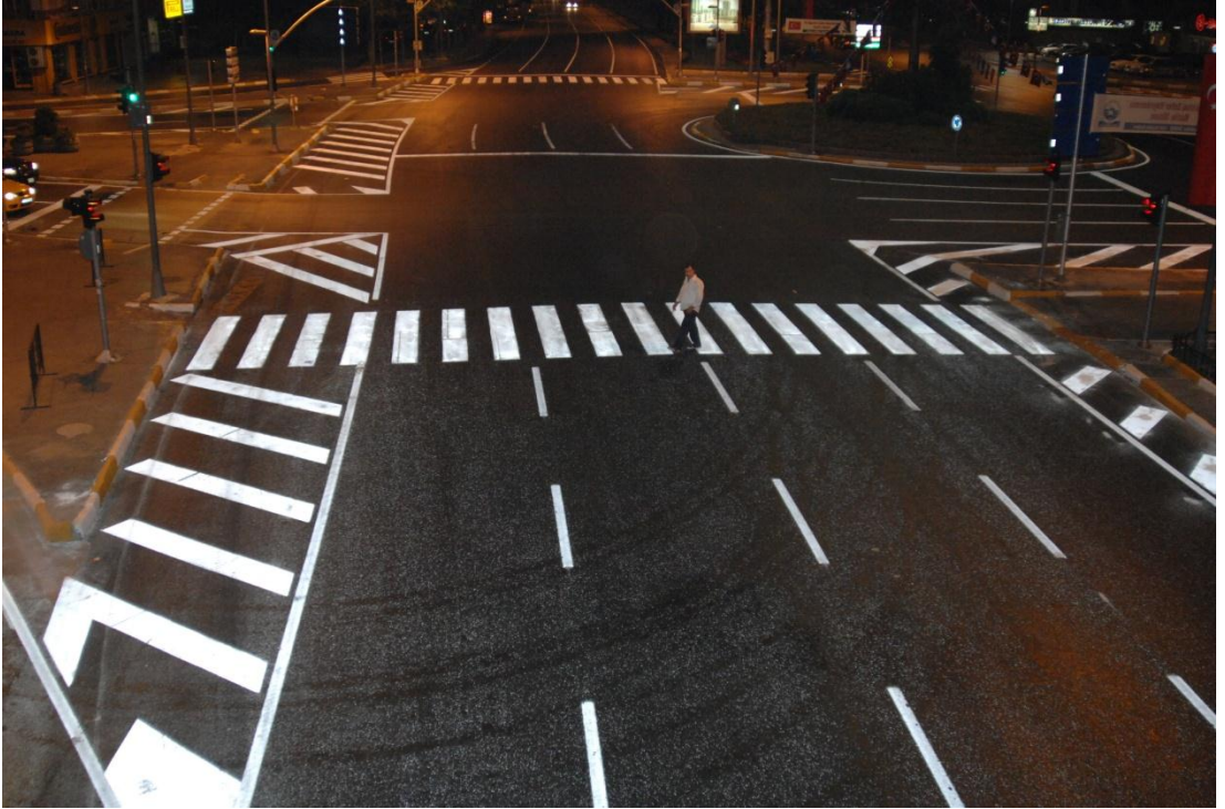
Şekil 4.6 Ülkemizde doğru yatay işaretleme uygulaması.
