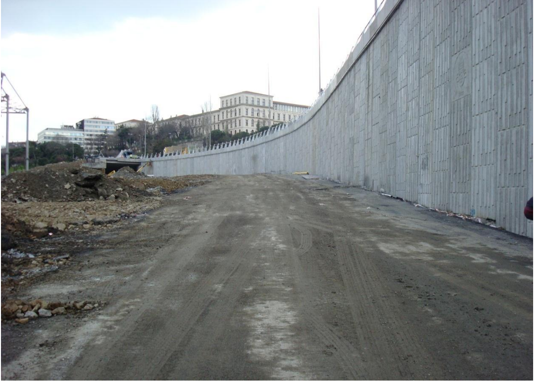
Şekil 6.30 Dolmabahçe tünel çıkış kolu-2 (önce).
