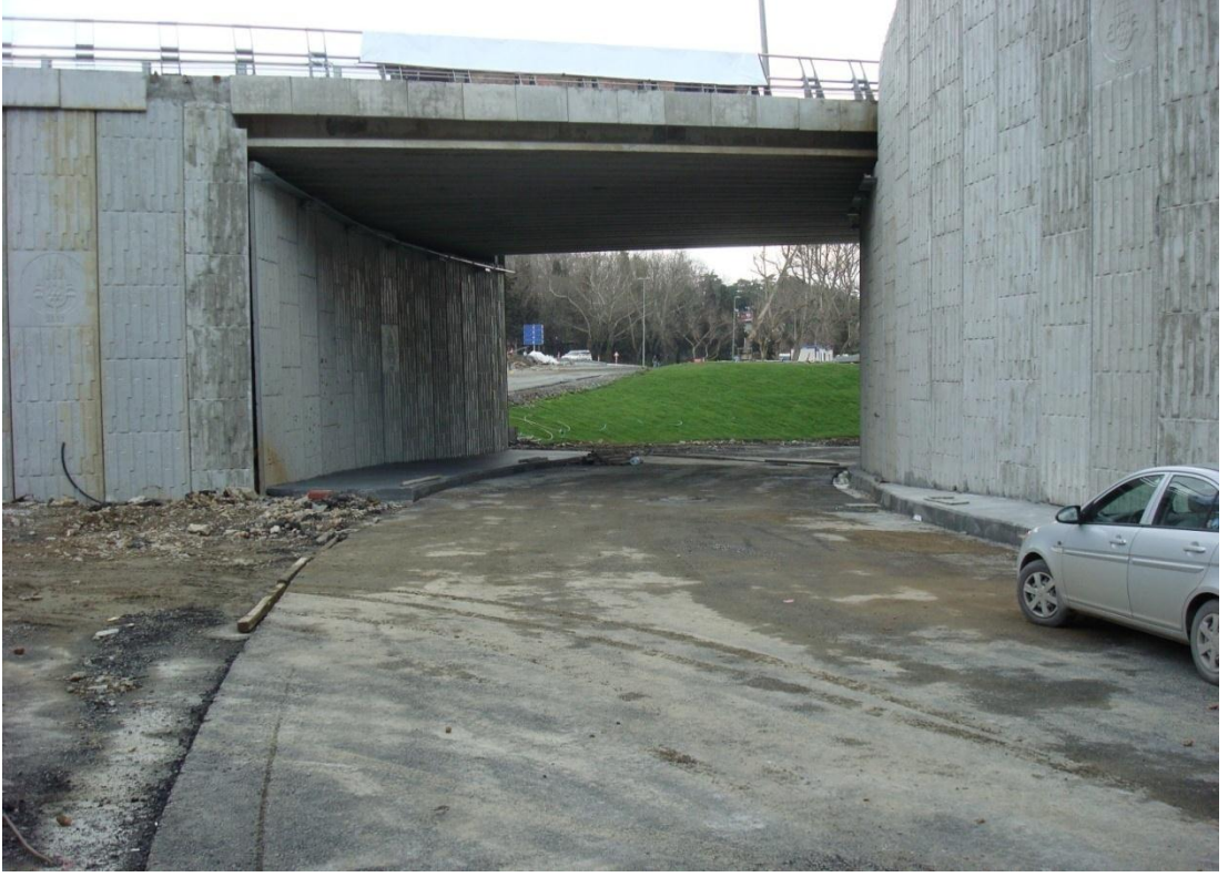
Şekil 6.28 Dolmabahçe tünel çıkış kolu-1 (önce).
