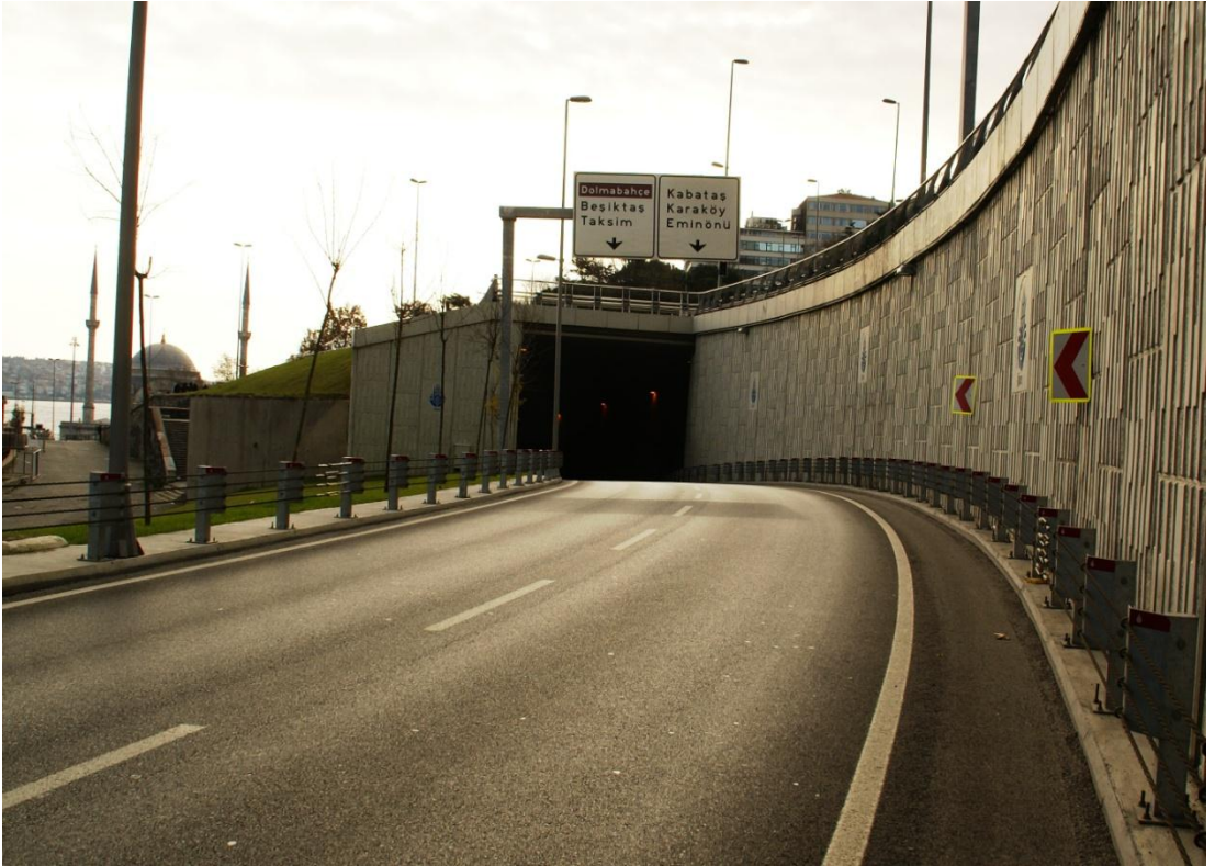
Şekil 6.31 Dolmabahçe tünel çıkış kolu-2 (sonra).
