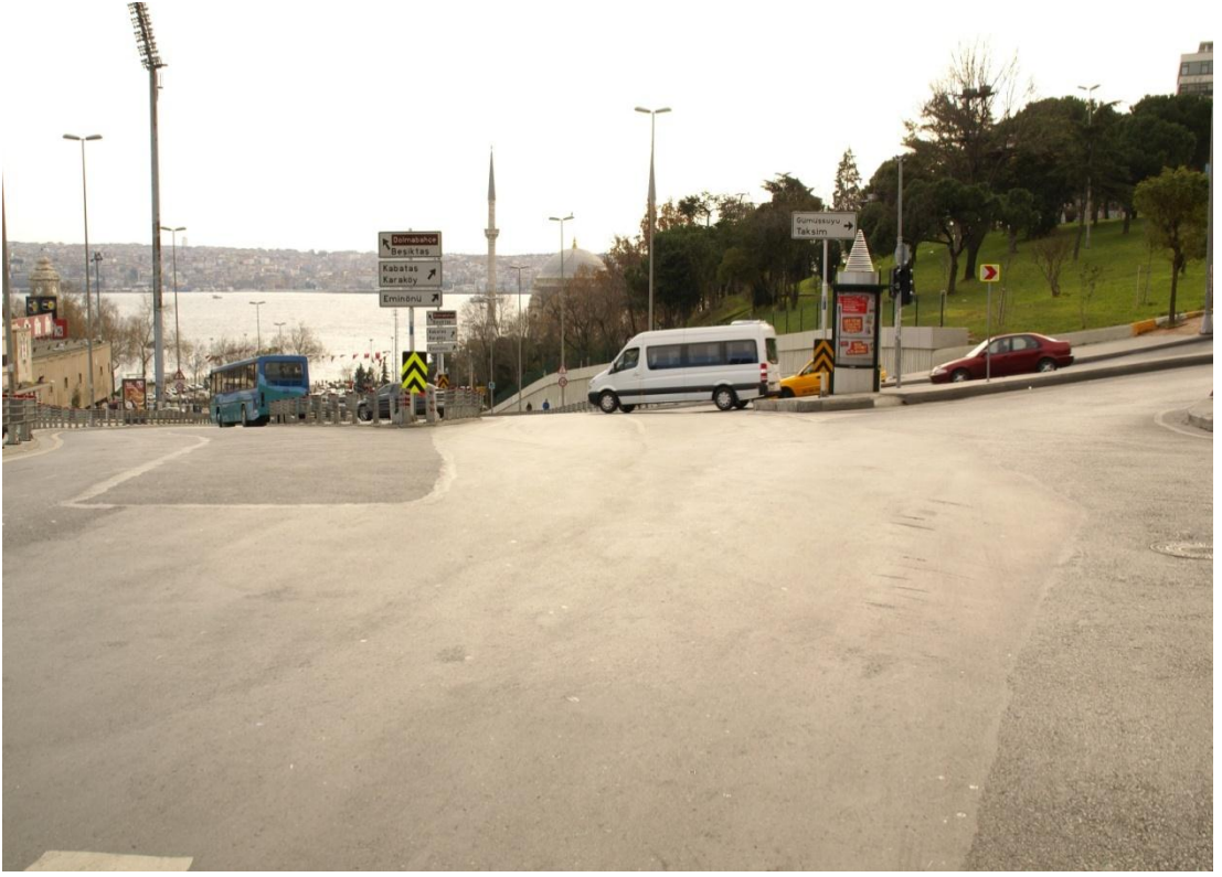
Şekil 6.24 Dolmabahçe Gazhane Caddesi Dolmabahçe inişi-3.
