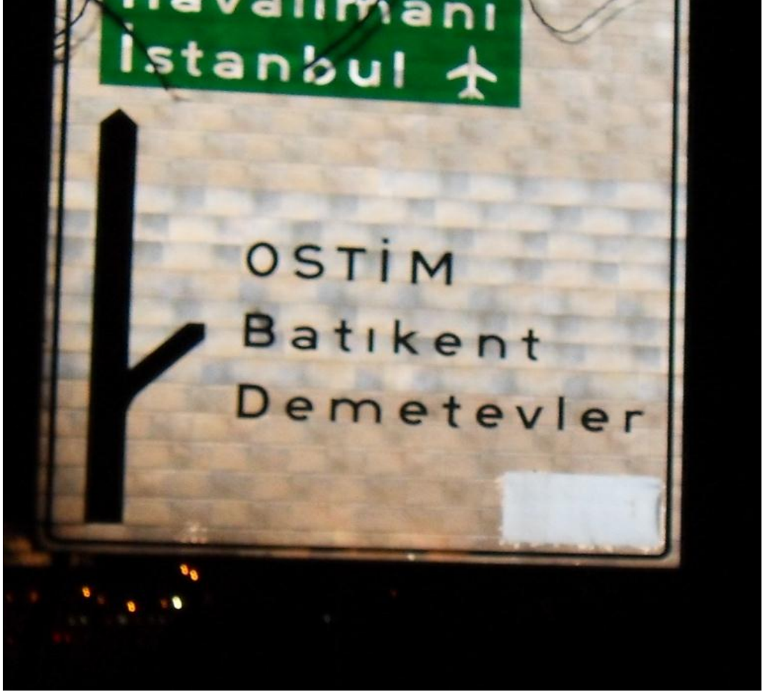
Şekil 5.3 Hatalı reflektif malzeme.
