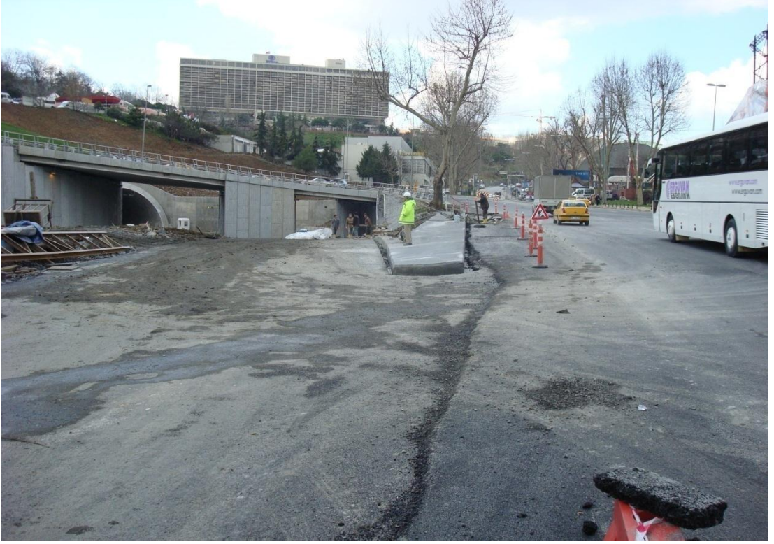
Şekil 6.12 Dolmabahçe tünel girişi ayrımı (önce).
