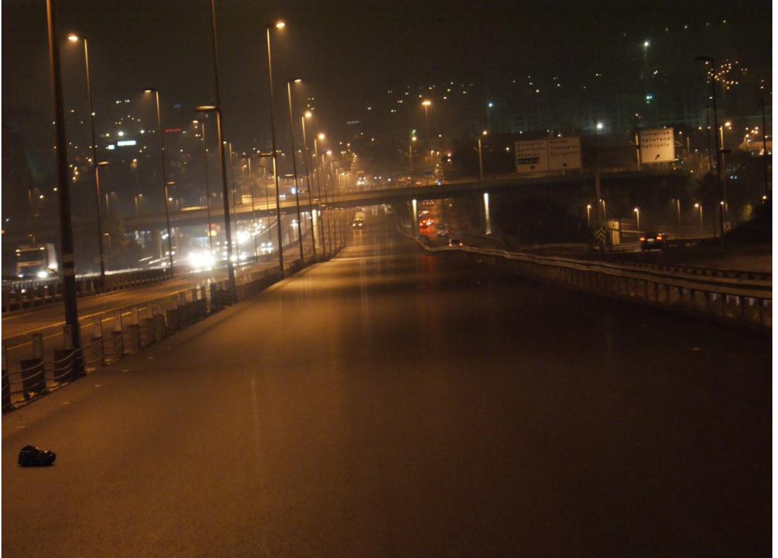
Şekil 3.3 Yatay işaretleme eksikliği.
