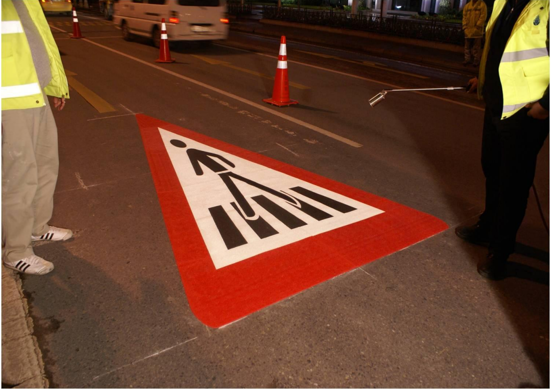
Şekil 4.18 Hazır trafik işareti ile yaya yaklaşım sembolü.
