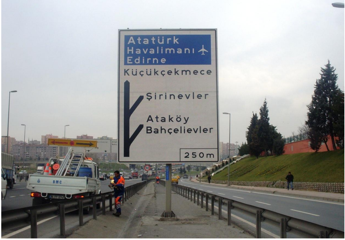
Şekil 5.7 Kavşak öncesi yön levhası (B-1a).
