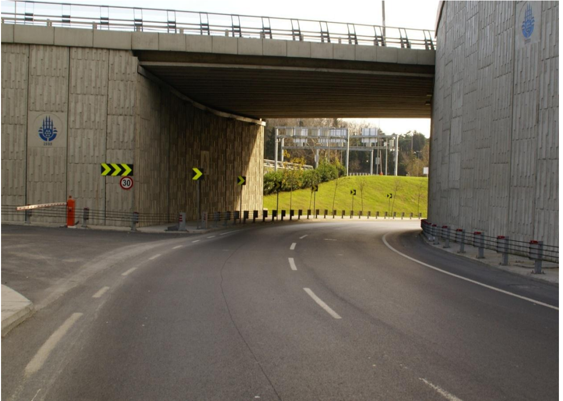
Şekil 6.29 Dolmabahçe tünel çıkış kolu-1 (sonra).
