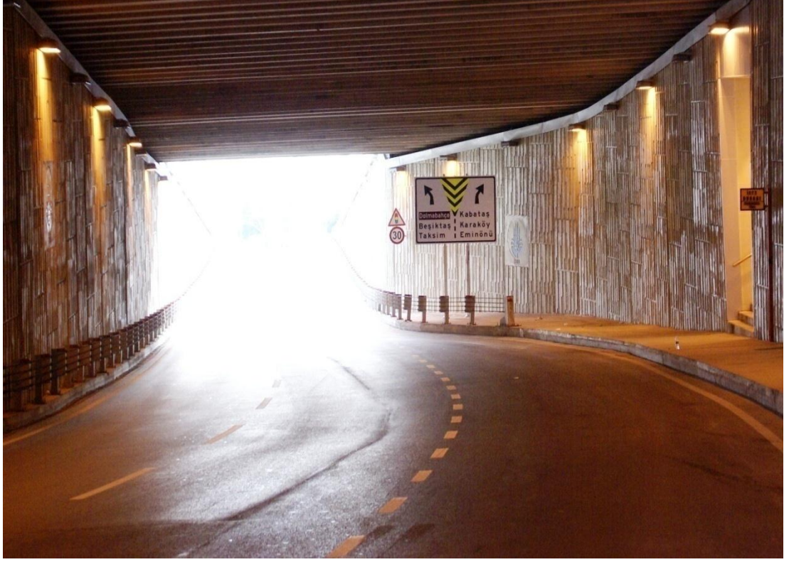
Şekil 6.32 Dolmabahçe tünel çıkış kolu-3.
