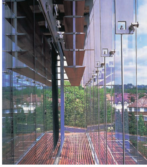
Şekil 4.18 Çift cephe sistemi ve bilgisayar kontrollü panjurlar
