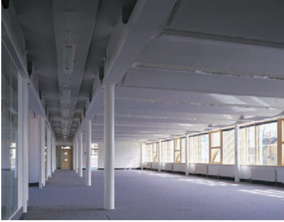
Şekil 4.22 Mekan ve döşemede bulunan beton kanallar
