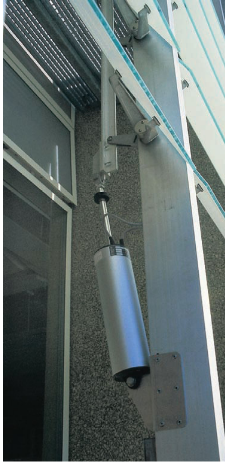
Şekil 4.24 Güneş kırıcıları hareket ettiren damperler
