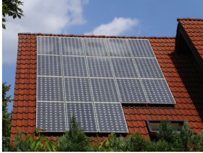
Şekil 3.4 Çatıya entegre edilmiş pv sistemi
