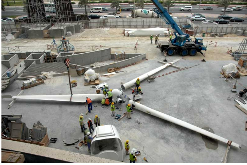
Şekil 4.27 Pervanelerin zeminde montajı
