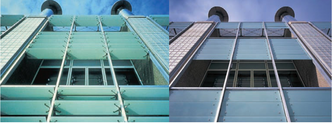
Şekil 4.23 Güneş kırıcıların açık ve kapalı durumu
