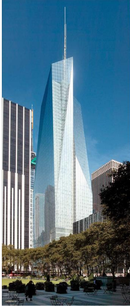
Şekil 4.31 Amerikan Bankası Kulesi genel görünüşü
