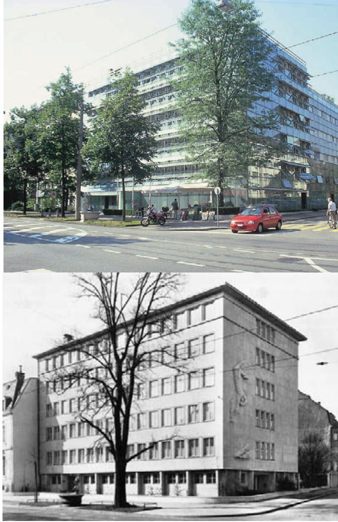
Şekil 4.5 Suva Sigorta Şirketi Binası'nın eski ve yeni durumu
