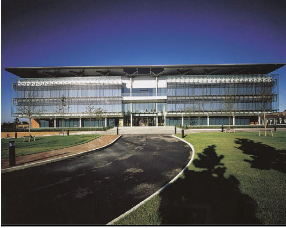
Şekil 4.17 GlaxoWellcome House West binası ön cephesi
