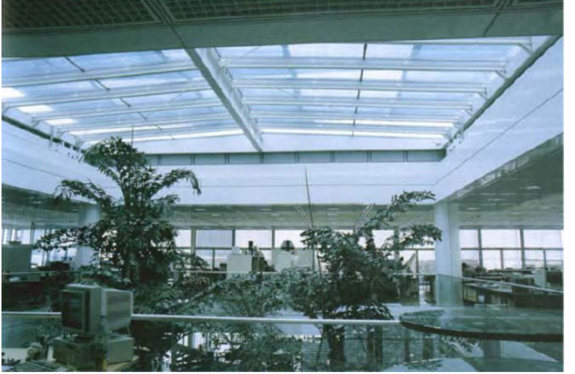
Şekil 4.14 Atriumun üzerinde bulunan ve açılıp kapanabilen cam çatı
