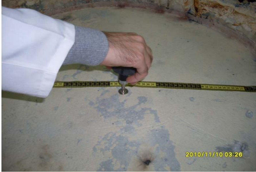
Şekil 5.11 DKK üretilecek zeminde cep penetrometresi ile mukavemet ölçümü
