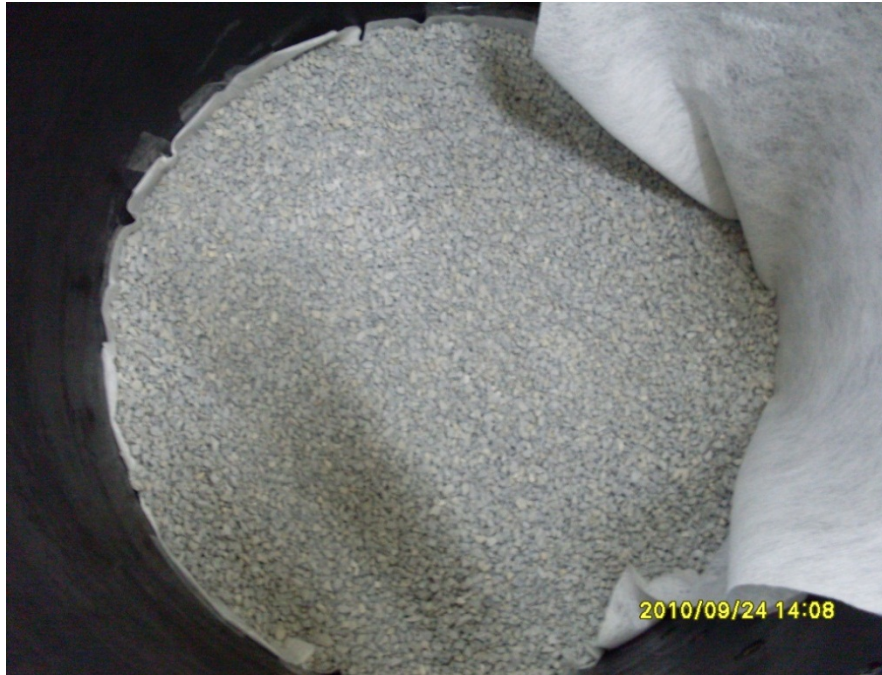
Şekil 5.9 Tank tabanına çakıl ve üzerine gotekstil filtre yerleştirilmesi
