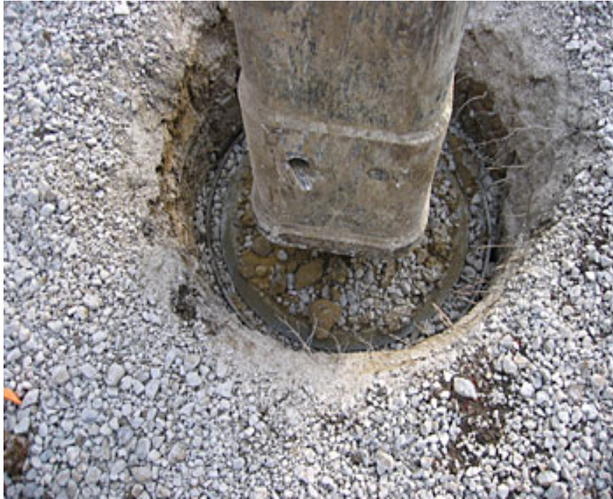
Şekil 3.4 Kolonun sıkıştırılması [20]
