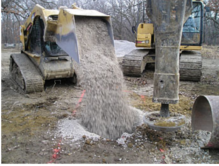
Şekil 3.3 Kırmataş kolon malzemesinin yerleştirilmesi [20]
