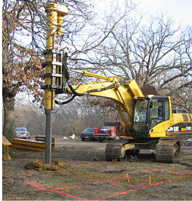
Şekil 3.2 Darbeli kırmataş kolonunun açılması [20]
