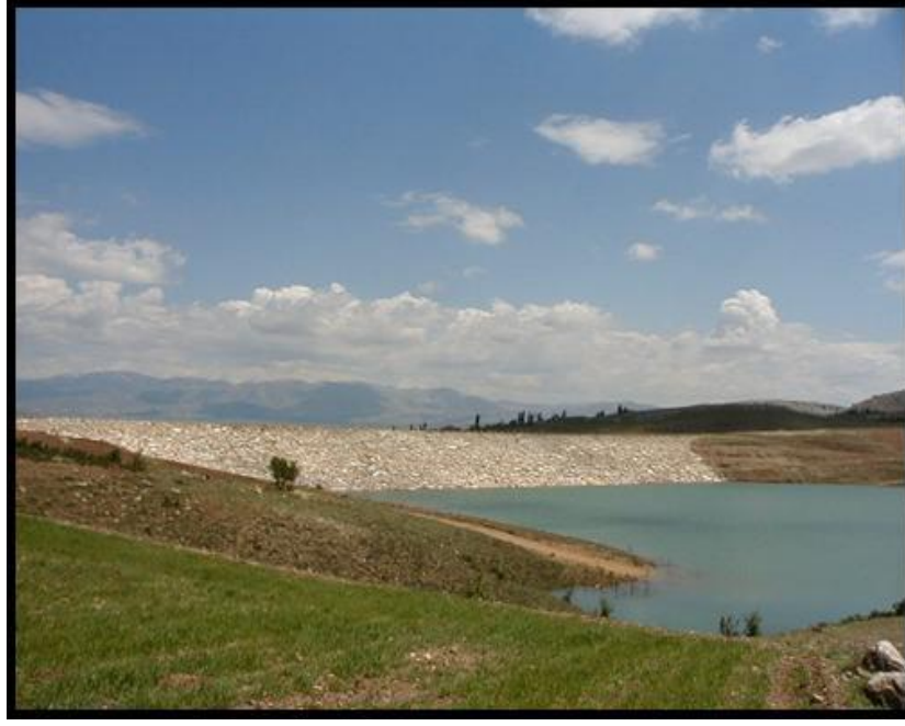
Şekil 4.24. Bademli Barajına ait bir görünüm ( www.dsi.gov.tr )
