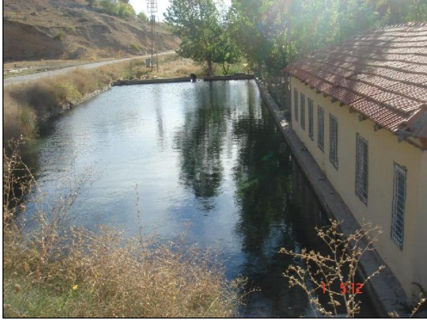
Şekil 4.114. Pınarbaşı sıcak su kaynağının boşalım havuzu ve çevresi
