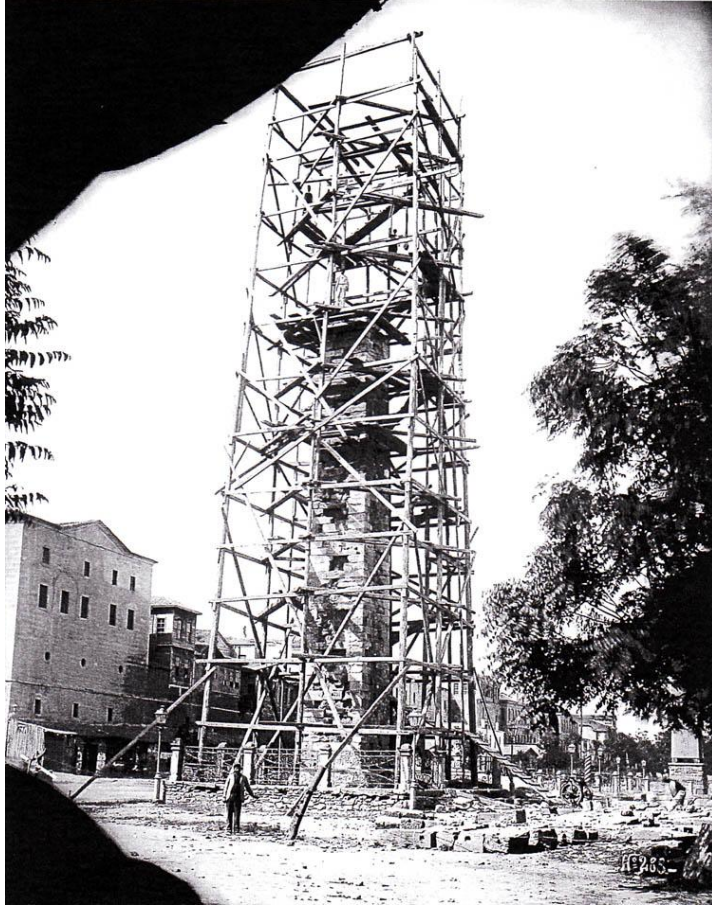
Şekil B.30: Örne Sütun'un restorasyonu, 1895-1896. (İ.T.S., 2010)
