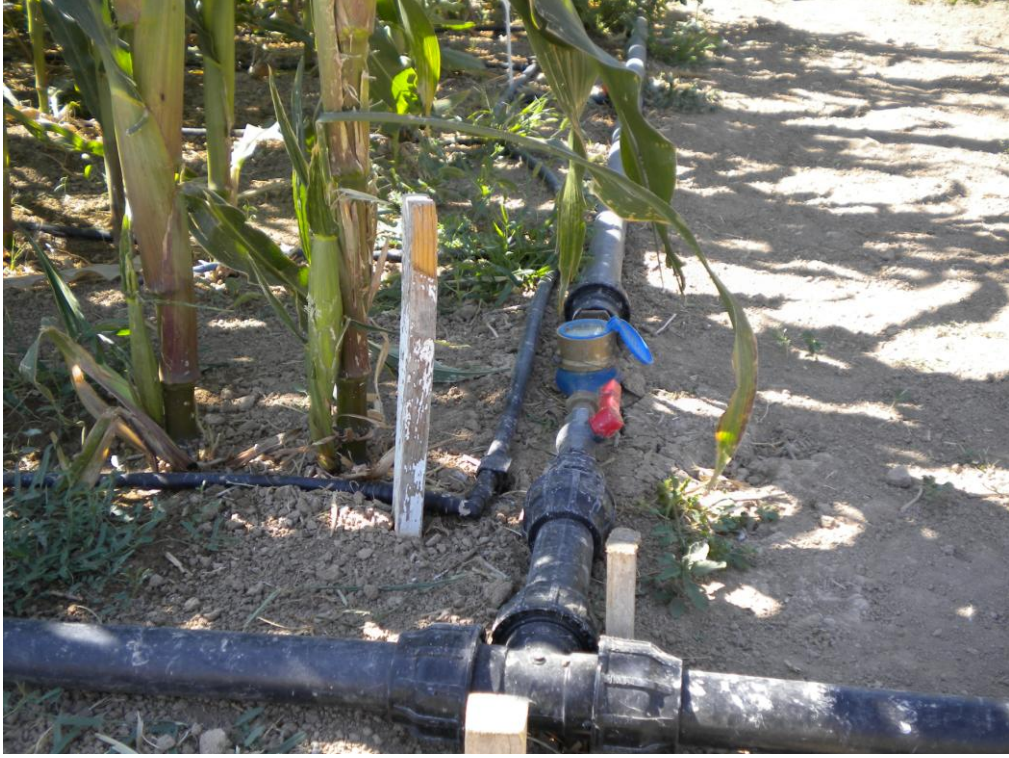
Şekil 3.3. Blok başlangıcındaki su sayacı ve küresel vana
