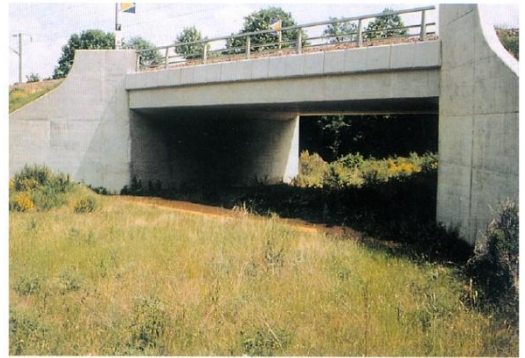
Şekil 1.6.b Orta büyüklükteki ve büyük hayvanlar için tasarlanmış altgeçit, Yüksek Hızlı Tren yolu alt geçidi, Fransa (Iuell vd. 2003)
