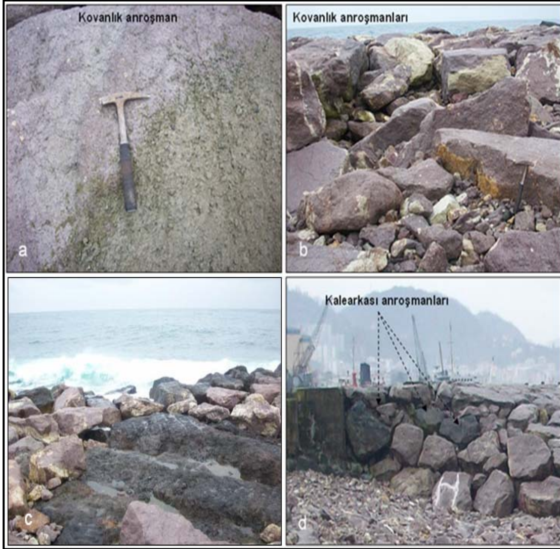
Şekil 4.12 a. Kovanlık anroşmanlarında killeşme, b. ufalanma c. Kalearkası ve Kovanlık anroşmanları d. 1999 fırtınasından sağlam kalan anroşmanların genel görünümü
