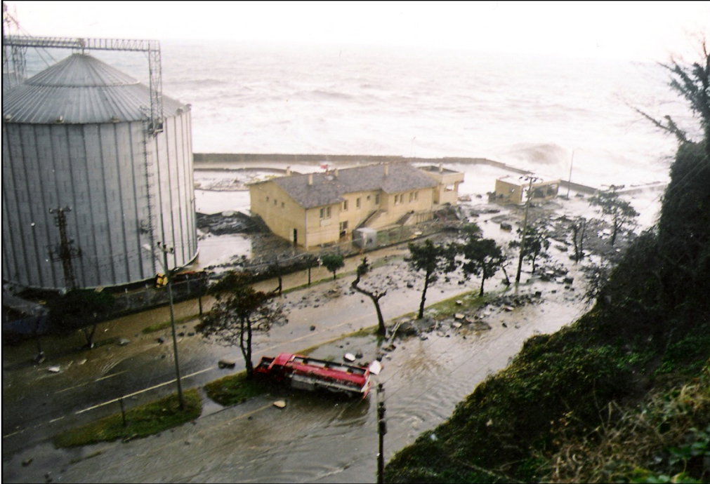
Şekil 1.4 20 Şubat 1999 fırtınasında Giresun Limanı'nın görünümü ve hasar durumu, kuzeydoğu'ya bakış (Yetgin, 2005)
