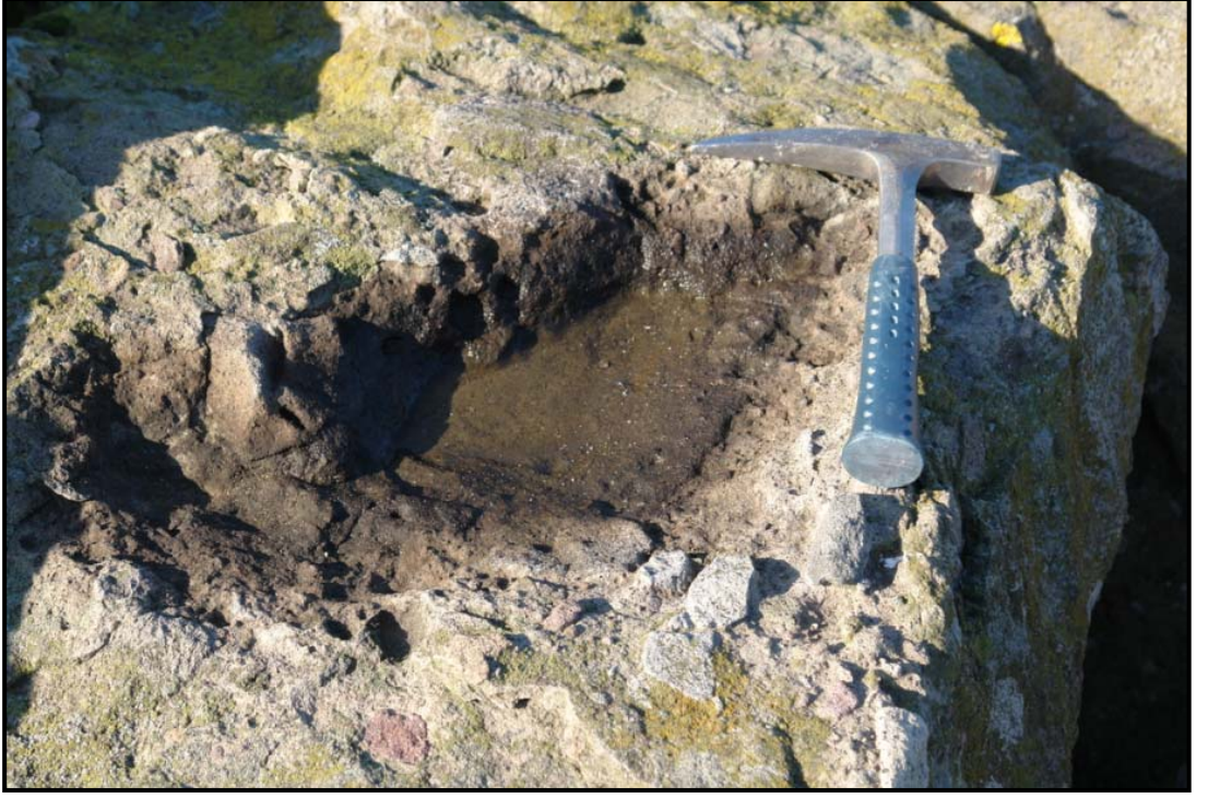
Şekil 4.17 Trabzon Limanı'nda kullanılan aglomeralarda ayrışma ve yıkanma
