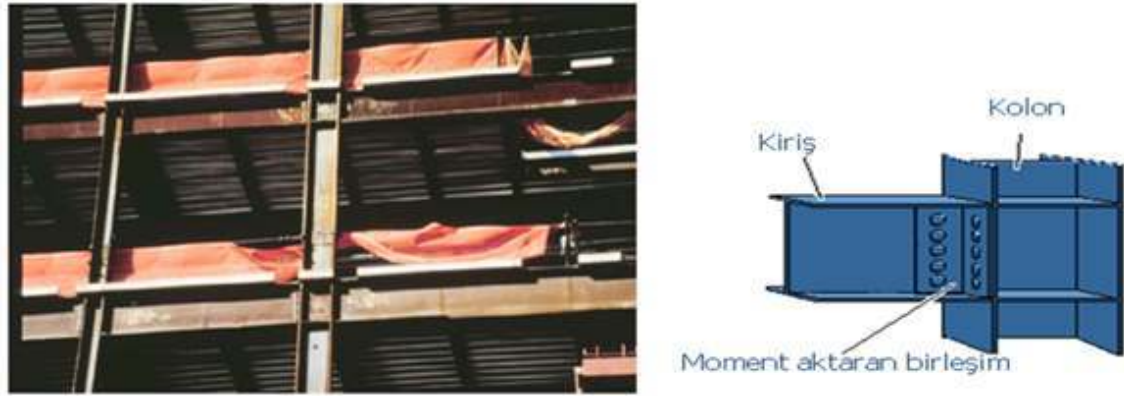
Şekil 4.3 Moment aktaran çerçeve sistemler (Kıymaz, 2003)
