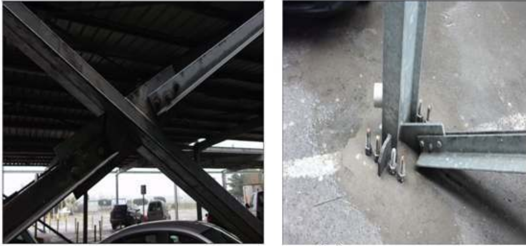
Şekil 4.9 X merkezi çaprazlı sistem
