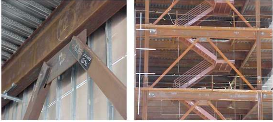
Şekil 4.8 V şeklindeki çelik çaprazlı sistem (Kıymaz, 2003)
