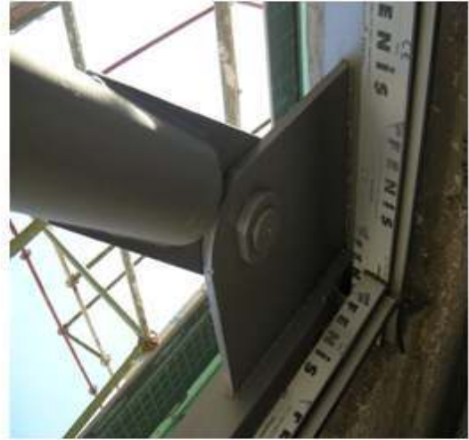
Œekil 6.4 a) Binaya eklenen  elik  aprazın dıŒtan g r n Œ , b) X  elik  aprazın baęlantı detayı
