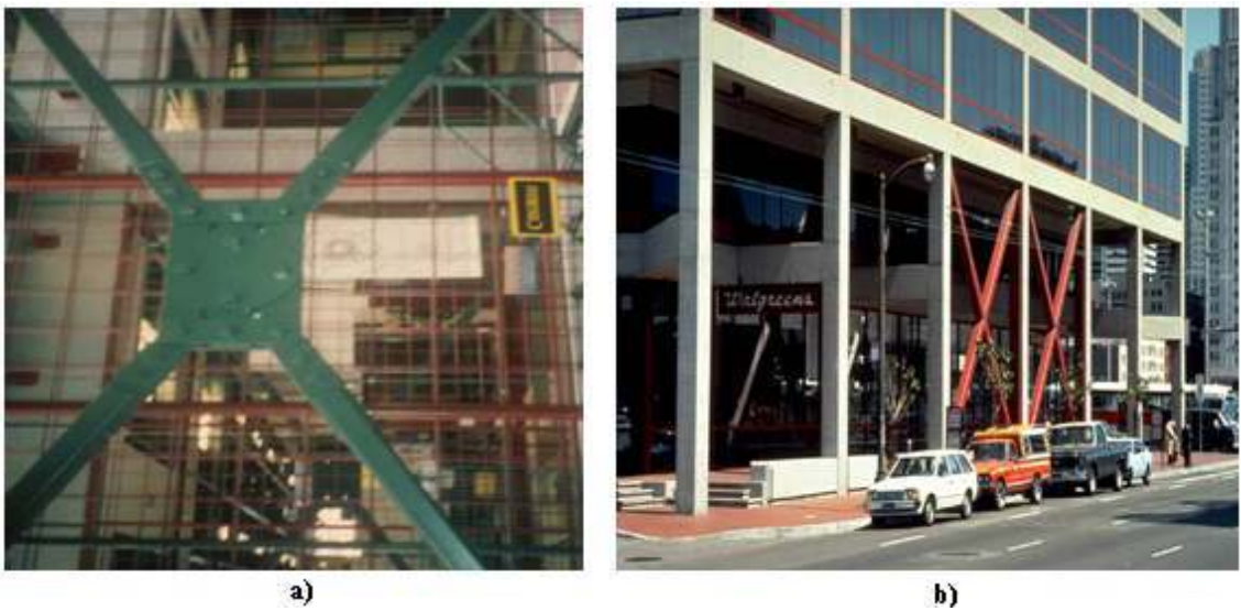
Şekil 6.3 a) X çapraz elemanın betonarme yapıya bağlantısı (Aiken, et al, 2006), b) Oluşan yumuşak katın merkezi çapraz sistem ile güçlendirilmesi (Kıymaz, 2003)
