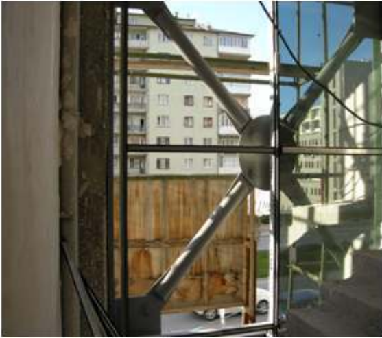
Œekil 6.4 a) Binaya eklenen  elik  aprazın dıŒtan g r n Œ , b) X  elik  aprazın baęlantı detayı
