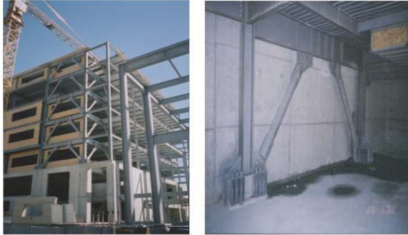
Şekil 4.11 Çapraz bağlantı detayı; a)Tipik dış merkez çapraz bağlantı detayı, b)Dış merkez ters V çaprazın birleşim detayları (Kıymaz, 2003)
