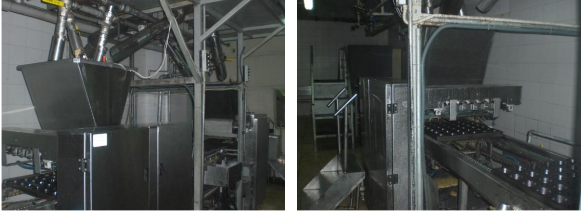
Şekil 4.13. 2. Hat depozitörü sırasıyla önceki ve sonraki durumu
