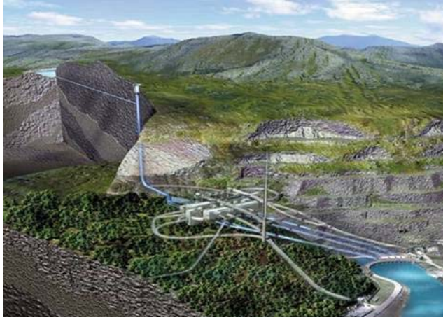
Şekil 4.7 : Dinorwig pompajlı santralinin görünümü
