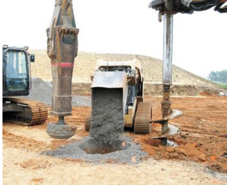
Şekil 3.4 Kırmataş kolon malzemesinin yerleştirilmesi [22]
