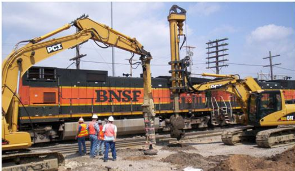
Şekil 3.2 Darbeli kırmataş kolonun açılması[22]
