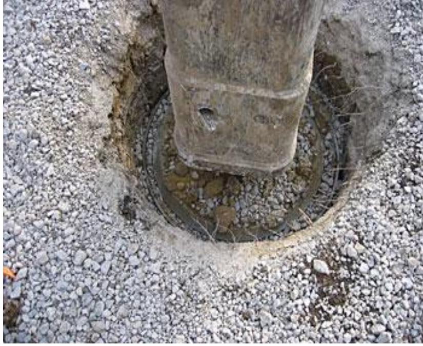
Şekil 3.5 Darbeli kırmataş kolon sıkıştırılması [22].
