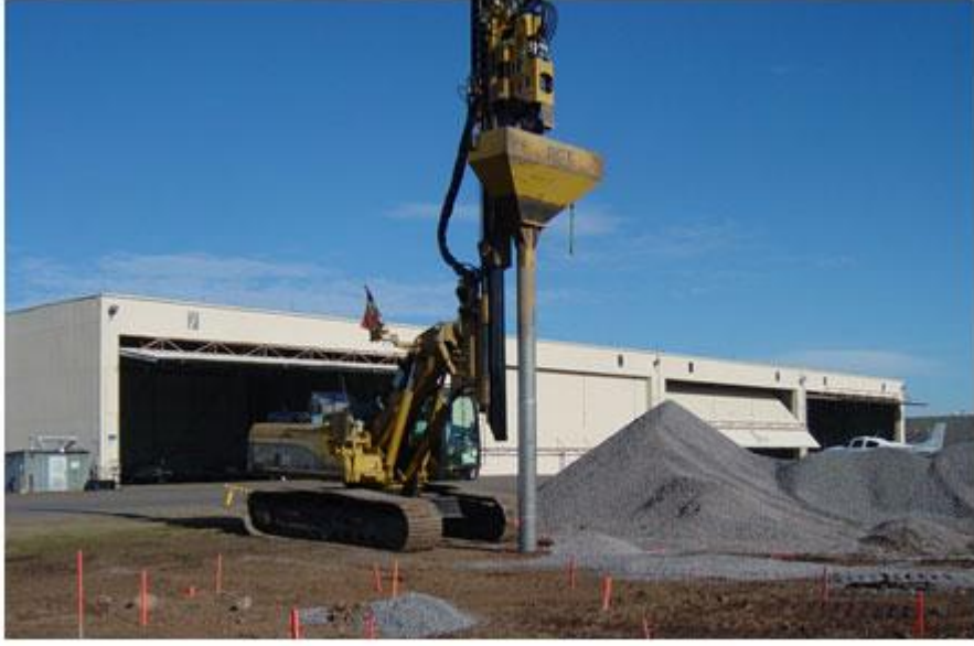
Şekil 3.3 Kılıf yardımıyla darbeli kırmataş kolon açılması [22]
