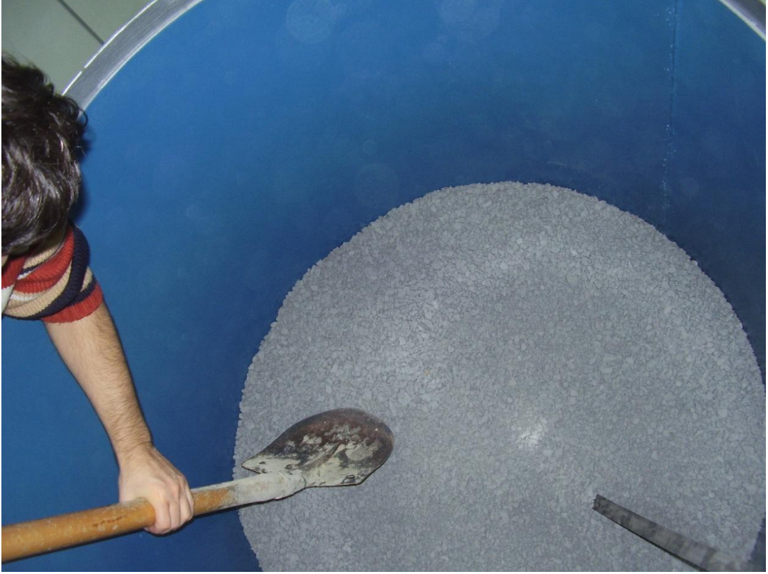
Şekil 5.10 Tank tabanına çakıl ve üzerine geotekstil filtre yerleştirilmesi
