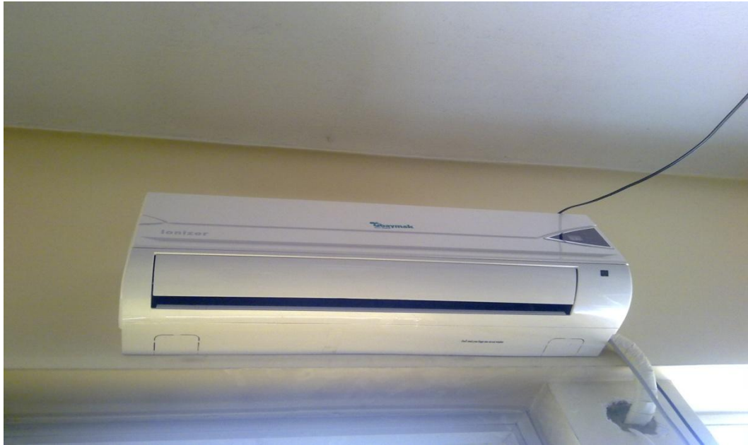
Şekil 3.30: Baymak Elite 09 Chs Duvar Tipi Split Klima
