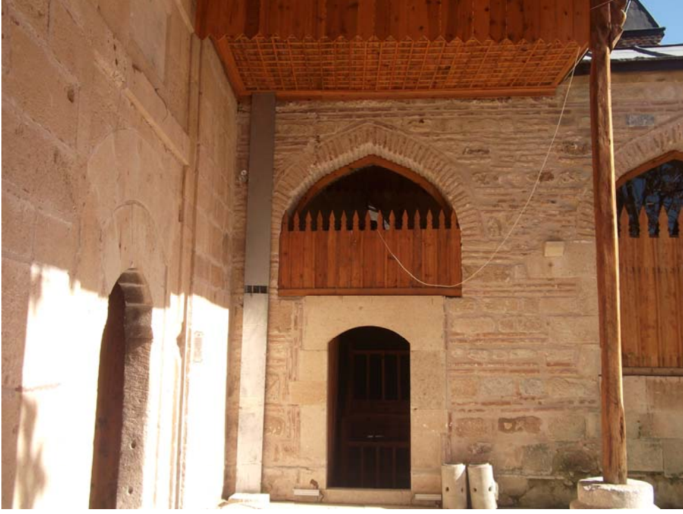
Resim 51: Bektaşî Dergahı Batı Cephe
