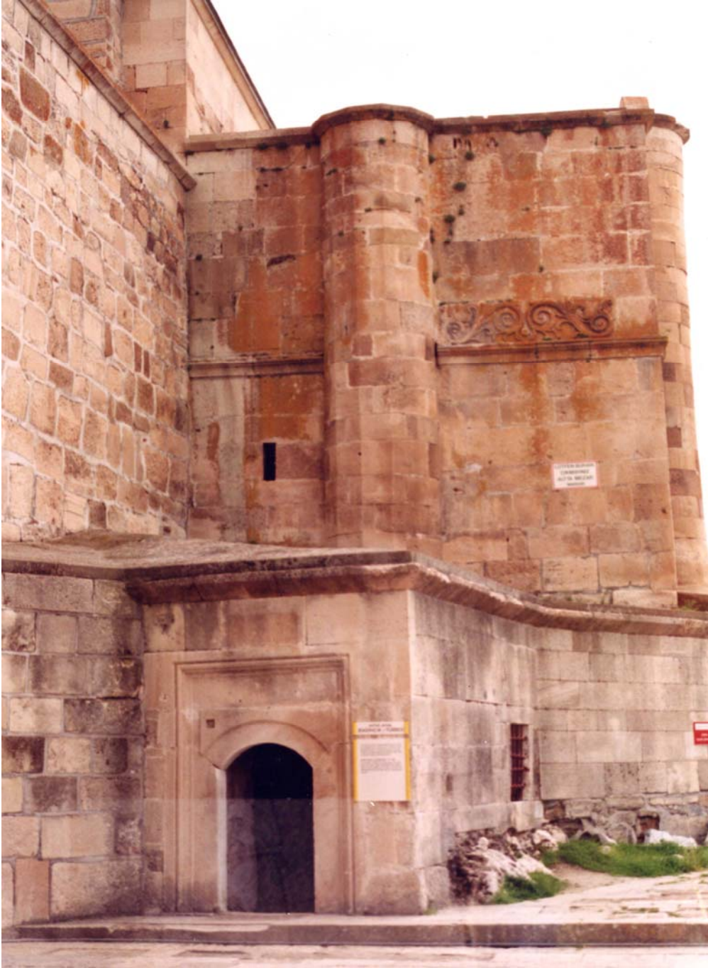
Resim 14: Kadıncık Ana Türbesi Doğu Cephesi
