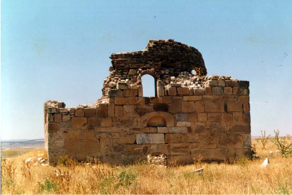
Resim 86: Yılkırkan Türbesi Kuzey Cephe Görünüşü
