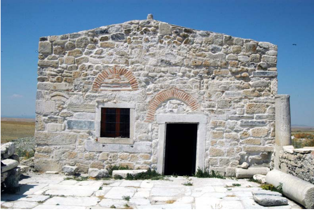
Resim 78: Doğançayır, Melek Gazi Türbesi Doğu Cephe Görünüşü
