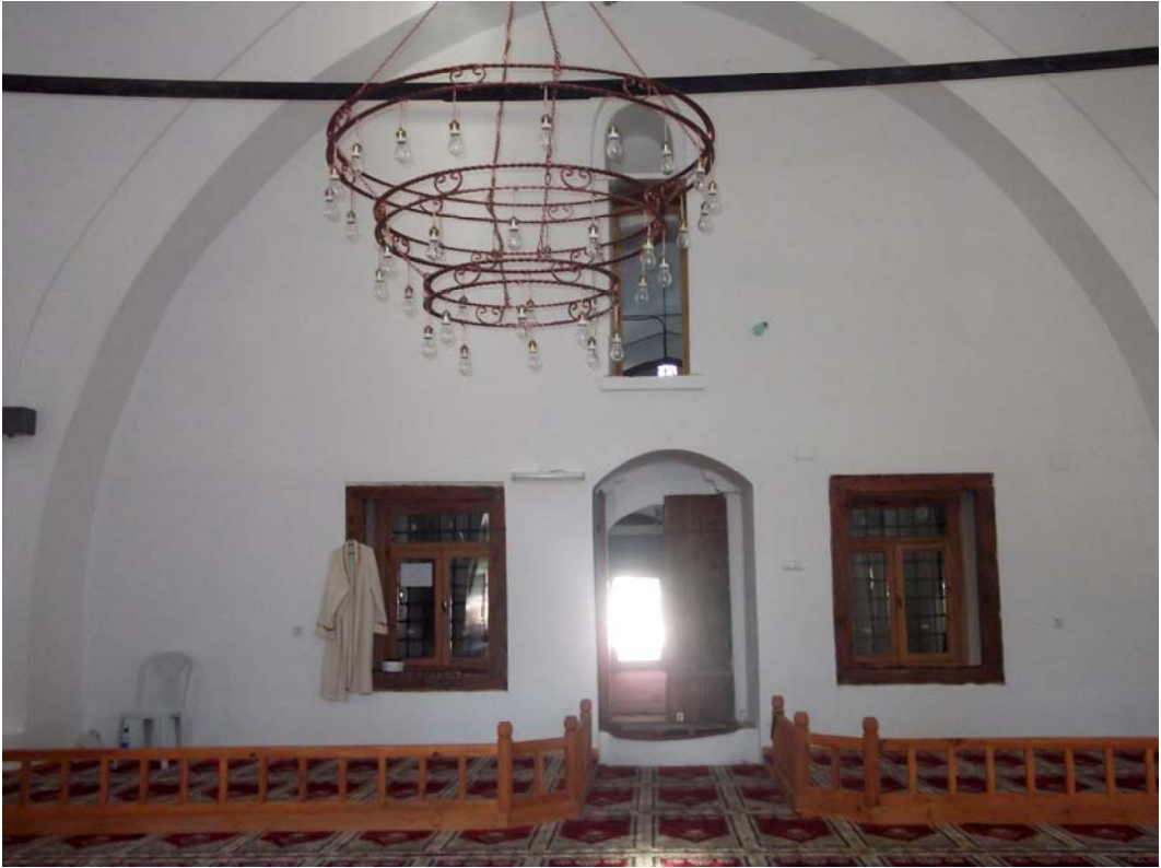
Resim 36: Seyyid Battal Gazi Cami İç Kısım Güney Duvarı
