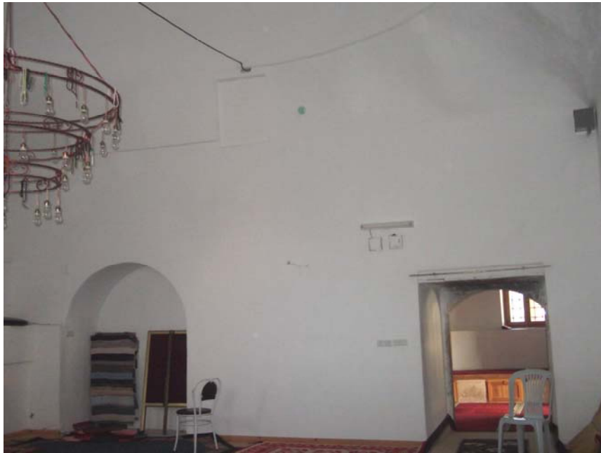
Resim 45: Türbedar Odası İç Mekan
