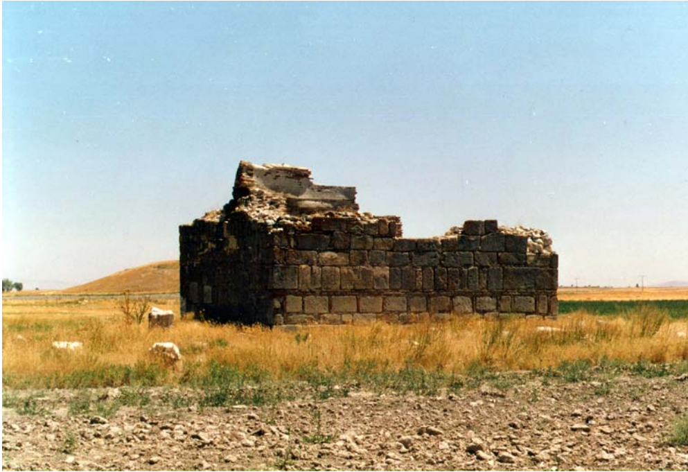
Resim 88: Yılankırkan Türbesi Batı Cephesi Görünüşü
