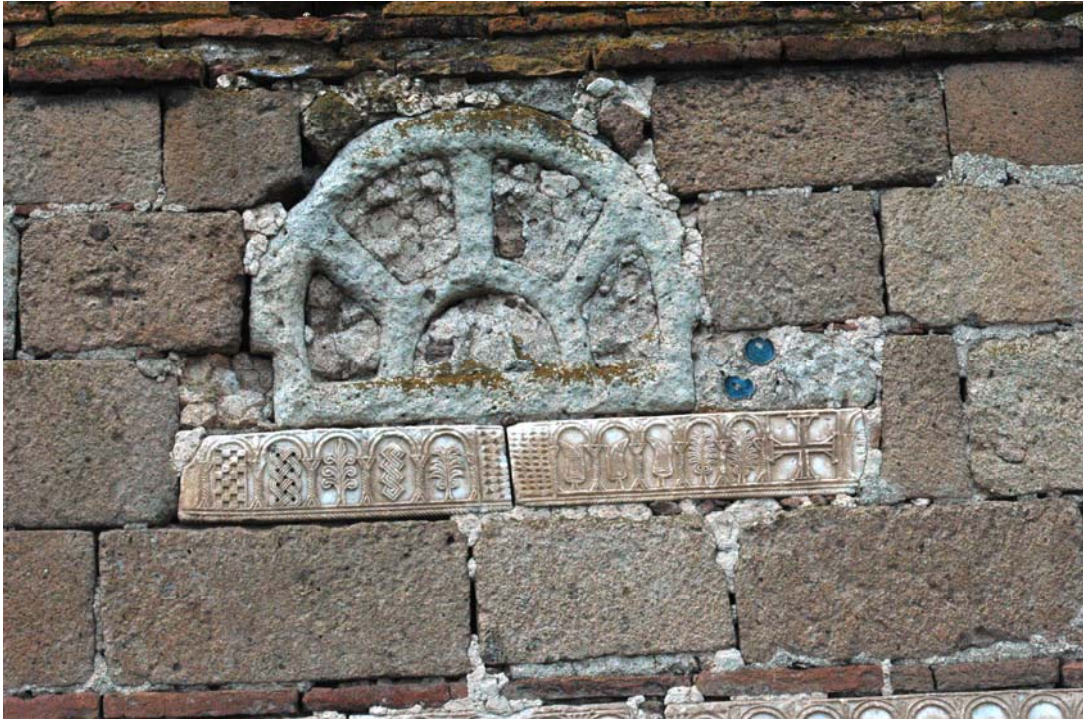
Resim 70: Himmet Baba Türbesi Pencere Detayı
