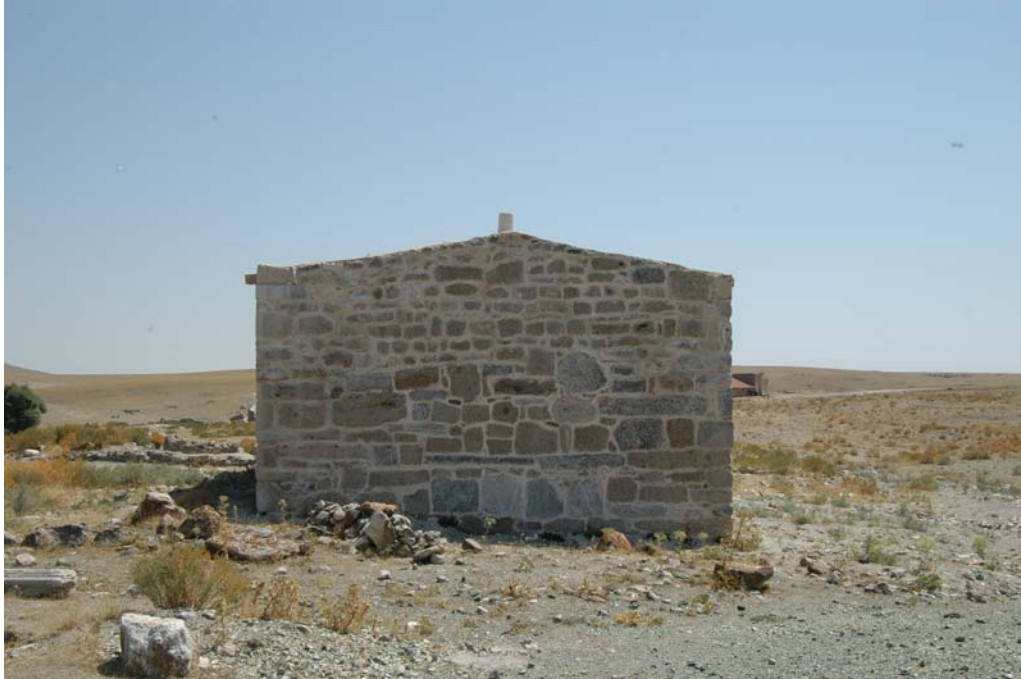
Resim 80 : Doğançayır, Melek Gazi Batı Cephesi Görünüşü
