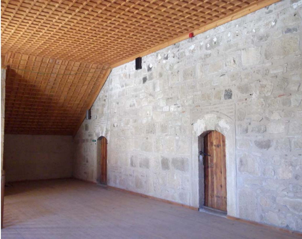
Resim 52: Bektaşî Dergahı Tavan Detayı
