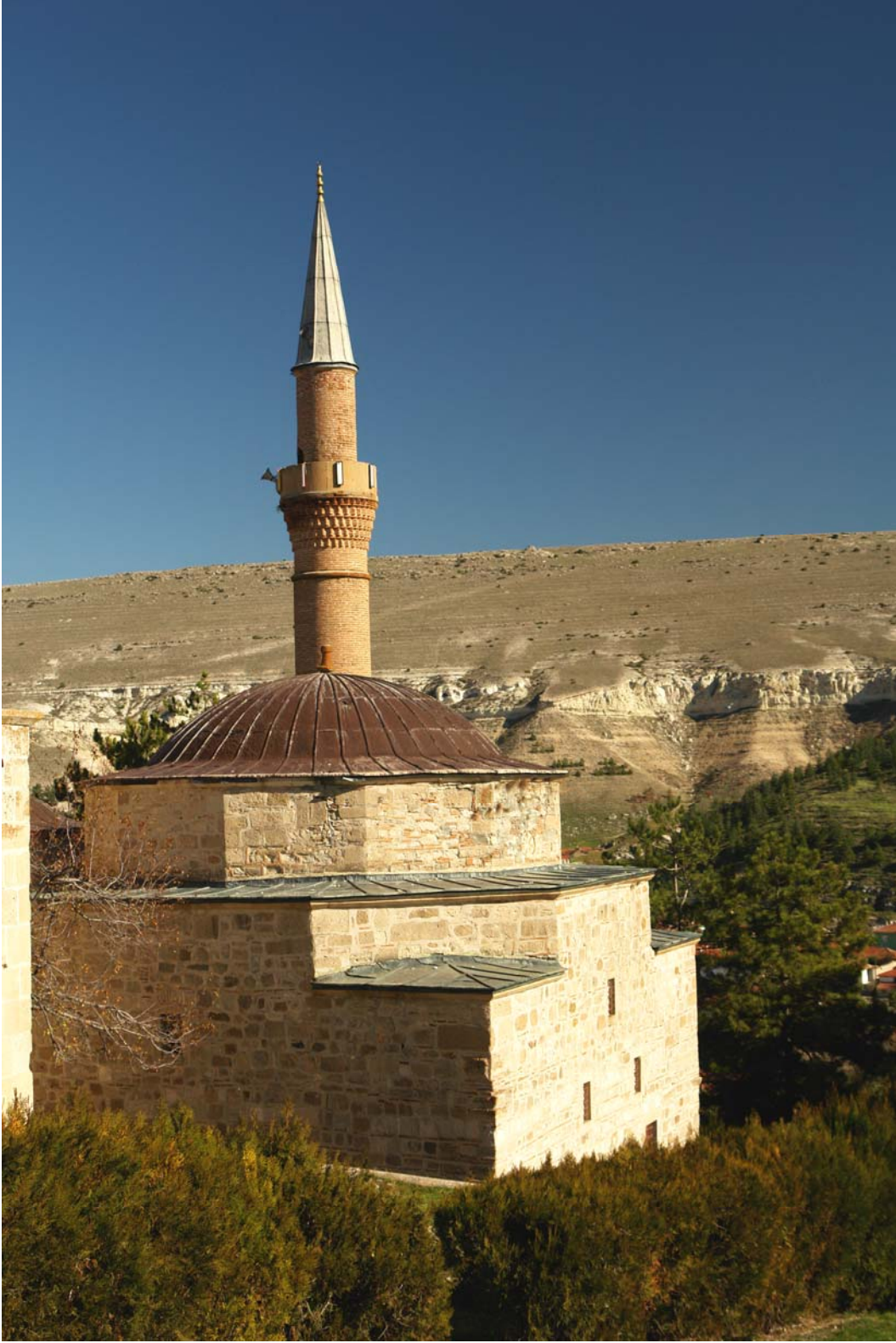
Resim 31: Seyyid Battal Gazi Cami Güneybatı Görünüşü
