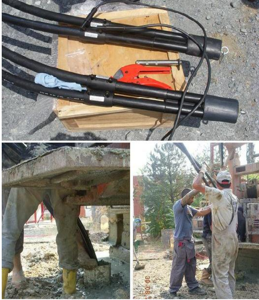
Şekil 6.3 YYEE DTKIP Toprak devresinin sondaj ve yerleştirme çalışmaları
