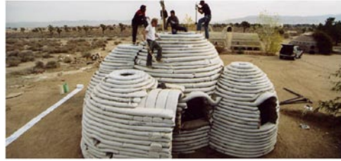
Şekil 2.12 : Kum torbasından toprak dış duvar sistemi yapımı (Du Pisanie, 2009)
