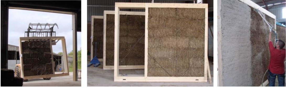
Şekil 2.14 : Saman balyasının taşıyıcı olmadığı, prefabrike dış duvar sistemi (Beadle ve diğ., 2009)
