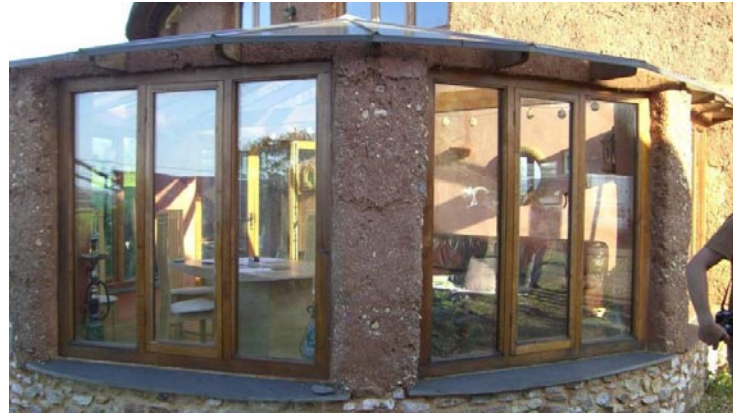
Şekil 2.10 : Yığma kerpiç sistem ile yapılmış bir kış bahçesi, Devon, Birleşik Krallık (Kaya, 2009)
