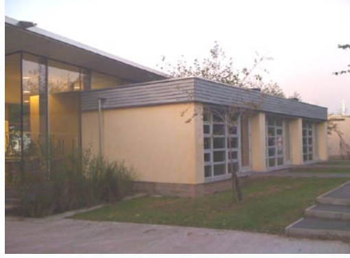
Şekil 2.11 : Dövme kerpiç sistem ile yapılmış deneme bilim merkezi, Genesis Building, Taunton, Birleşik Krallık (Kaya, 2009)
