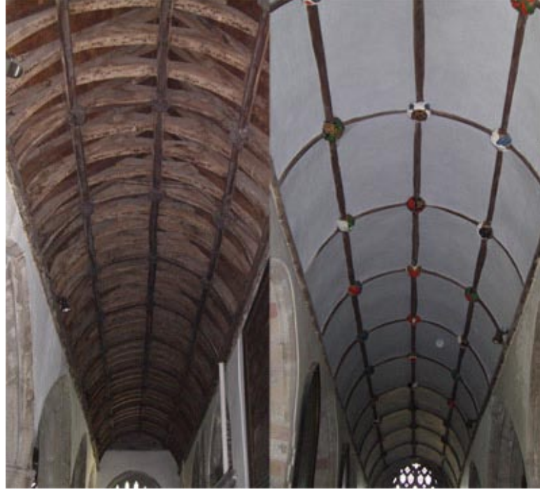
Şekil 2.9 : Omurgalı kerpiç sistem ile yapılmış bir çatı sistemi, Devon, Birleşik Krallık (Kaya, 2009)
