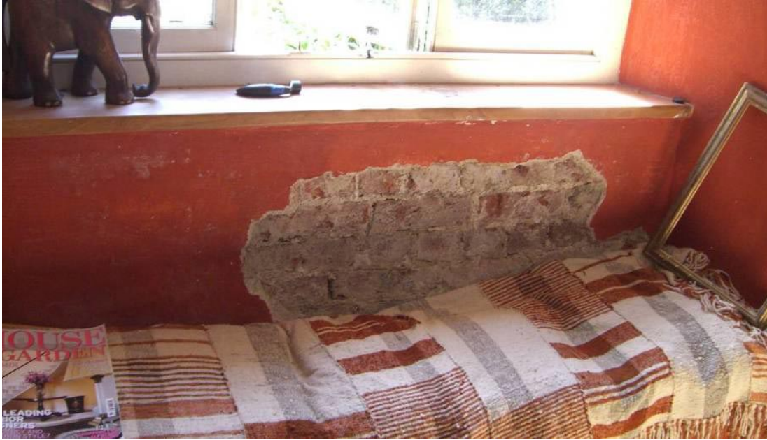
Şekil 2.8 : Blok kerpiç ile örülmüş bir dış duvar sistemi, Devon, Birleşik Krallık (Kaya, 2009)
