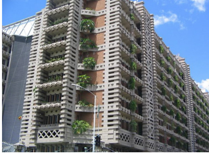
Şekil 3.7 – Zimbabve’deki Eastgate Binası
