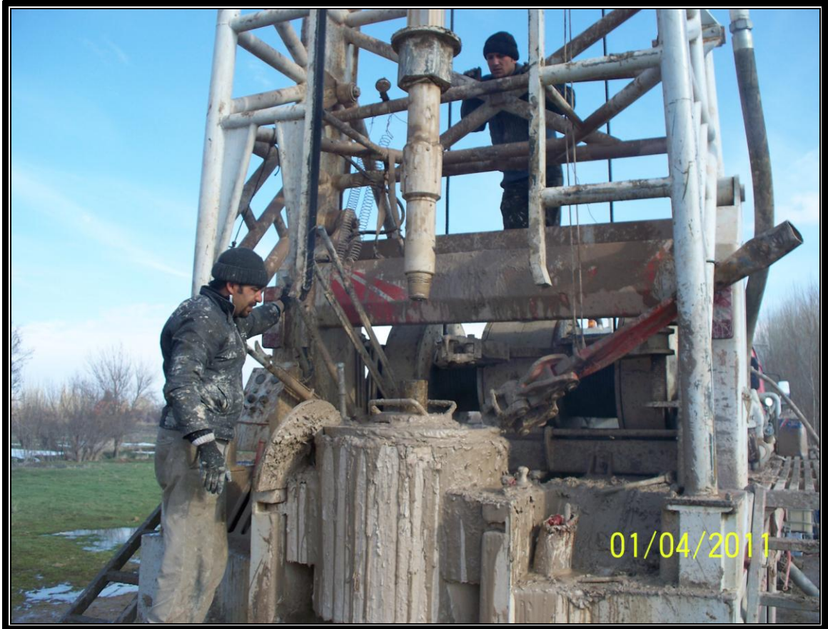
Fotoęraf 2.5 Vin sistemiyle tijlerin kuyudan ıkarılması
