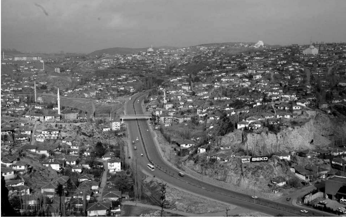
Şekil 6.3 Kuzey Ankara Kentsel Dönüşüm Alanı uygulama öncesi görünümü.
