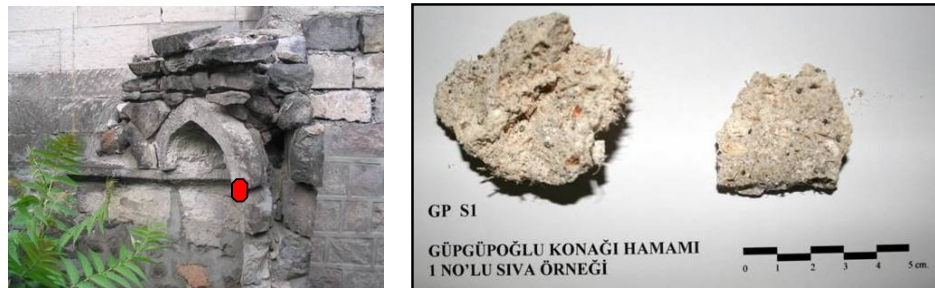
Şekil 4.95 : GP S1 numaralı sıva harcı örneği.
