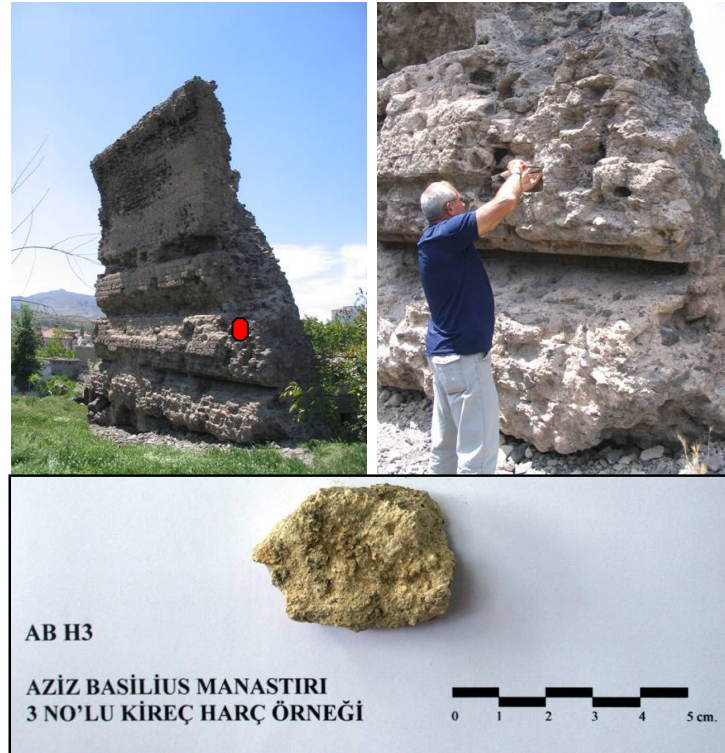
Şekil 4.37 : AB H3 numaralı duvar örgü harcı örneği.
