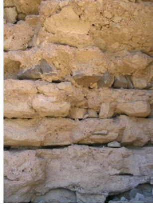
Şekil 4.30 : KP H4 numaralı duvar örgü harcı örneği.
