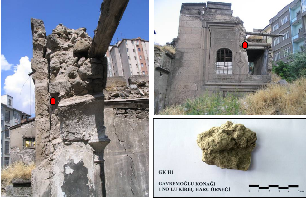
Şekil 4.63 : GK H1 numaralı duvar örgü harcı örneği.
