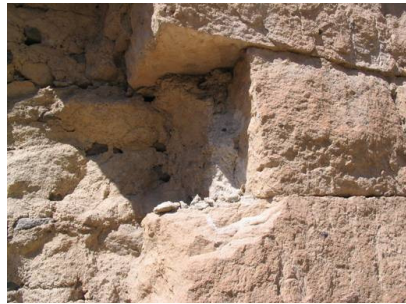
Şekil 4.30 : KP H4 numaralı duvar örgü harcı örneği.
