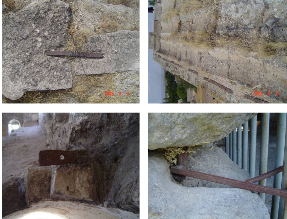
Şekil 4.3 : Kenetlerin duvar içerisinde kullanımına 19. yüzyıl Kayseri kiliselerinden örnekler (Fotoğraf: Şeyda Güngör Açıköz).
