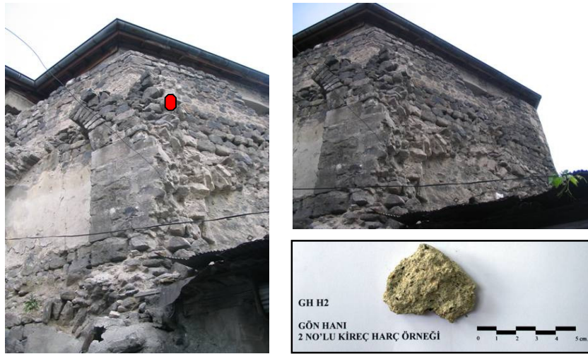
Şekil 4.60 : GH H2 numaralı duvar örgü harcı örneği.
