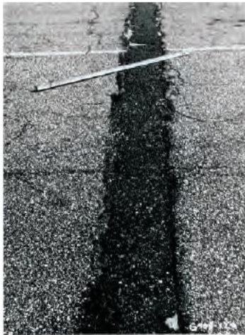
Şekil 3.34. Orta ve yüksek derecede yama oluşumu (UFC, 2001)
