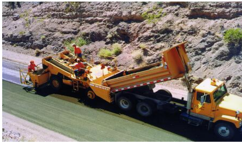
Şekil 3.84. Kum Kaplama Uygulaması (AASHTO, 1986)
