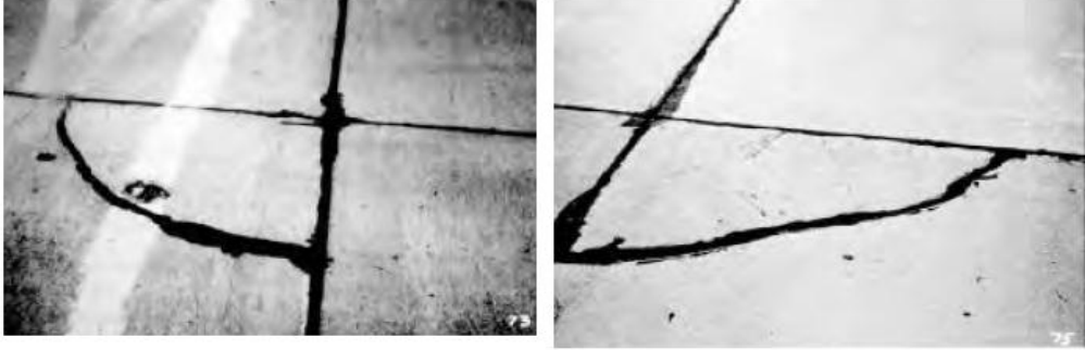
Şekil 3.46. Düşük ve orta derecede köşe kırıkları (UFC, 2001)
