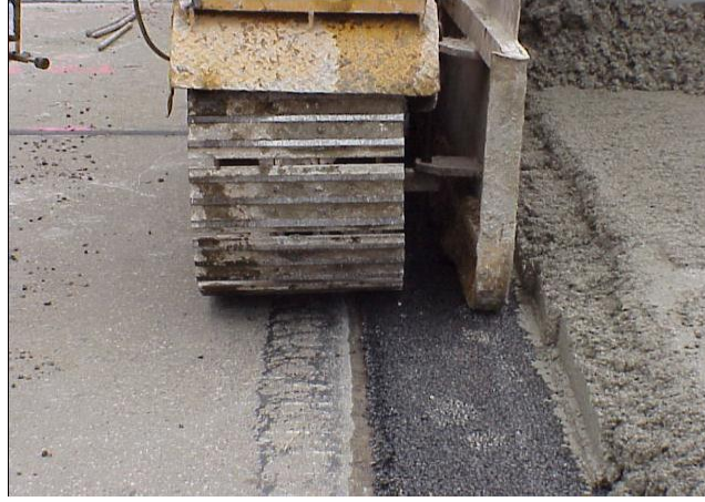
Şekil 3.75. İnce BSK serilmesinden sonra PCC takviye tabakasının serilmesi (Anonim)
