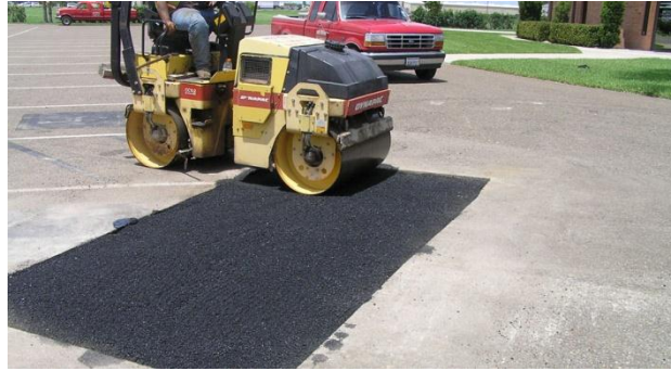
Şekil 3.81. Kompaktör ile sıkıştırma
