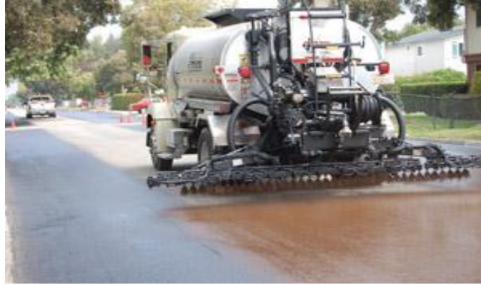
Şekil 3.82. Püskürtme Uygulaması (SHRP, 1993)
