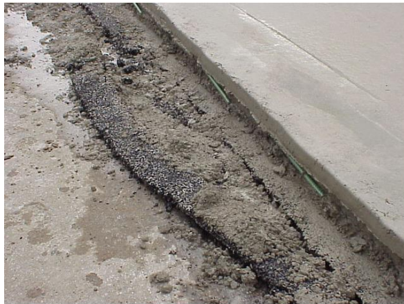
Şekil 3.76. PCC Takviye Tabakasının serilmesinden sonraki durum (Anonim)
