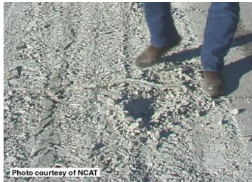
Şekil 3.72. Çatlat sıkıştır metodunun uygulanışı (Anonim)
