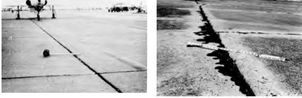
Şekil 3.60. Düşük ve orta derecede bankette şerit boyu oturma ve ayrılmalar (UFC, 2001)
