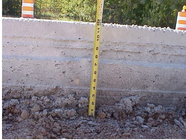
Şekil 3.77. Uygulanan PCC Takviye Tabakasının yüksekliği (30 cm) (Anonim)
