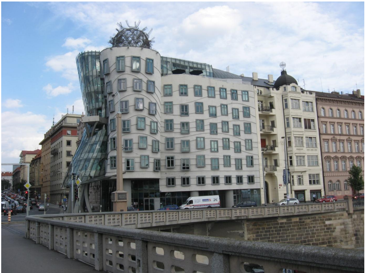
Resim 71: 'Nationale- Nederlanden Building', Frank Gehry
