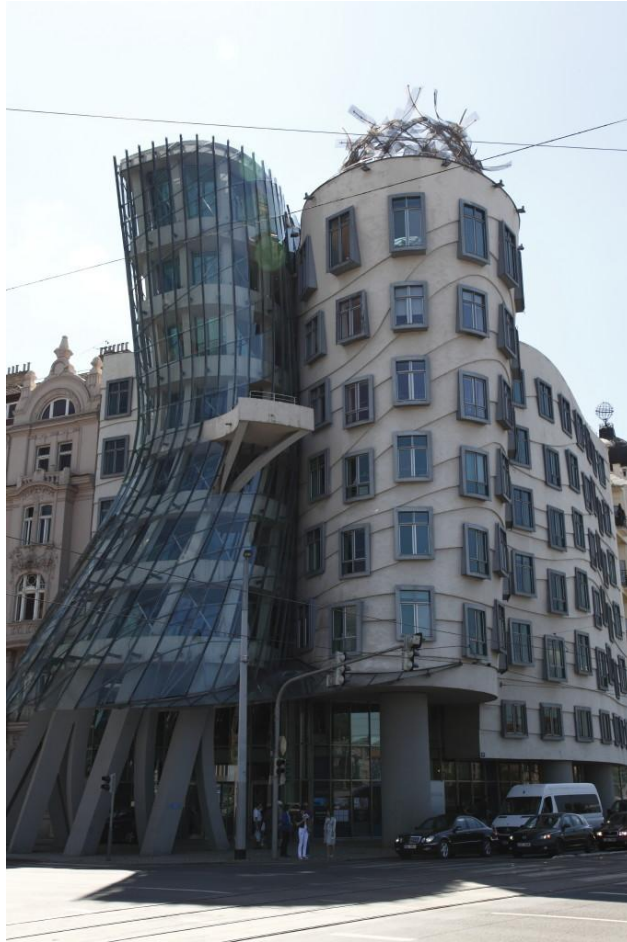
Resim 72: 'Nationale- Nederlanden Building', Frank Gehry
