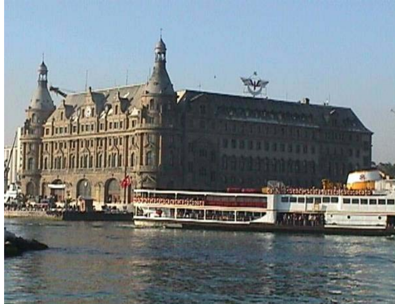
Şekil 3.17 Haydarpaşa Garı Denizden Görünüm, (Url-9).
