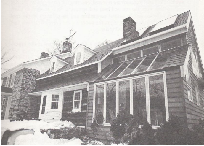
Şekil 2.20. : Yalıtılmış ısı kazanım sistemi: Güneş odası uygulama örneği [45]
